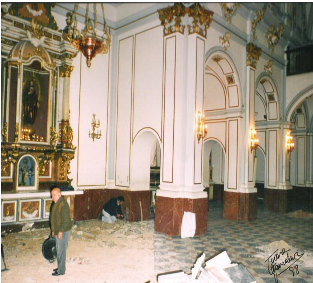
Momento en que se procedía a la retirada del piso antiguo.
