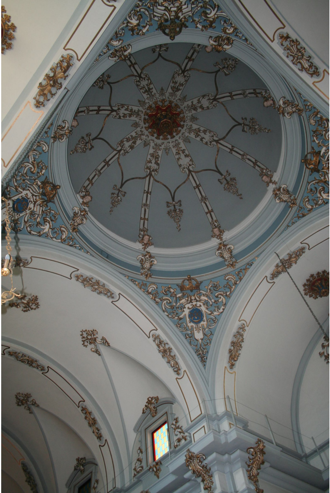
Fotografía detalle arranque de los arcos formeros de la bóveda central
