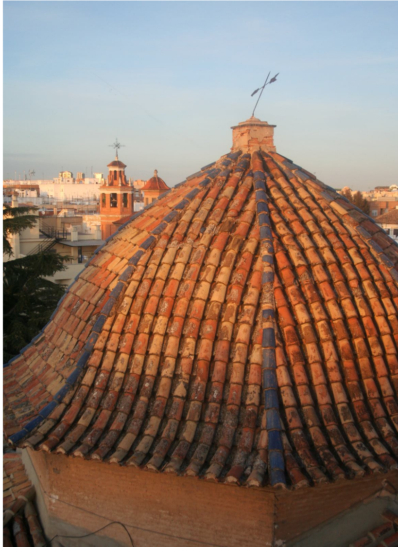
Fotografía detalle techado de la cubierta
