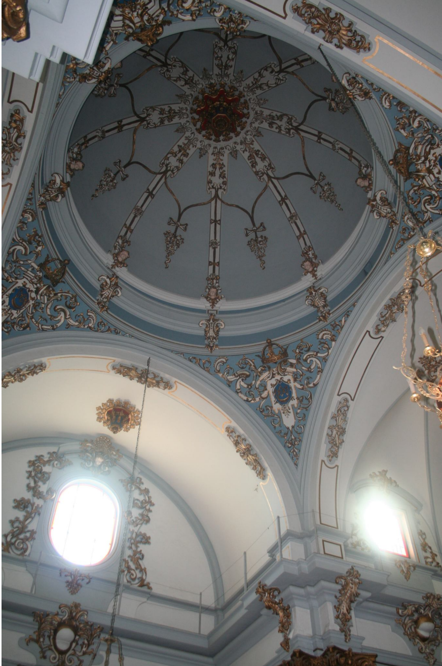
Fotografía detalle de cúpula y arcos portantes.
