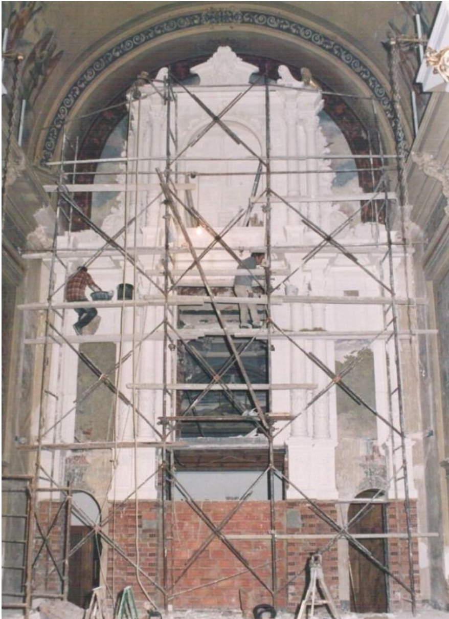
Nuevo retablo en proceso de construcción
