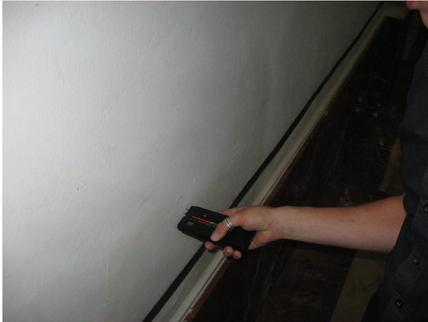
Fotografía de toma de datos (Medidor de humedad)
