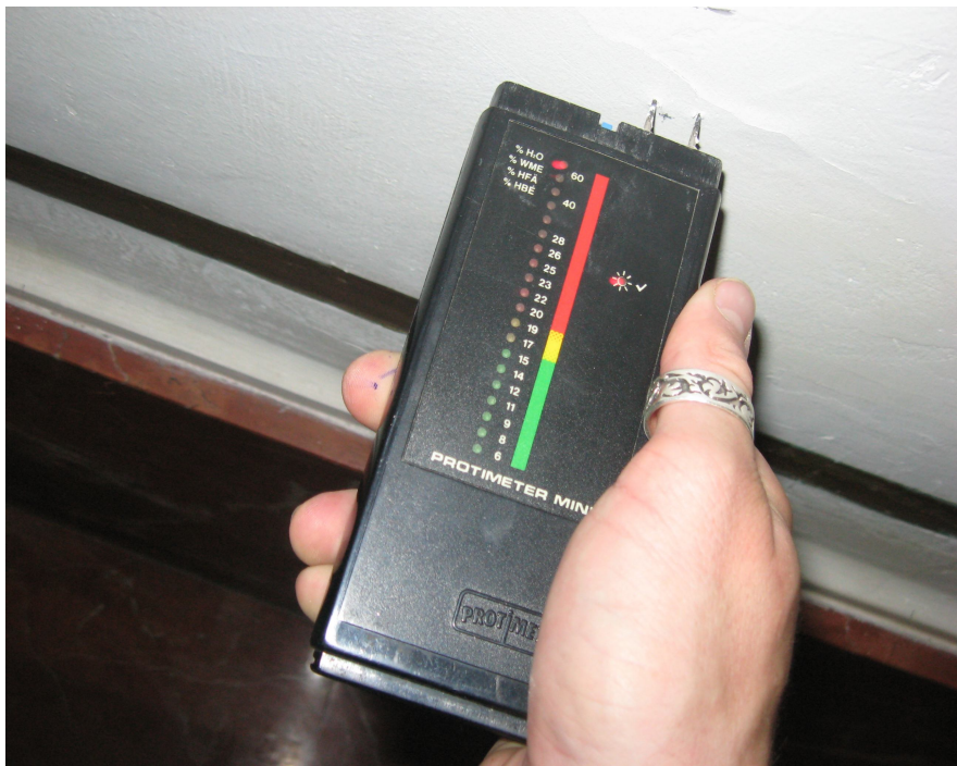
Fotografía de toma de datos (Medidor de humedad)
