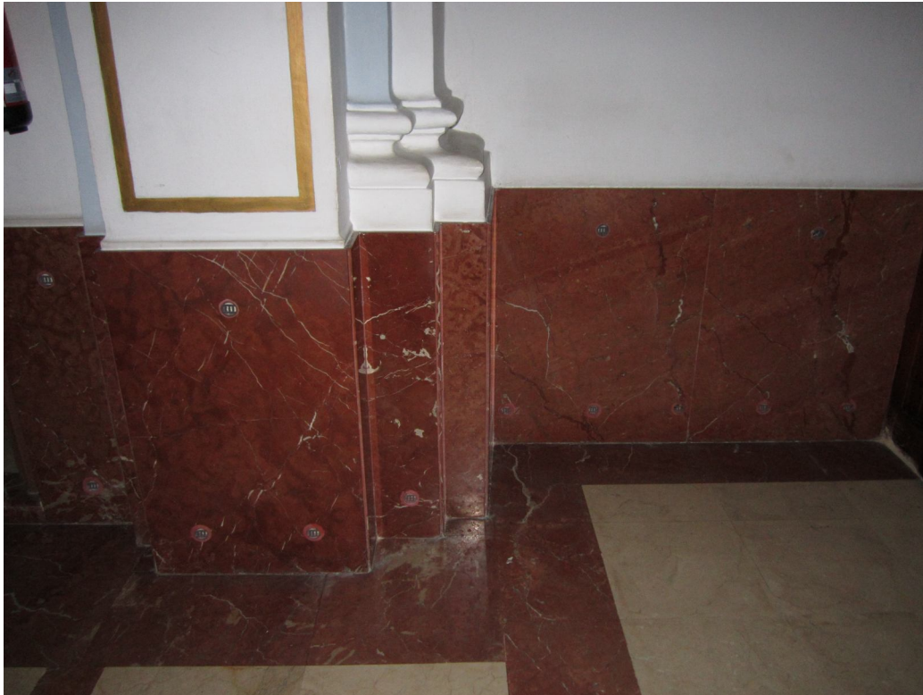
Fotografía intradós del muro de fachada.
