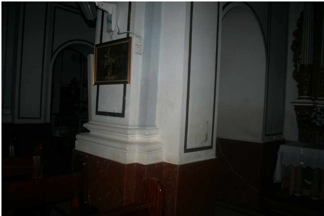
Fotografía columna lujonada (pilar 2º crujía)
