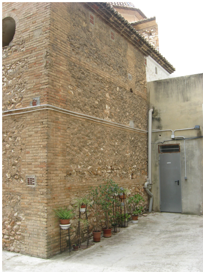
Fotografía detalle zona de estudio por el exterior (patio de luces)
