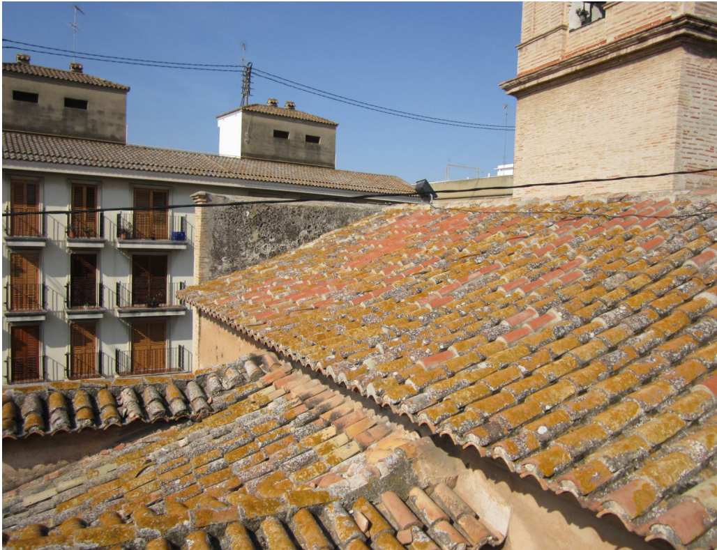
Fotografía de las tejas del tejado de la nave principal.
