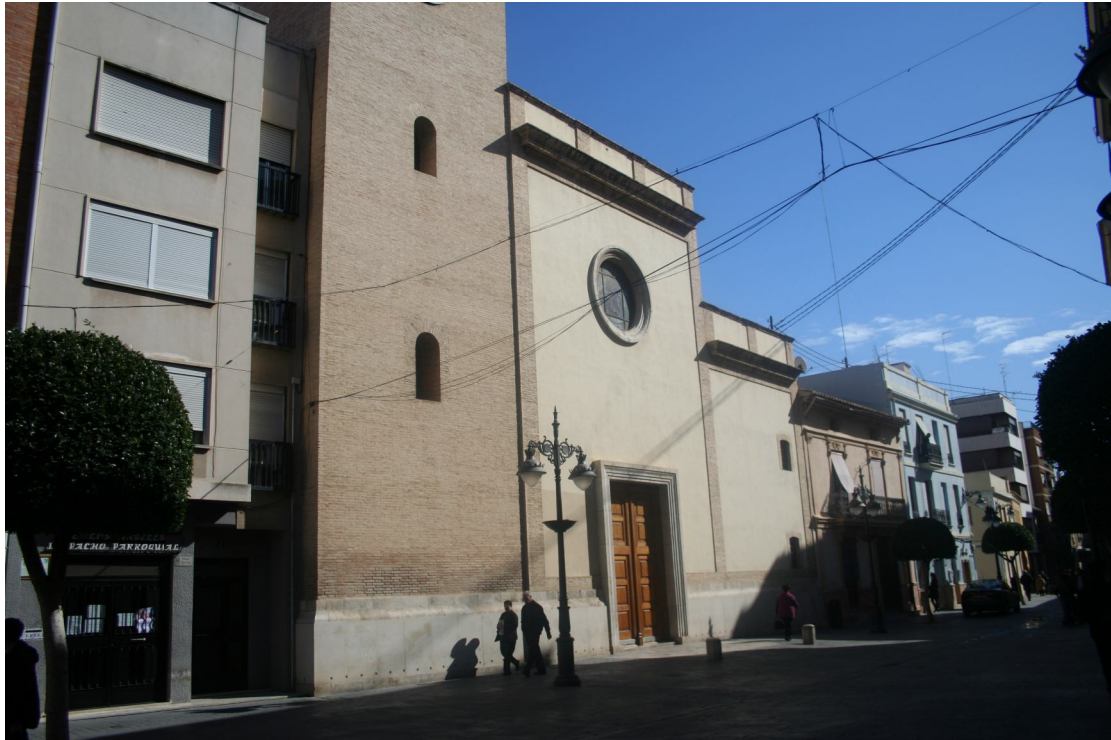
Fotografía detalle acabado muro fachada
