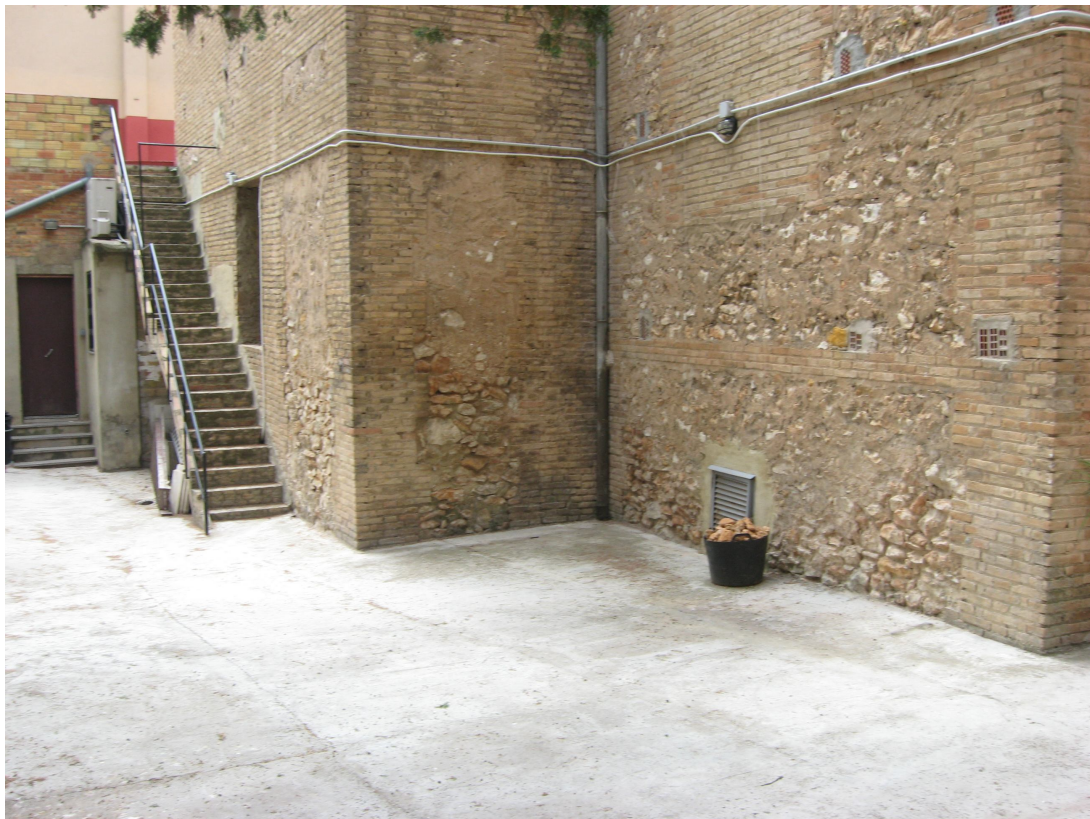
Fotografía del muro visto, desde el patio interior.
