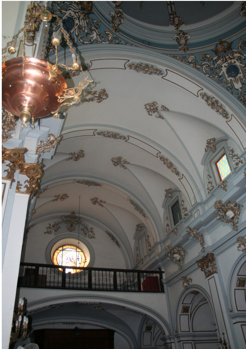
Fotografía detalle de los arcos formeros de la bóveda central.
