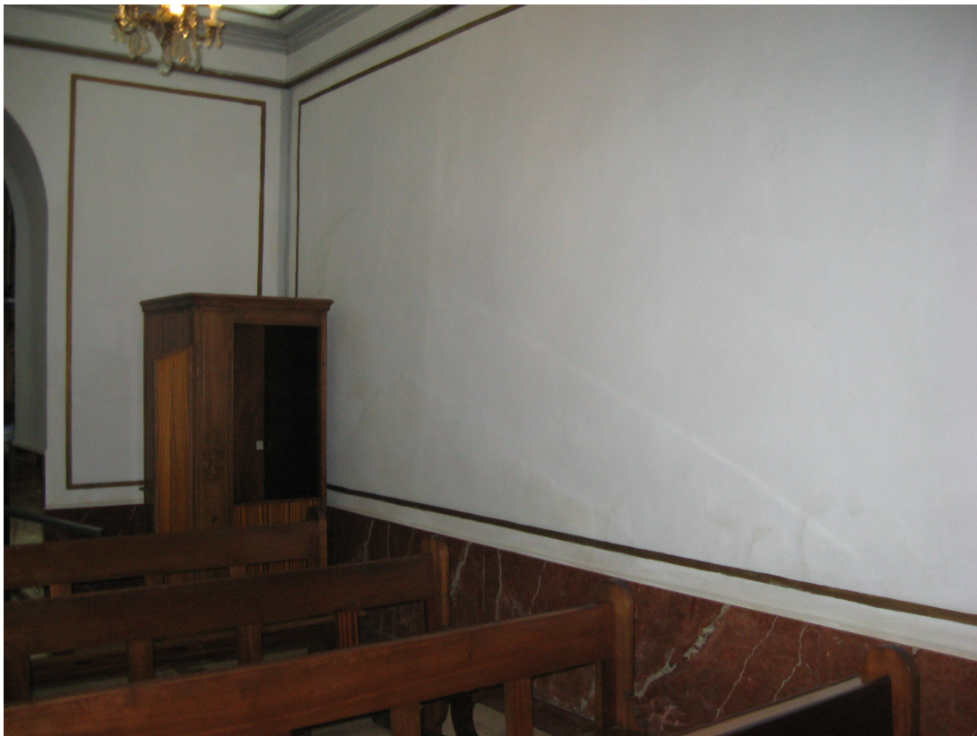
Fotografía detalle revestimiento interior del muro
