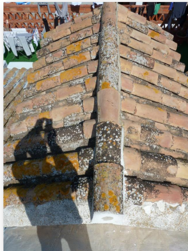
Cubierta de la caseta citada anteriormente.
