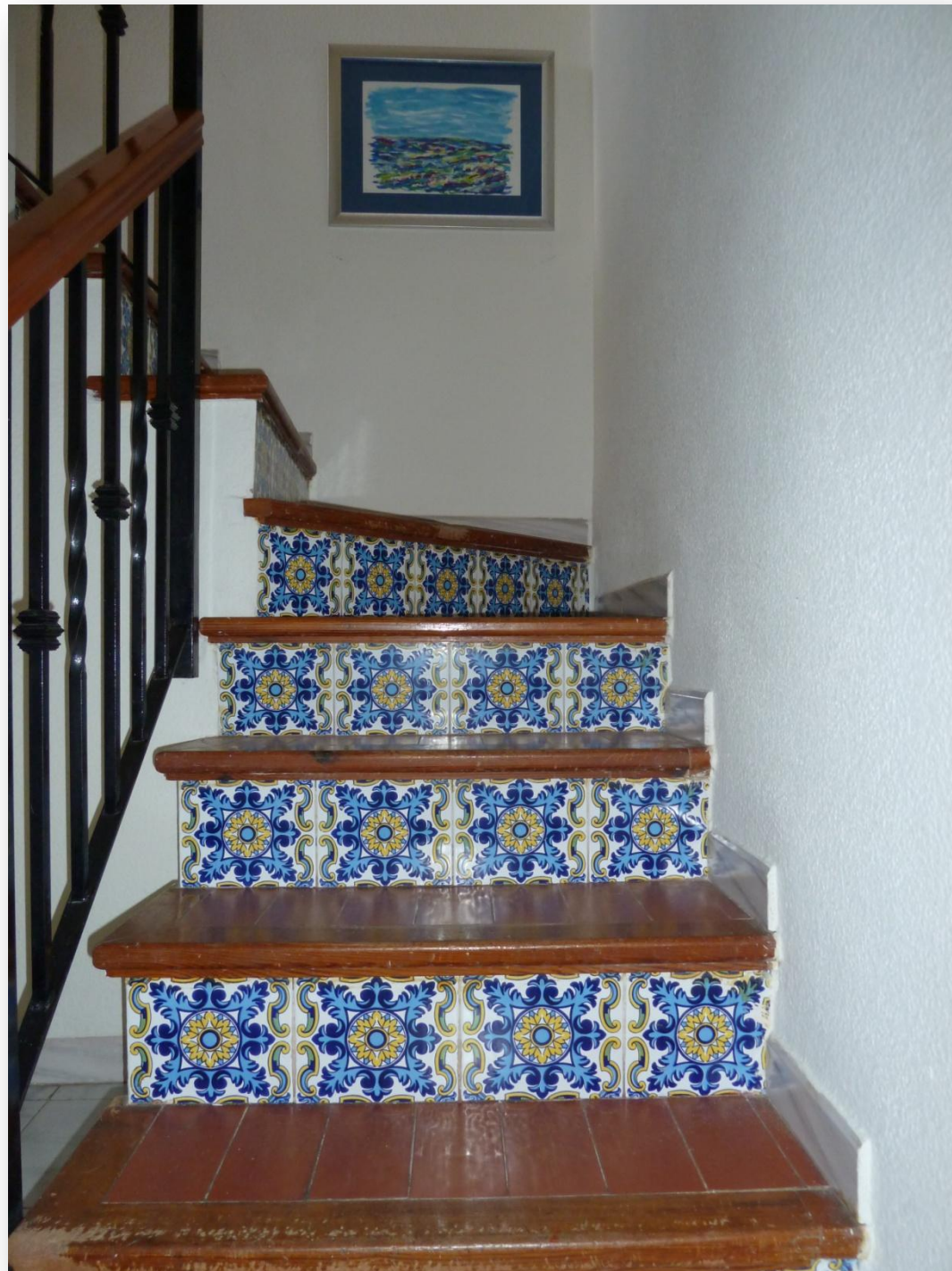
Escalera de acceso a la Planta Cambra . Apreciamos las tabicas revestidas con azulejo valenciano, las huellas con baldosín catalán y las esquinas formadas por un mamperlán de madera.
