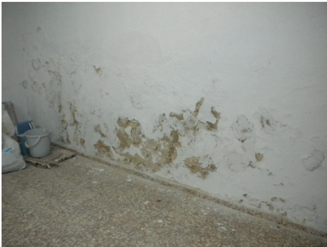
Humitats a la part inferior del mur de mitgera nord. Planta Baixa.
