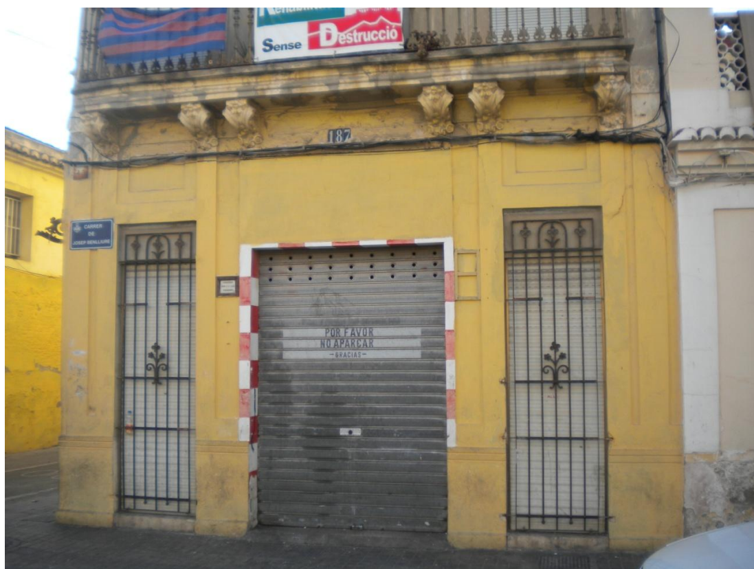
Detall de la part inferior de la façana est.
