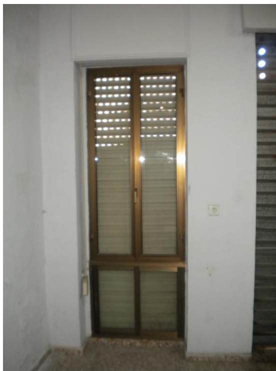
Fusteria d'alumini dels buits laterals de la façana est.
