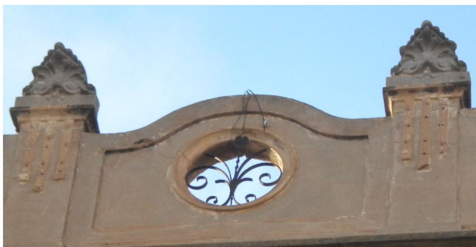
Ornament de ferro de forja al buit circular situat a l'ampit de la façana principal.
