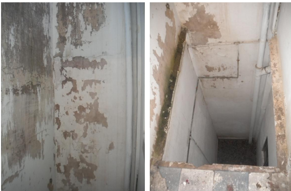
Humitats, s'aprecia com les humitats d'una paret acaben a altura del primer forjat i les altres no (foto dreta).
