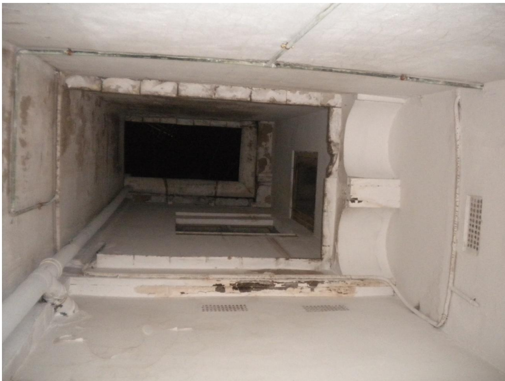
Vista del pati interior des de planta baixa.
