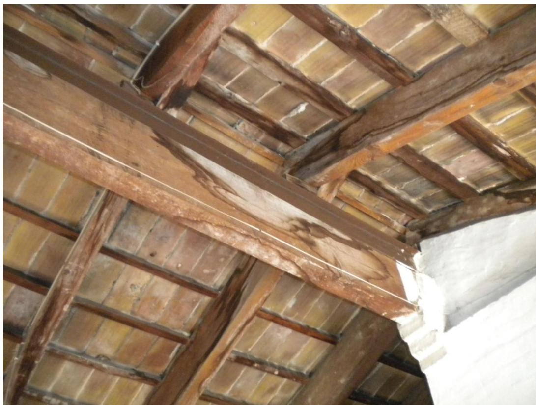
Detall del carener, extrem sud, intersecció amb caixa d'escala.
