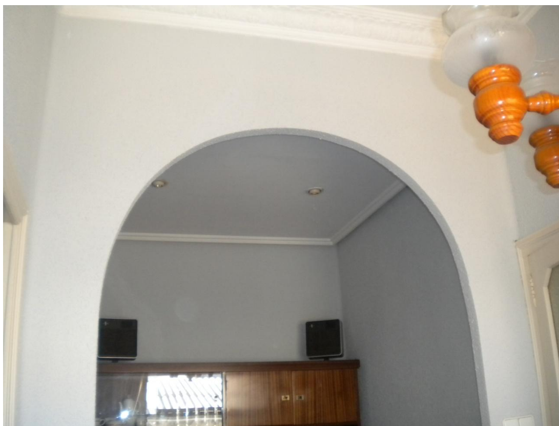
Detall de l'arc a l'envà que separa la zona d'estar de la zona menjador.
