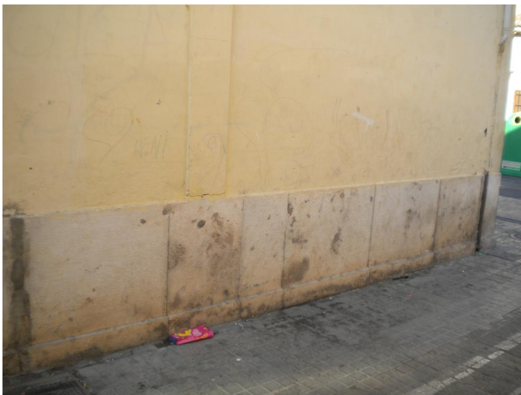
Sòcol de pedra de la façana sud.
