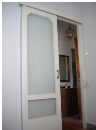
Porta interior corredissa de fusta pintada.
