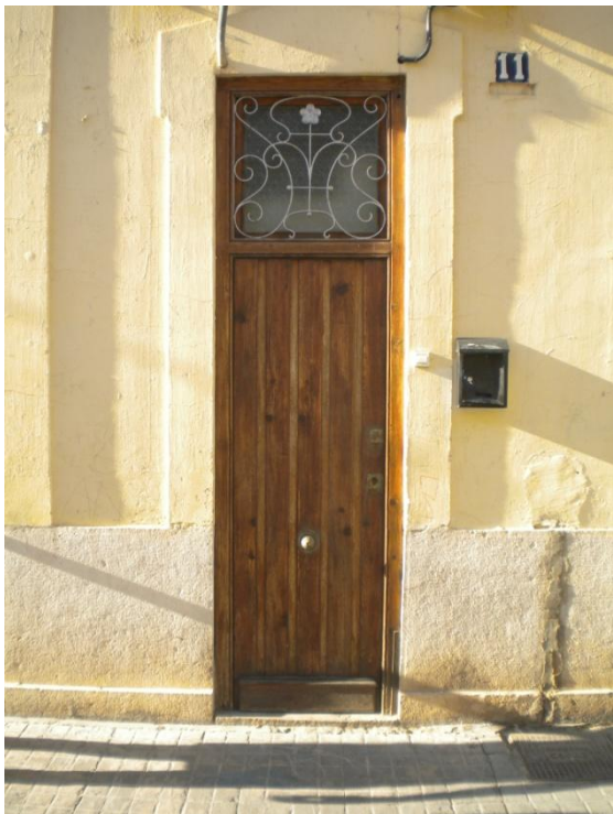
Detall de la porta d'accés a l'escala a la façana sud.
