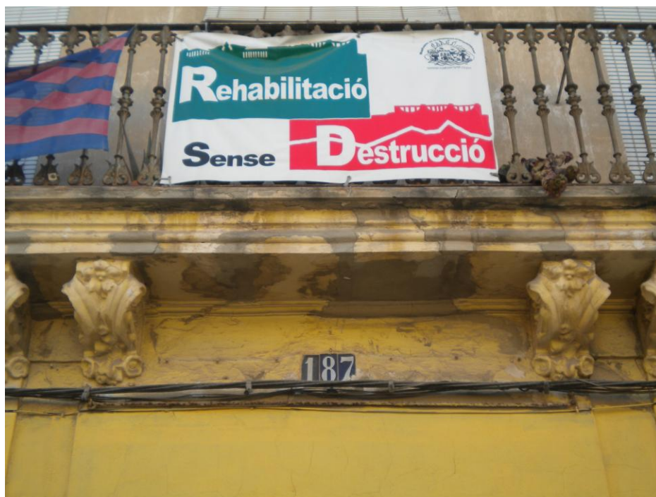
Esquerdas a la part central del balcó.
