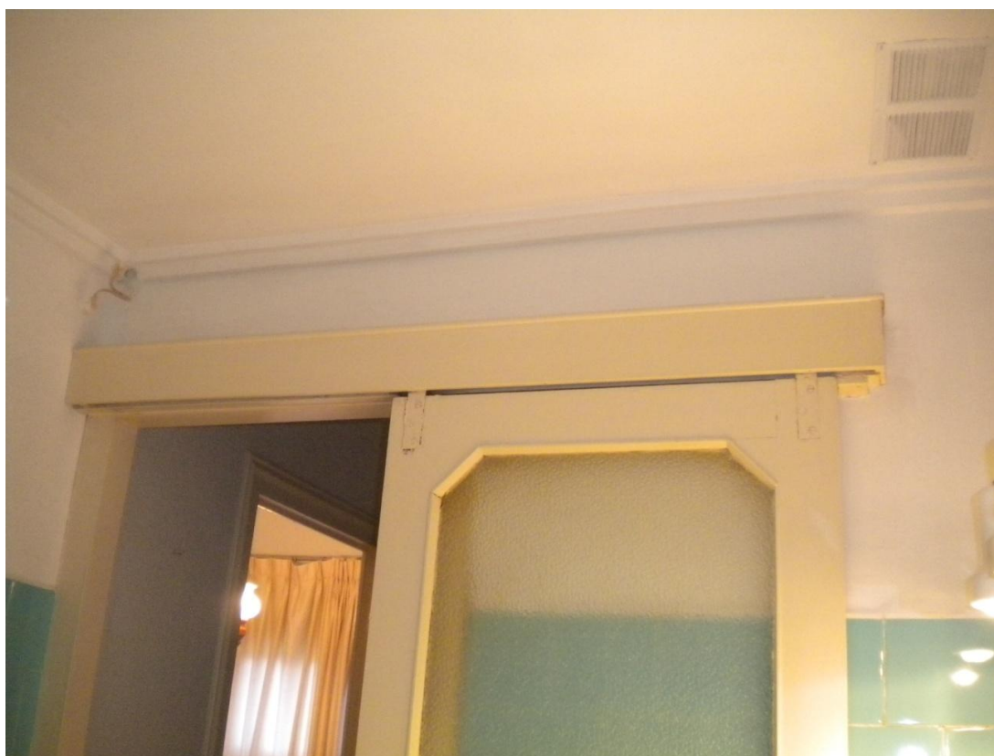
Detall del sistema d'una de les portes corredisses (bany).
