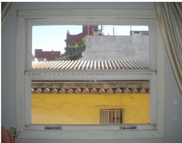
Finestra a la sala d'estar tipus guillotina de fusta pintada de blanc.
