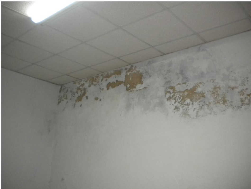
Humitats a la part superior del mur de mitgera nord. Planta Baixa.
