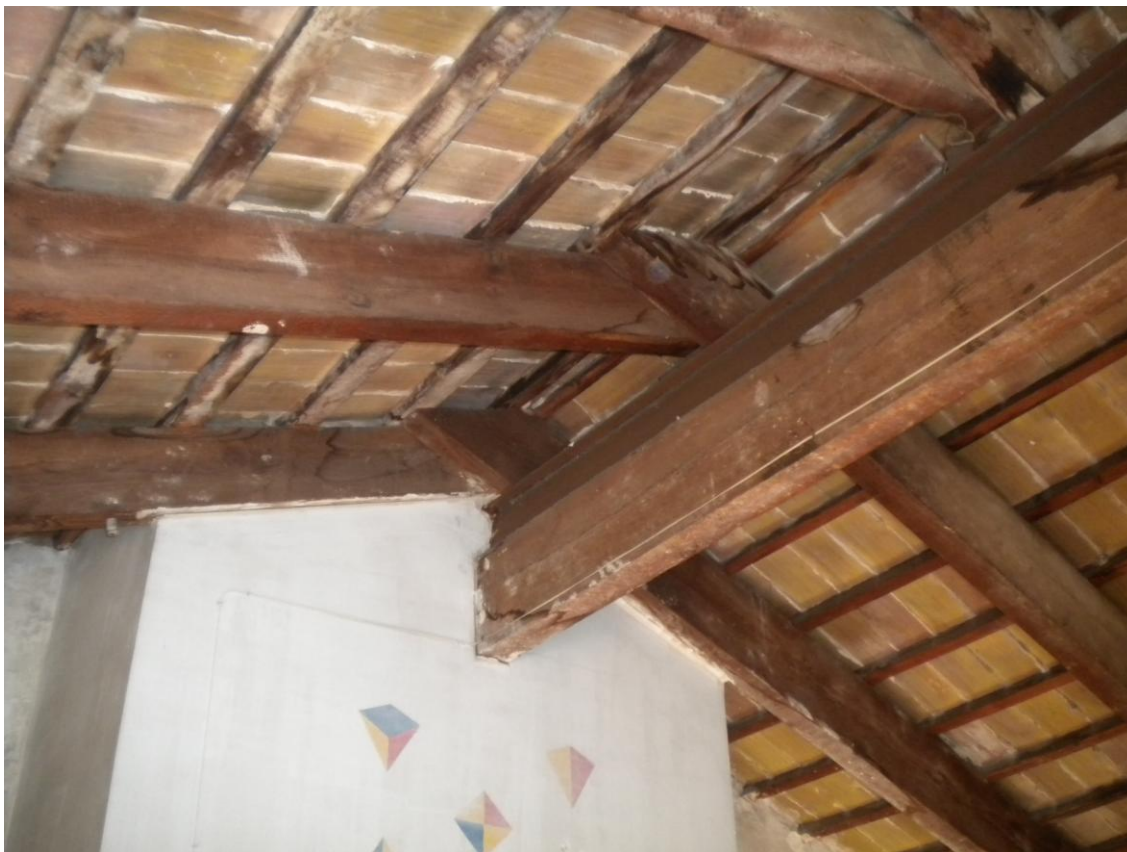
Imatge on s'observa l'element prismàtic en la segona planta i just baix coberta, i com el carener el travessa en el seu extrem nord per tal de trobar-se amb el mur de recolzament.
