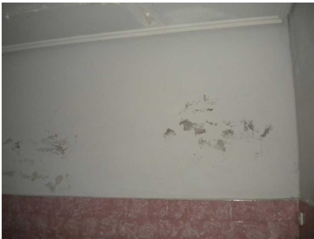
Humitats als murs de la caixa d'escala. Planta Baixa.
