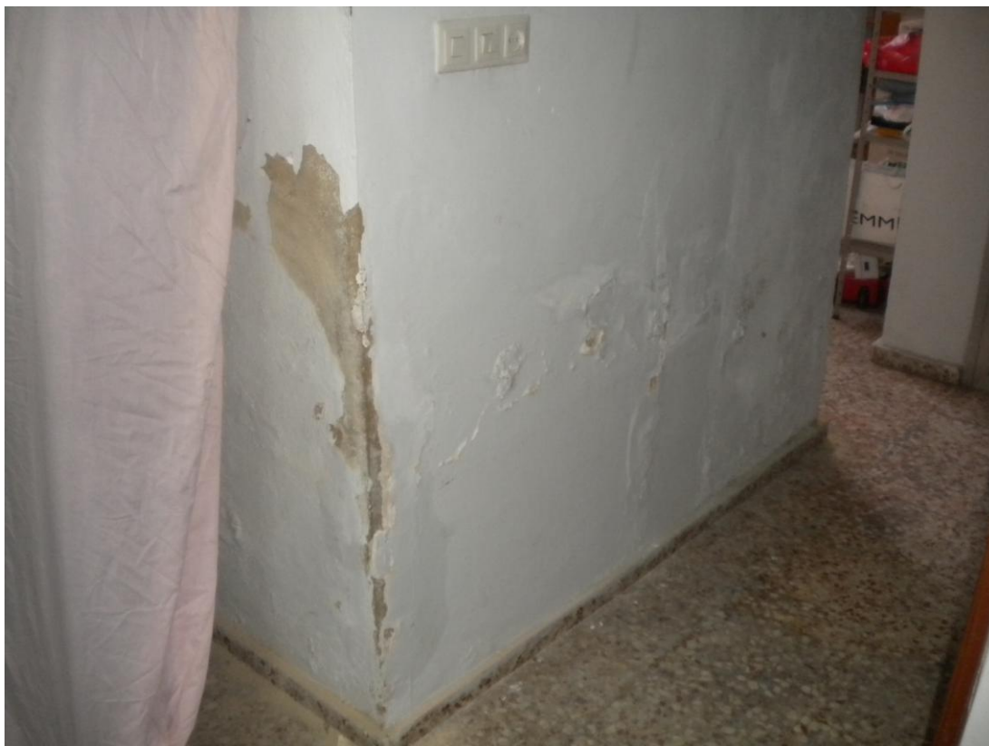
Humitats als murs de la caixa d'escala. Planta Baixa.
