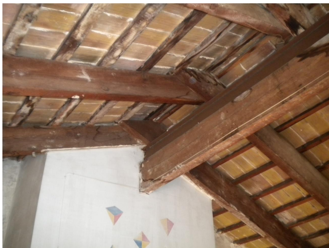
Detall del carener, extrem nord, intersecció amb el prisma de la xemeneia industrial.
