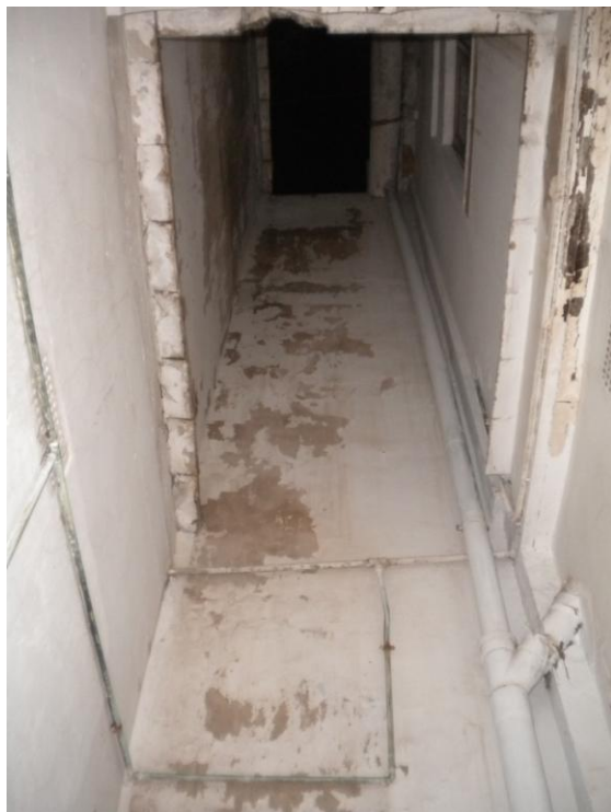
Humitats, s'aprecia com les humitats d'una paret acaben a altura del primer forjat i les altres no (foto dreta).
