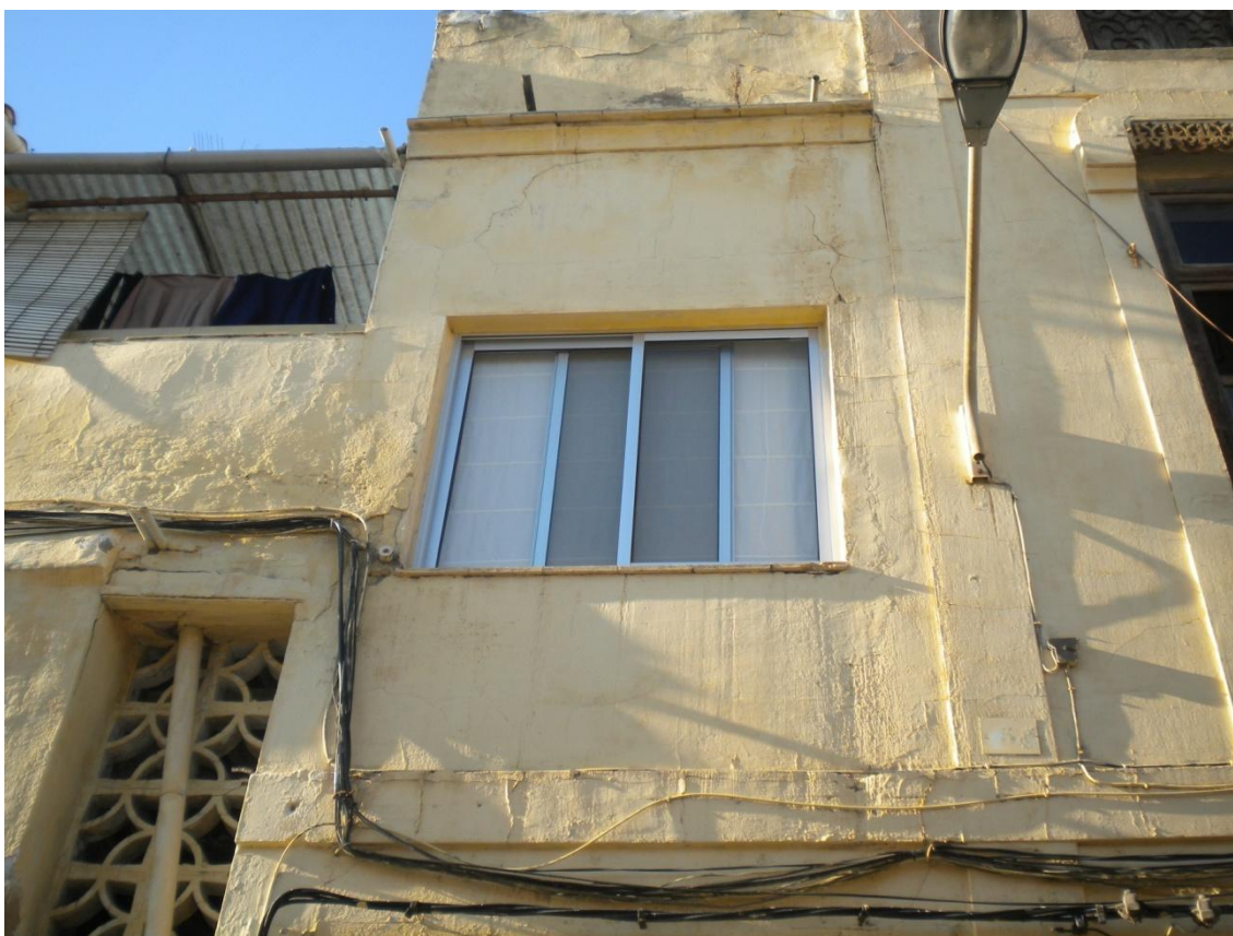
Detall de finestra a la façana sud.
