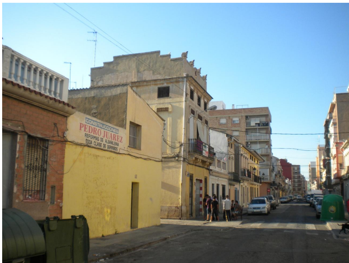
Perspectiva de la casa des del C/José Benlliure (direcció sud – nord).
