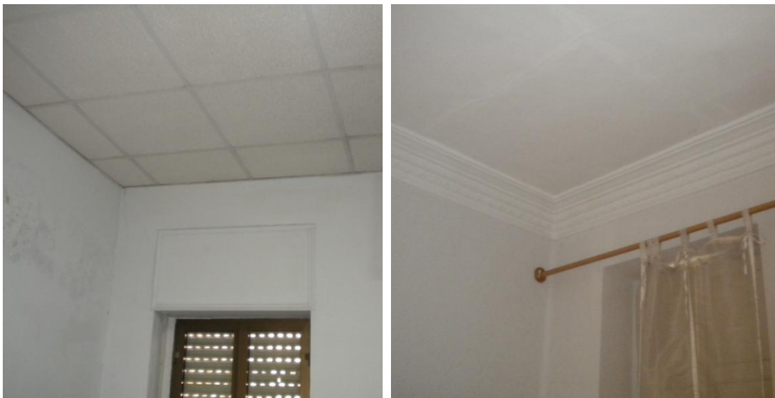
Fals sostre reticular registrable de plaques d'escaiola a la planta baixa i sostre d'escaiola continu amb motllura perimetral al dormitori gran en planta primera.
