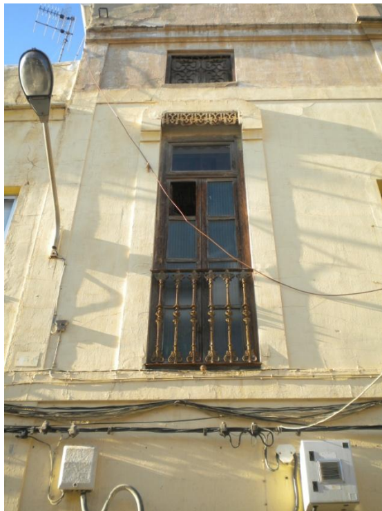
Detall de finestra a la façana sud.
