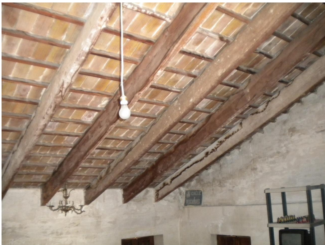
Cara interior de la coberta.
