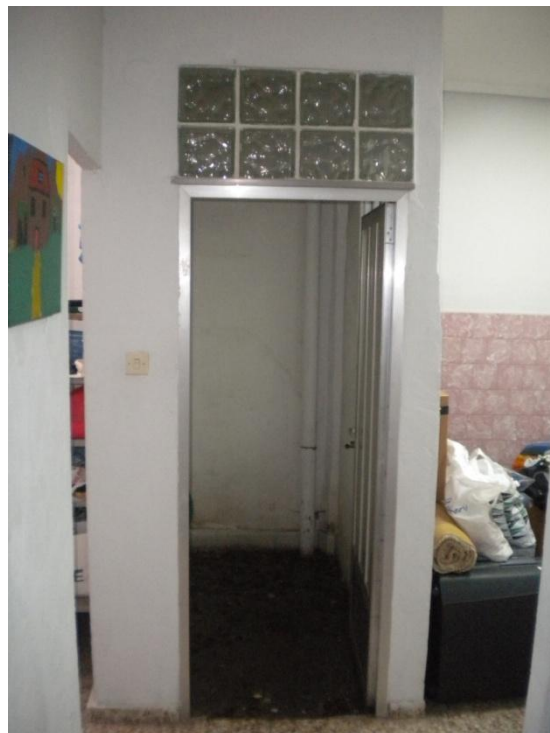
Detall de porta d'accés al pati interior.
