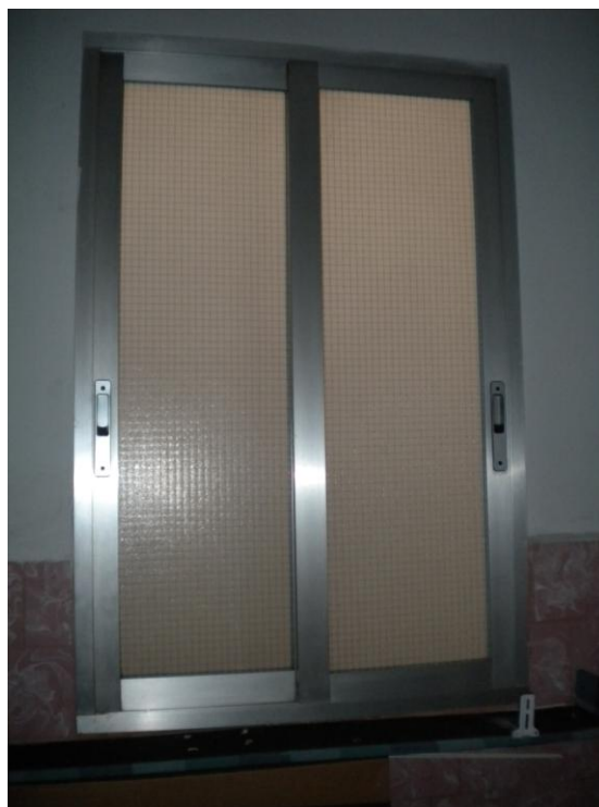
Fusteria d'alumini del buit de pati interior.
