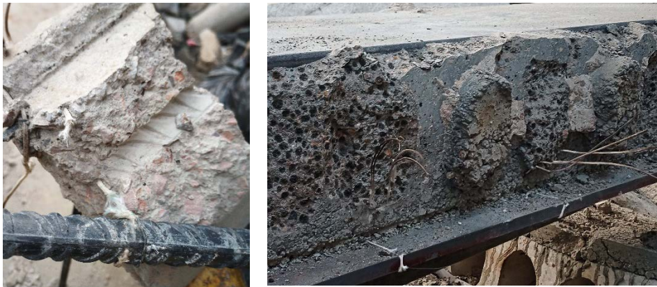
Figura 4-10 Detalles de las demoliciones de vigas ensayadas.
