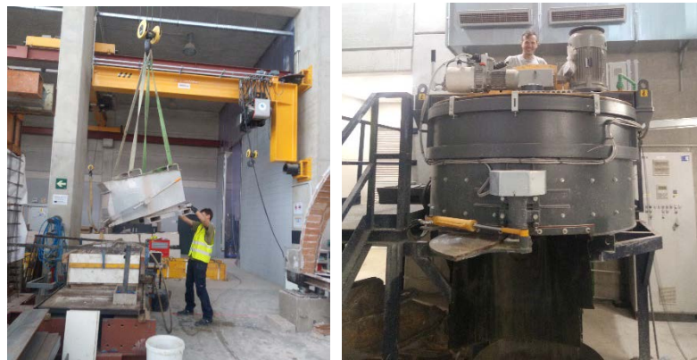
Figura 4-7 Vertido de hormigón (izq.) vista amasadora orbital (der.)
