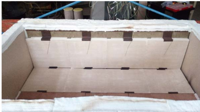
Figura 4-36. Colocación de termopares de control de emisores en el horno.
