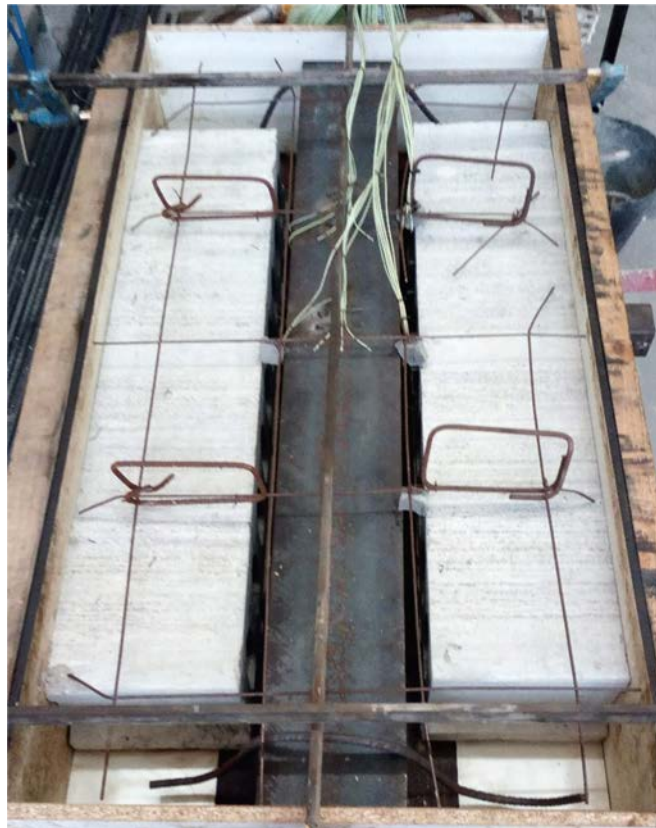
Figura 4-12 Prelosas y viga de acero preparada para hormigonar.
