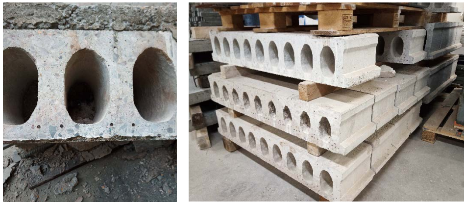
Figura 4-11 Imágenes de las losas de alveolares P20*120 suministradas por la empresa Hermo S.L.
