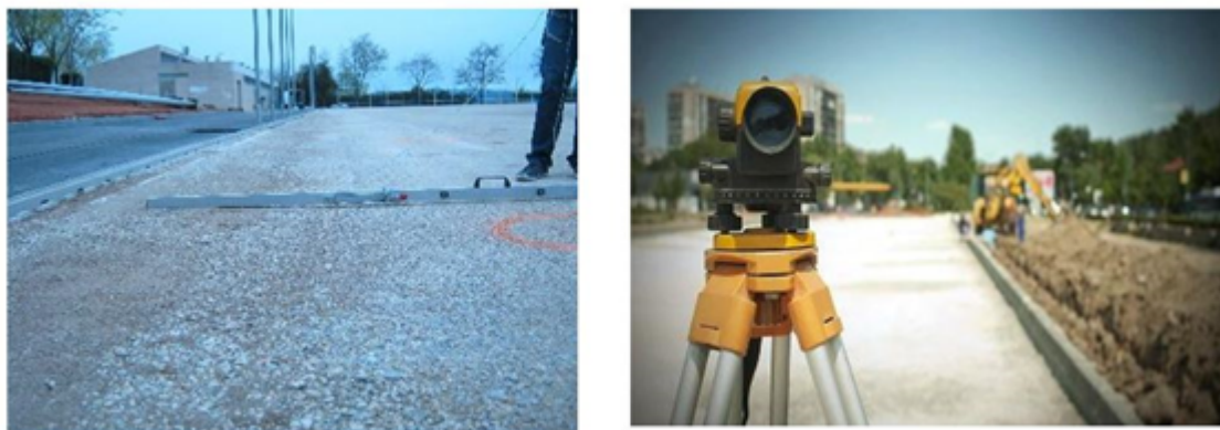
Figura 4. Evaluación física "in situ" de la sub-base (planimetría y pendientes).
