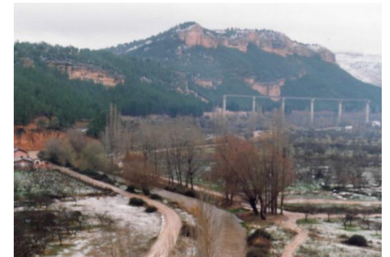
Construcción de la actual carretera CV-35 Autor: Felipe Gonzalo Manzano Martínez
