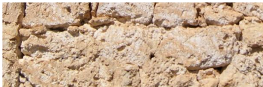
Muro de la fachada hecho de mampostería de piedra.
