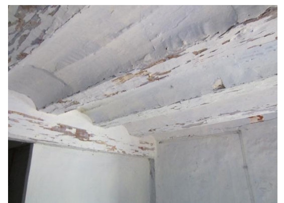
Revoltones de yeso y viguetas de madera
