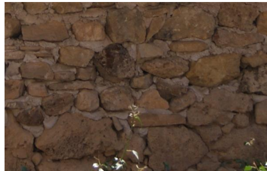
Piedras cogidas con yeso en los muros del molino
