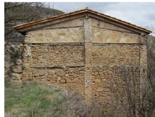
Muro de mampostería (Molino de Villaescusa)
