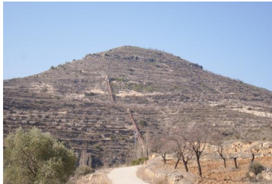
Tubo de conducción descendiendo por la ladera
