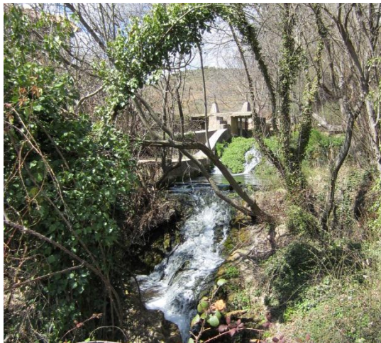
Presas de la Central hidroeléctrica
