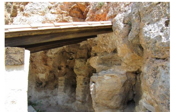
Cubierta apoyando en el cerro
