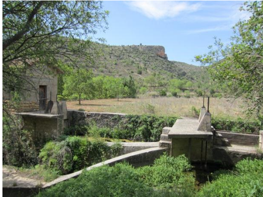
Presas de la Central hidroeléctrica, donde estaba ubicado anteriormente el Batán
