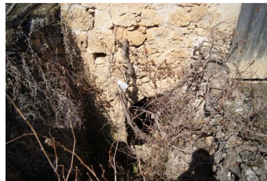
Entrada de agua al molino
