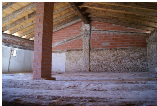
Estructura cubierta restaurada
