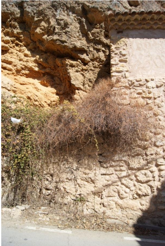
Cerro sobre el que apoya la estructura del molino
