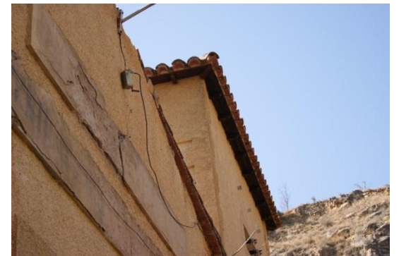
Alero cubierta torre
