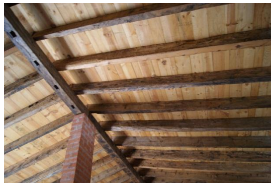
Estructura cubierta restaurada
