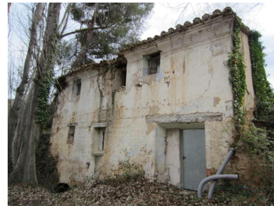
Revestimiento realizado con enlucido de yeso (Molino de Efrén)
