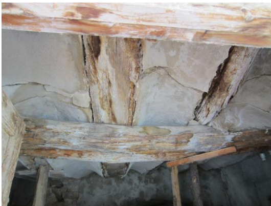
Forjado de viguetas de madera y revoltones de yeso (La Centralilla)
