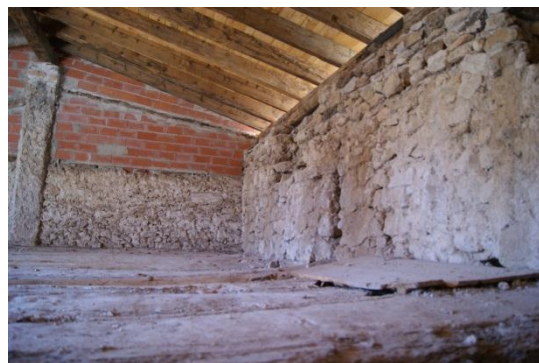
Viguetas apoyando en la durmiente
