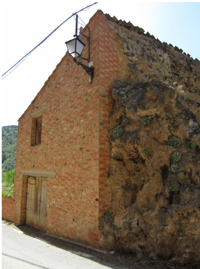
Fachada de ladrillo
