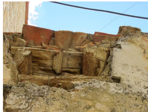
Alero de la cubierta
