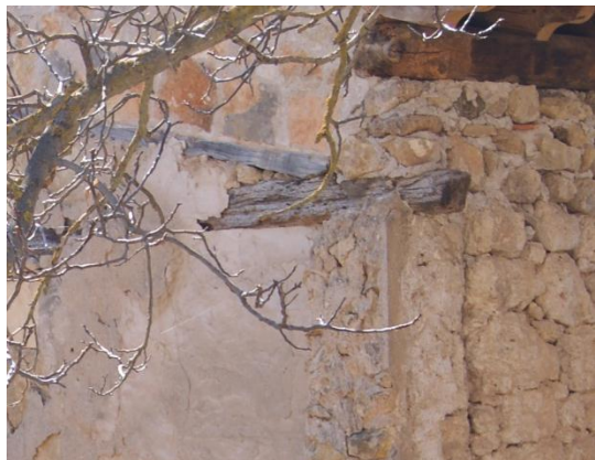
Rollizos de madera en la construcción de las vigas y durmientes.
