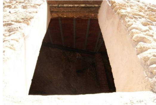
Estructura de la cubierta
