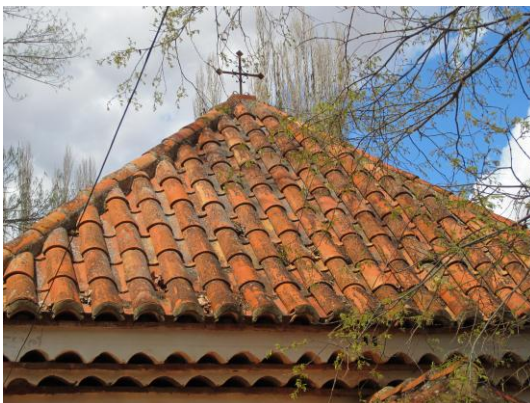
Cubierta resuelta con tejas curvas (Ermita Nuestra Señora del Rosel)
