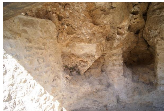
Cerro sobre el que apoya la cubierta
