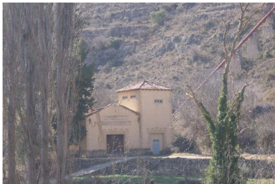
Fachada principal y canal de abastecimiento
