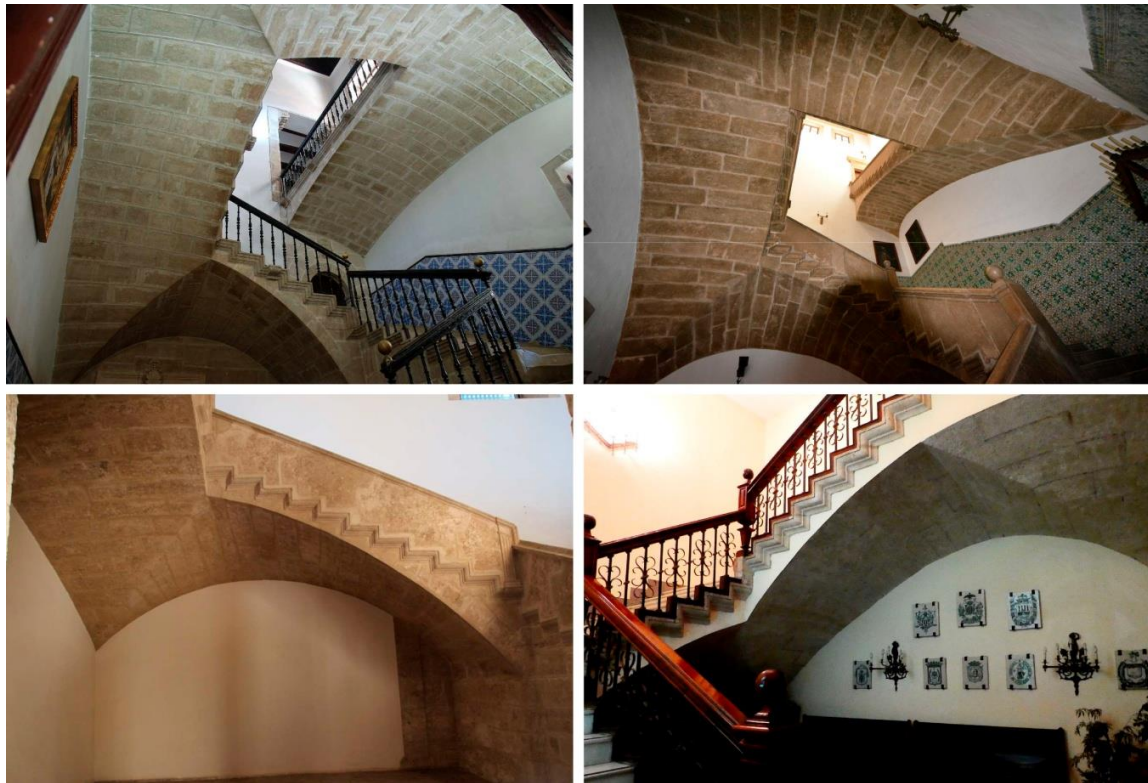
58 Figure 6: Current status of the study cases: a) Stairways of Santo Domingo (Orihuela); b) Corpus Christi 59 (Valencia); c) San Miguel de los Reyes (Valencia); d) Aduana Real (Valencia). Pictures by the authors. 60 61 62 63 64 65
