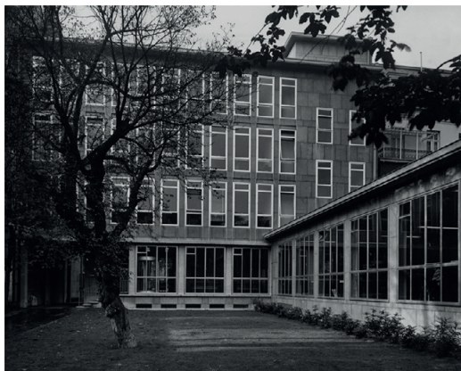
Figura 8. Consulado de Estados Unidos en Amberes. Izquierda: vista desde el patio parcela. Derecha: vista interior de las oficinas (1955).
