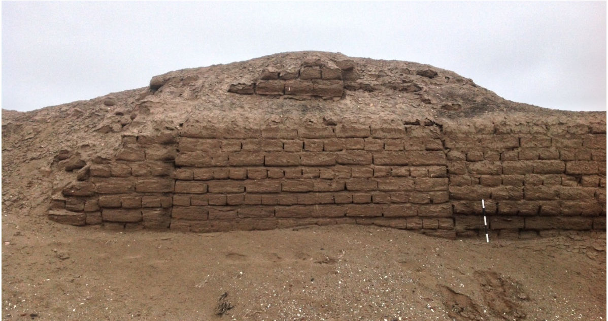
Figura 54. Semienterrado se observa un muro ordenador construido con adobes, tiene ambos lados inclinados a los que se la han adosado otros muros. Se aprecia el tipo de aparejo usado. Santuario arqueológico de Pachacamac. Fuente: Henry Eduardo Torres.
