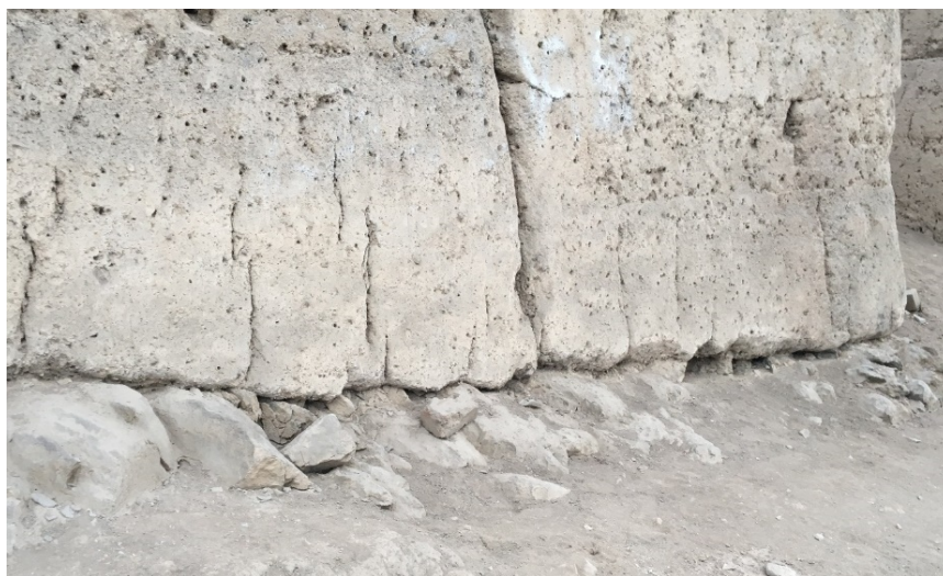
Figura 39. Detalle del suelo de cimentación de un tramo de muro, se construyó directamente sobre el afloramiento rocoso. Fuente: Henry Eduardo Torres.
