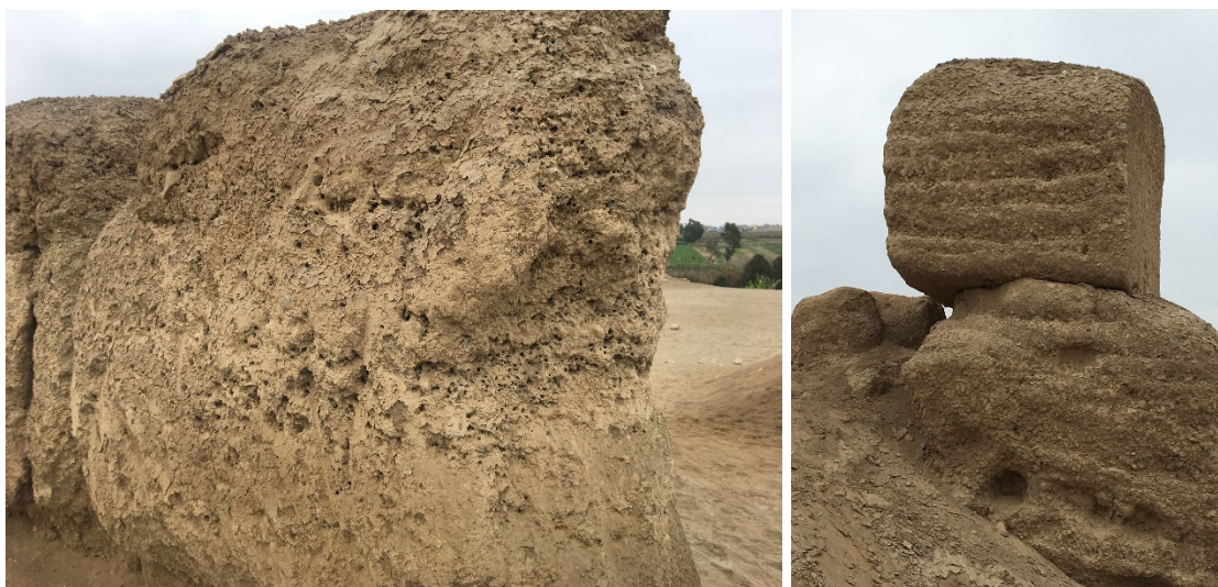
Figura 71. Pulverización en la superficie. Fuente: Henry Torres.
