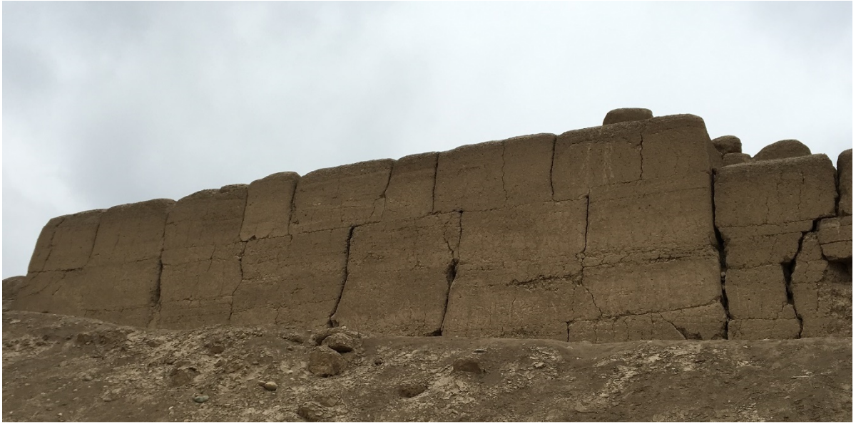
Figura 9. Vista de un muro, los bloques constructivos tienen juntas verticales y los bloques superiores se traban con los inferiores, en general en buen estado de conservación. Las uniones de los bloques se han acentuado producto de los sismos y se observan algunas grietas. Fuente: Henry Eduardo Torres .
