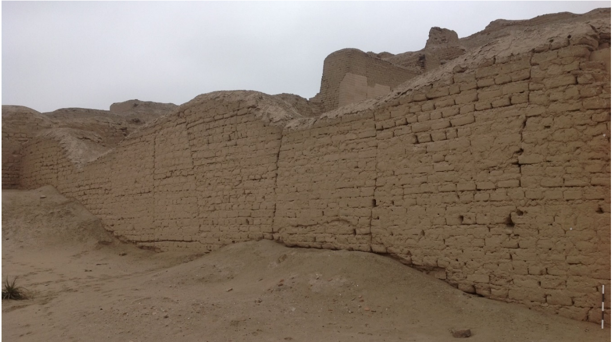
Figura 55. Vista de un muro con segmentos claramente establecidos. Fuente: Henry Eduardo Torres.
