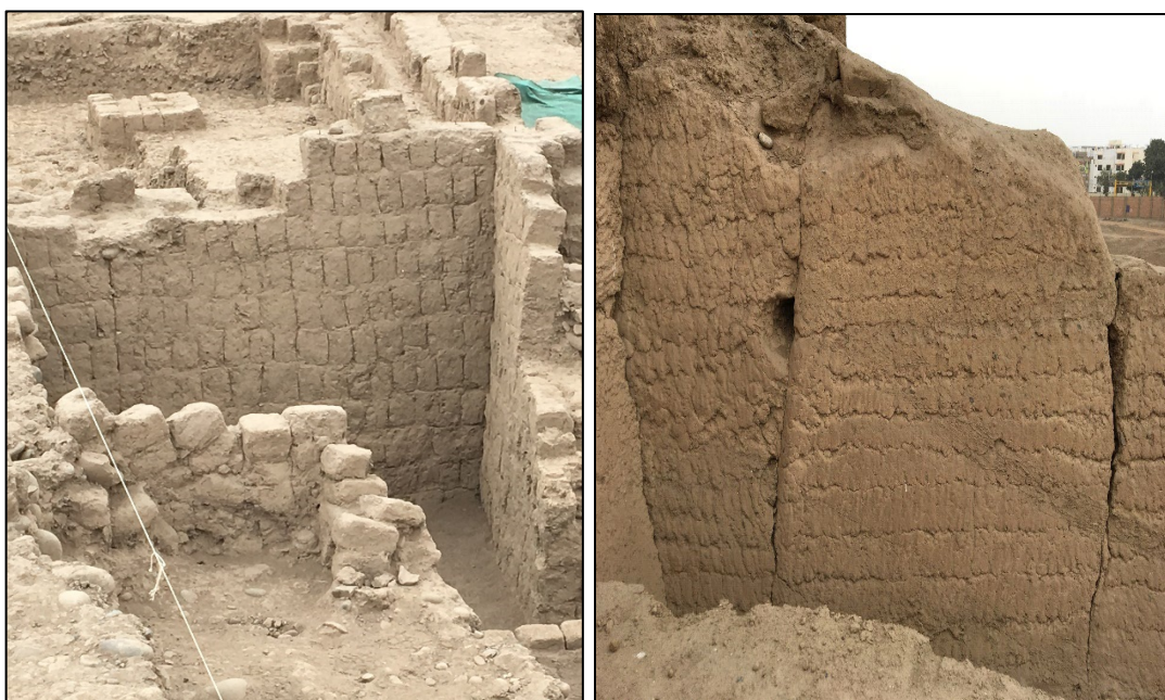
Figura 34. Izquierda (a), restos de un muro elaborado con adobes modelados a mano y asentados en hiladas horizontales sin junta vertical. Derecha (b): Restos de muros elaborados con porciones de barro asentados en forma similar a los adobes. Sitio arqueológico del Complejo Maranga. Fuente: Henry Eduardo Torres.
