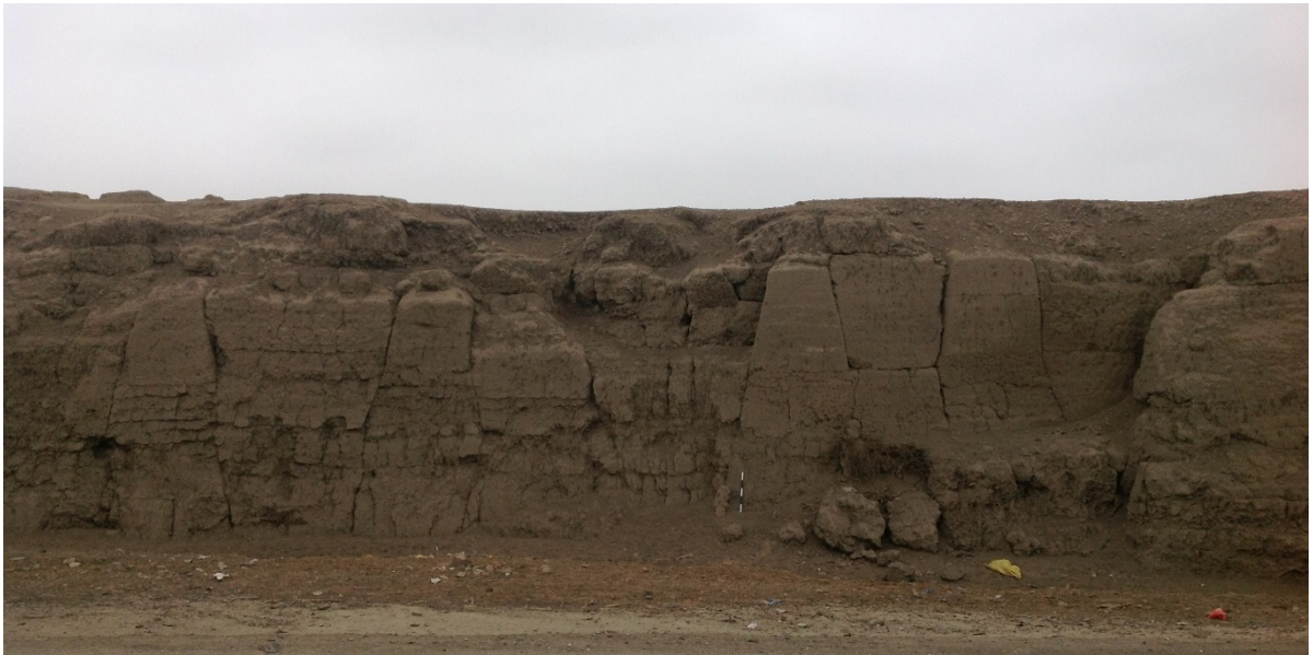
Figura 26. Vista en elevación de la muralla donde pueden observarse los bloques ordenadores y los muros de relleno entre ellos. Fuente: Henry Eduardo Torres
