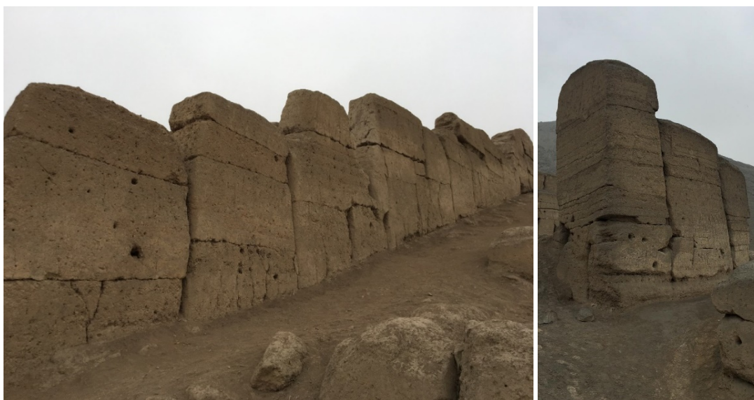
Figura 41. Muros tipo 1. Fuente: Henry Eduardo Torres.
