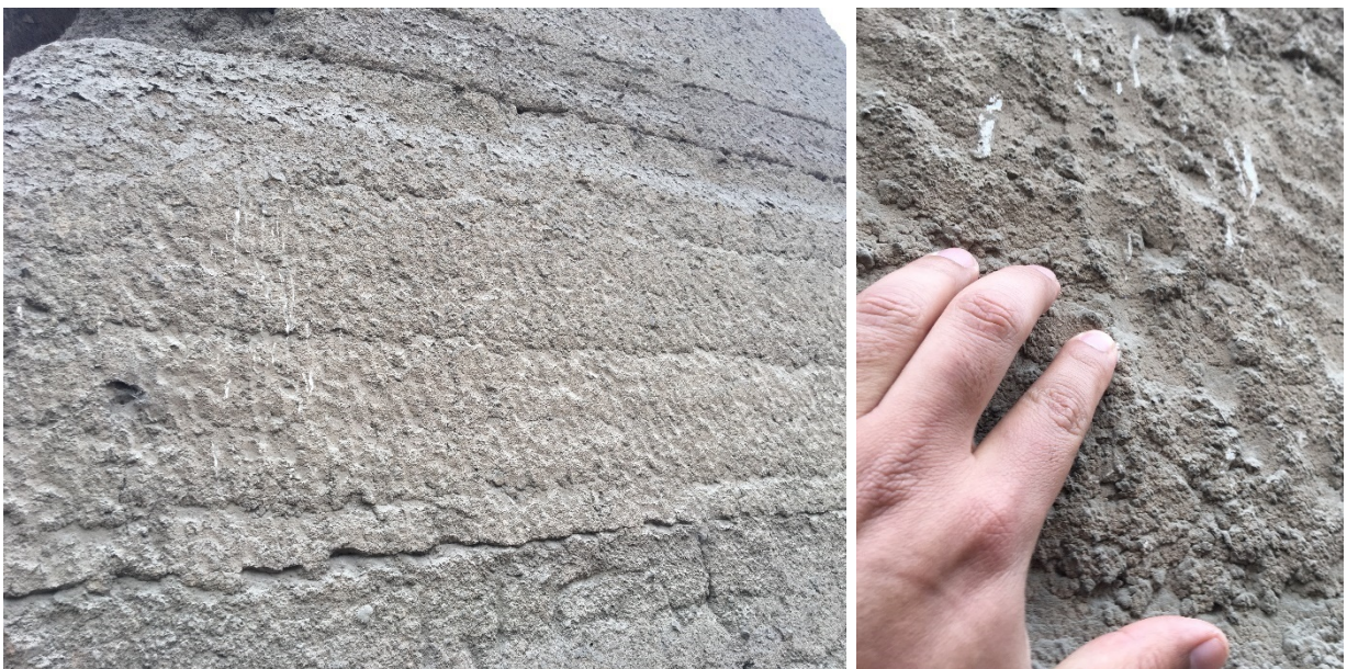
Figura 37. Aspecto del acabado del paramento de un muro de tierra modelada sin el acabado final. Fuente: Henry Eduardo Torres. Derecha: Detalle del paramento donde se aprecian las huellas dactilares de los constructores. Fuente: Henry Eduardo Torres.
