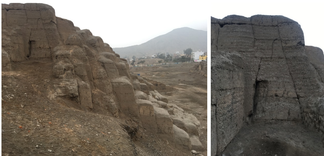
Figura 16. Izquierda: Detalle constructivo de los muros construidos en forma escalonada y apoyados entre sí, probablemente se han construido sobre un afloramiento rocoso. Derecha: Detalle de un bloque ordenador 3 ubicado en la parte superior de la construcción. Fuente: Henry Eduardo Torres.
