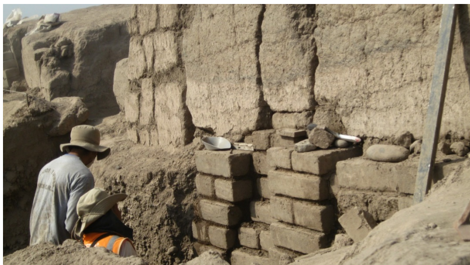
Figura 90. Calzadura debajo del muro M-10 con la colocación de bloques de mampostería de adobes colocados progresivamente. Fuente: Henry Eduardo Torres Proyecto Huaca Bellavista.
