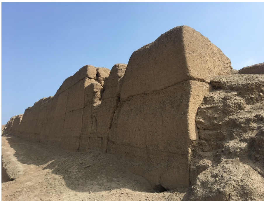
Figura 59. Bloque ordenador, con unos 5 m de altura. Se mantiene estable entre dos segmentos derrumbados. Huaca Tres Palos. Fuente: Henry Eduardo Torres.
