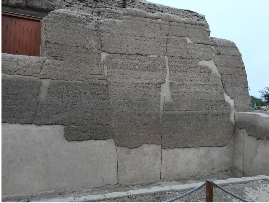
Figura 69. Tramo de muro de tierra modelada, pertenece a un recinto que ha sido acondicionado como auditorio, la estructura ha sido conservada, se pueden apreciar las segmentaciones de forma trapezoidal perfectamente definidas desde la base a la parte superior. Fuente: Henry Eduardo Torres.
