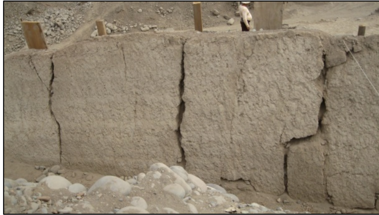
Figura 77. Muro agrietado encontrado luego de las excavaciones.
