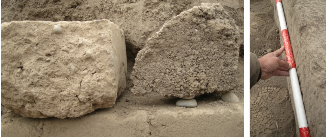
Figura 2. Comparación entre un adobe y un fragmento de muro de tierra modelada, donde se aprecia la diferencia entre un barro compactado y la textura sin compactar, en la otra vista se aprecia lo recto del paramento. Fuente: Henry Eduardo Torres.
