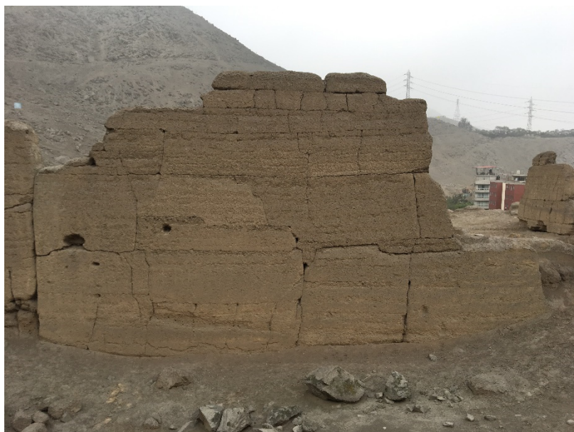
Figura 19. Muro formado por varios bloques unidos por una compleja mampostería de varios eventos constructivos. Fuente: Henry Eduardo Torres.
