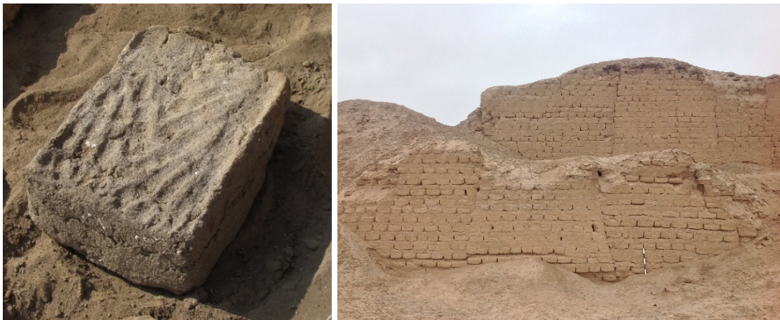
Figura 33: Adobe fabricado con molde y la mampostería que conforma en hiladas horizontales. Santuario arqueológico de Pachacamac. Fuente: Henry Eduardo Torres
