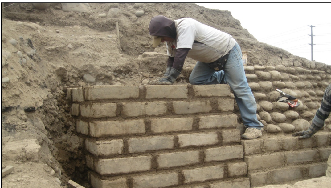
Figura 89. Vista de un bloque de reintegración en proceso de construcción. Fuente: Henry Eduardo Torres Proyecto Huaca Bellavista.
