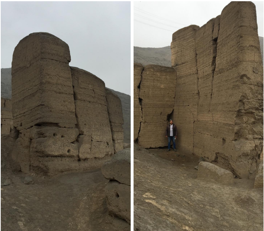
Figura 21. Muros de grandes dimensiones formados por adosamientos sucesivos de bloques, los muros tienen más de 6 m de altura, se aprecian claramente las capas de barro de la técnica constructiva. Fuente: Henry Eduardo Torres.
