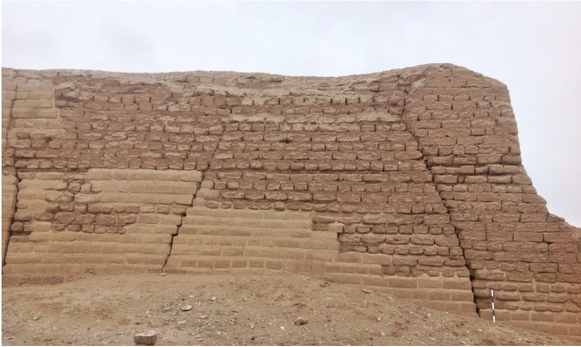
Figura 56. Bloque ordenador de gran tamaño, con más de 3 m de altura y al menos 4 m de ancho. Se aprecia el tipo de aparejo usado. Santuario arqueológico de Pachacamac. Fuente: Henry Eduardo Torres.
