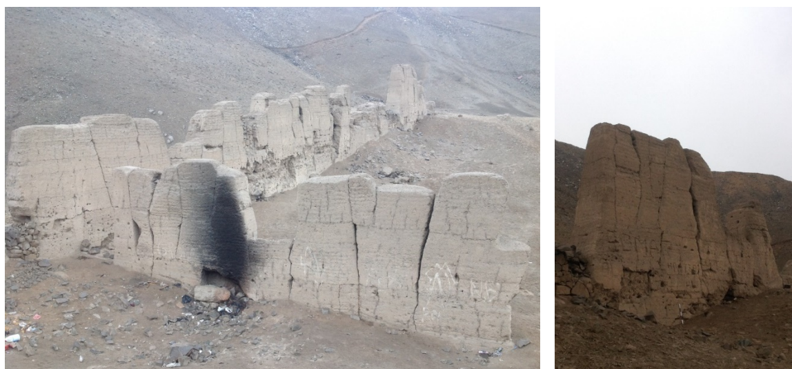
Figura 23. Muros formados por una sucesión de bloques ordenadores y bloques de ajuste o claves 4 , los muros tienen al menos 3 m de alto. Fuente: Henry Eduardo Torres.
