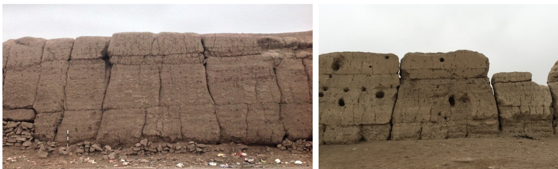
Figura 40. Detalle de muros con bloques ordenadores, es notable la similitud de las formas. Fuente: Henry Eduardo Torres.
