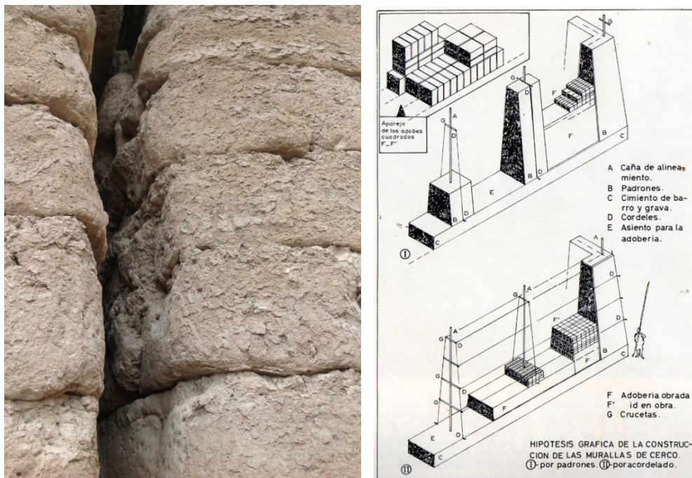
Figura 58. Izquierda: Detalle de la junta entre bloques constructivos formados por adobes. Fuente: Henry Eduardo Torres. Derecha: propuesta de construcción de grandes muros de adobe según Harth Terre. Fuente: (Harth-Terre, 1965)
