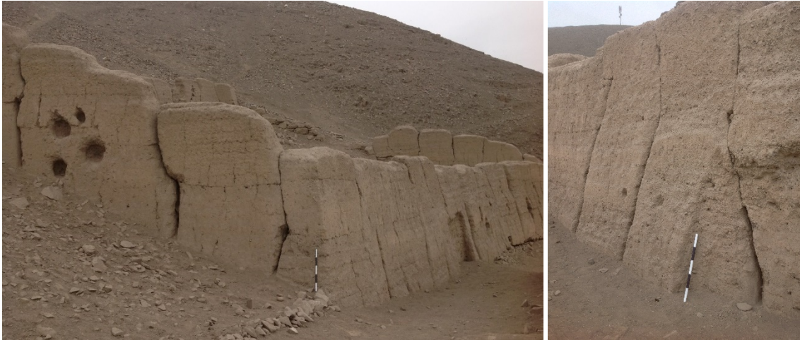
Figura 30. Detalle de un espacio amurallado empleando muros de tierra modelada, se aprecian los segmentos de muros independientes y una fuerte inclinación. A la derecha detalle de las juntas entre bloques. Fuente: Henry Eduardo Torres.
