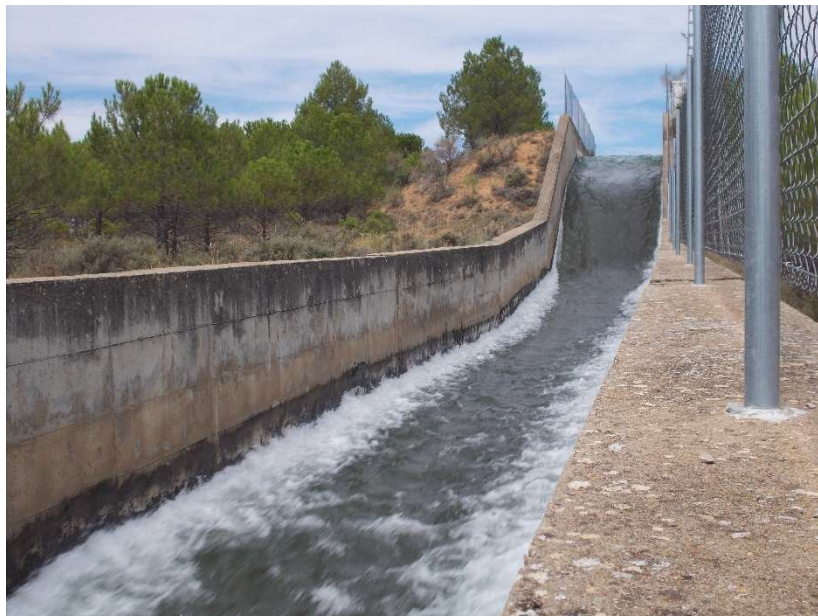
Ilustración 14. Rápida de Belmontejo en el PK 90+900
