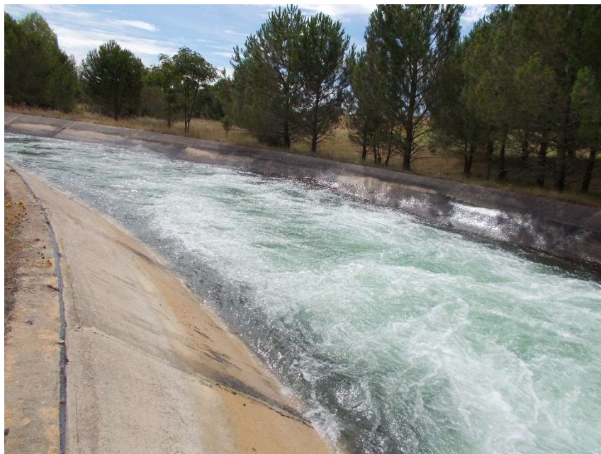
Ilustración 16 Canal del Juncosillo, zona de tramo curvo
