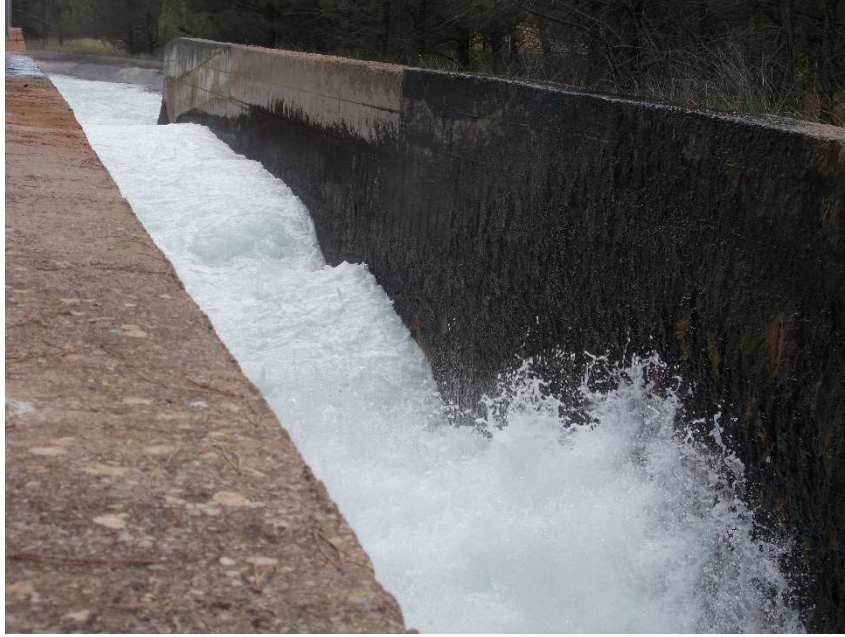
Ilustración 15. Régimen transitorio de la rápida, dissipador de energía
