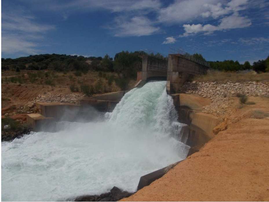
Ilustración 10. Punto de vertido al embalse de Alarcón. en el PK 92+700
