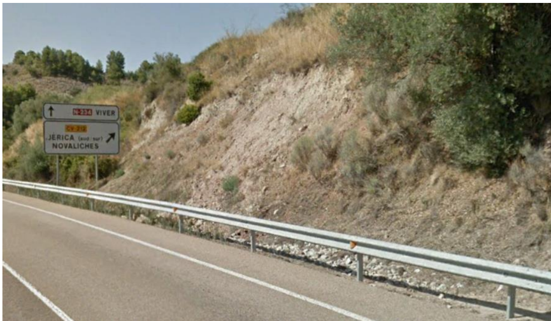
Imagen 8. Talud en desmorte en la N-234.
