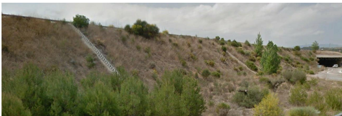
Imagen 9. Talud en terraplén de la A-23.
