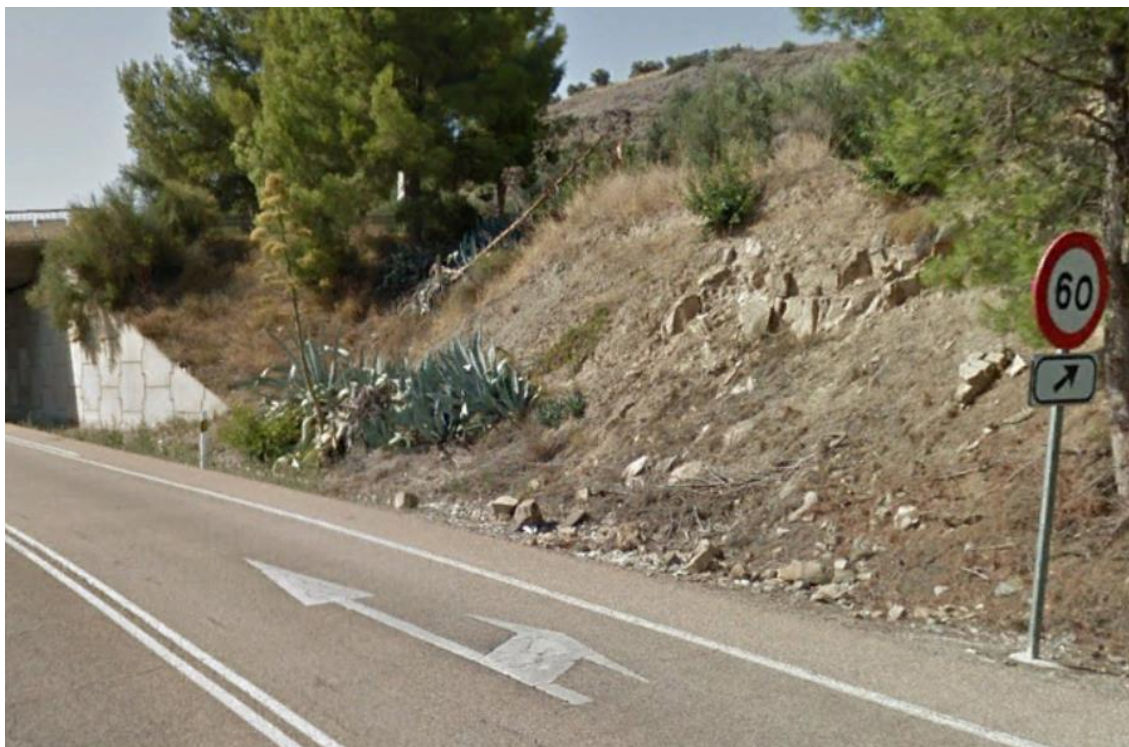
Imagen 7. Talud en desmante en la N-234.
