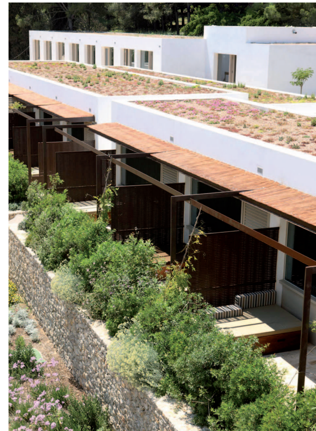
Terrazas traseras de los bloques de habitaciones 1 y 2.
