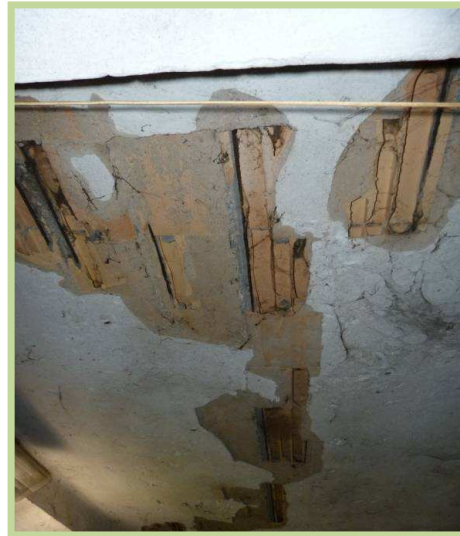
Solaio in latero cemento
