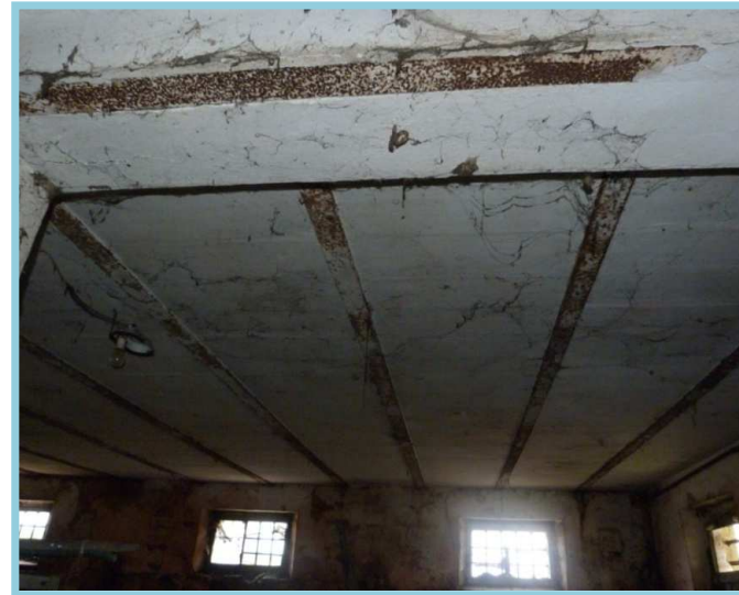
Solaio in ferro e laterizio
