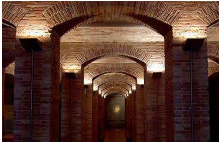
Figura 5.2. Bóvedas de ladrillo en el interior del museo.
