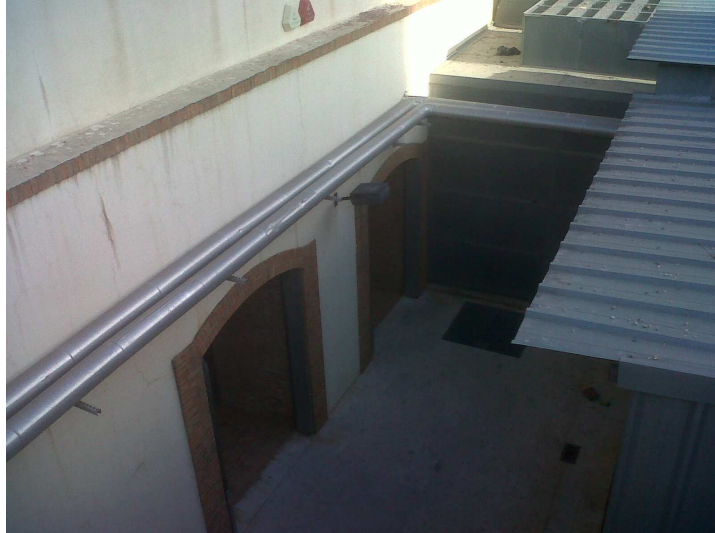
Figura 5.6. Patio exterior y puertas de acceso de la fachada este.
