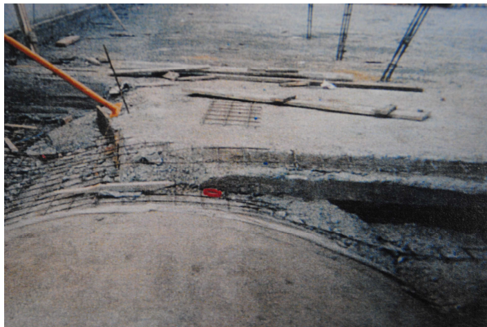
Figura 5.7. Cubierta del museo en construcción.
