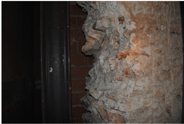
Figura 5.8. Cerramiento exterior del museo.
