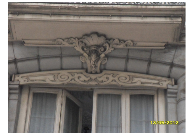
Decoración parte inferior balcones 2ª planta y superior ptas. 1ª
