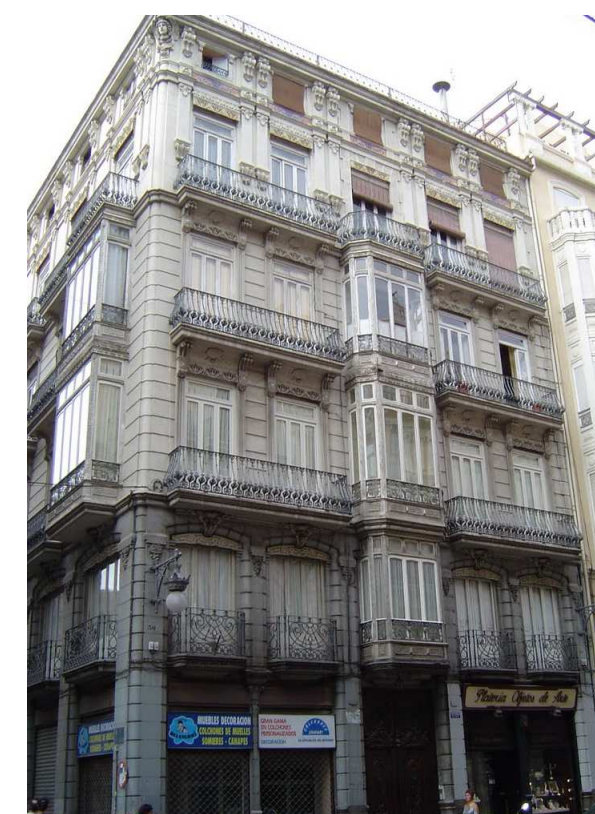
Fachada principal C/ la Paz nº 22
