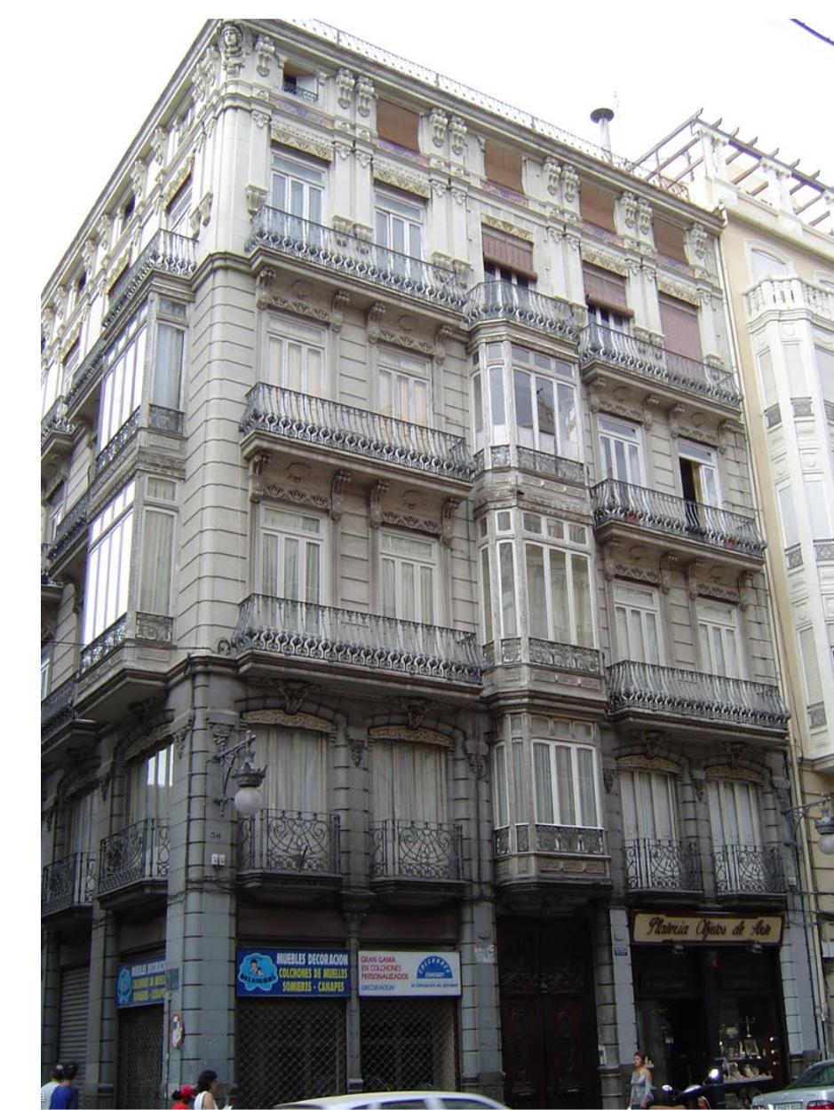
Imagen del estado actual de la fachada, Junio 2012
