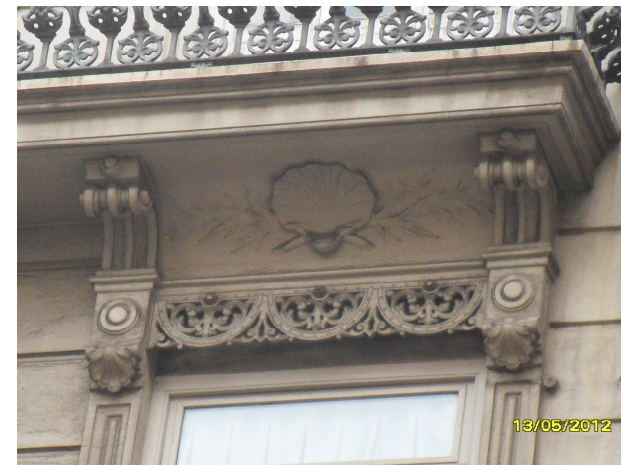
Parte superior ventanas de la 2ª a 4ª
