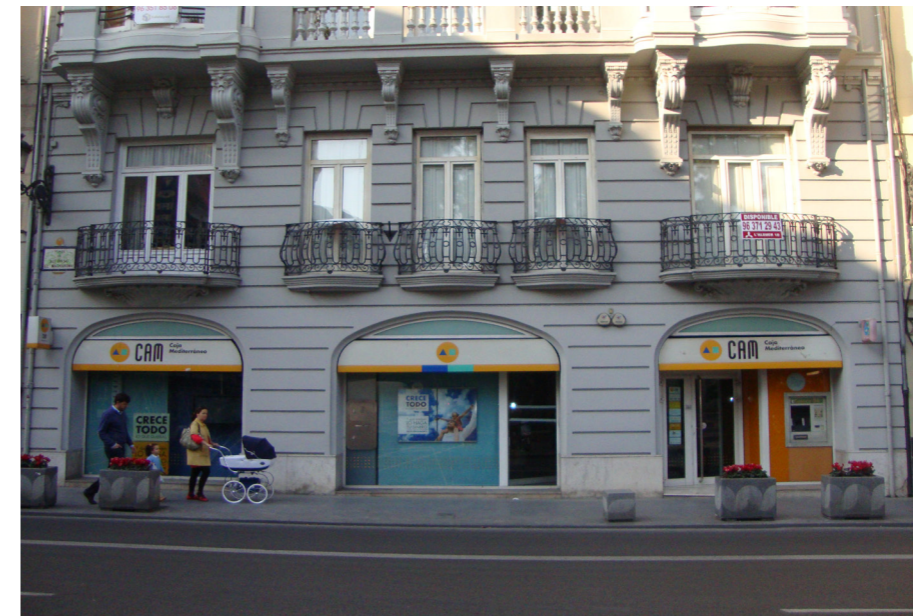
Bajo comercial en 2012. El proyecto para la realización de la oficina bancaria devuelve la identidad al bajo.
