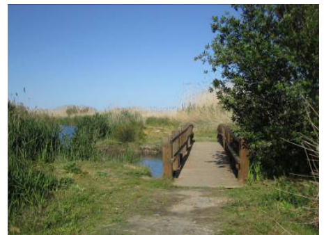
Imagen 63: Puente tipo para la zona de estudio. Fotografía propia.
