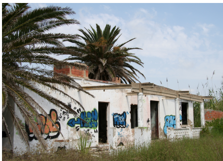
Imagen 52: Construcción abandonada 2. Fotografía propia.
