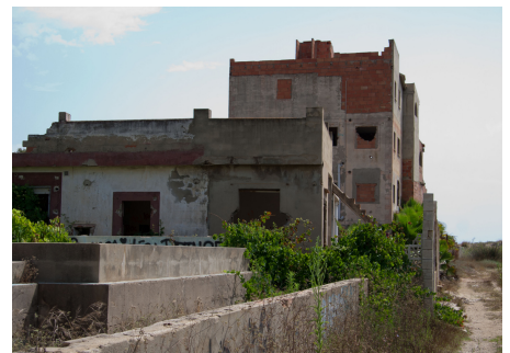
Imagen 21: Construcciones abandonadas. Fotografía propia.
