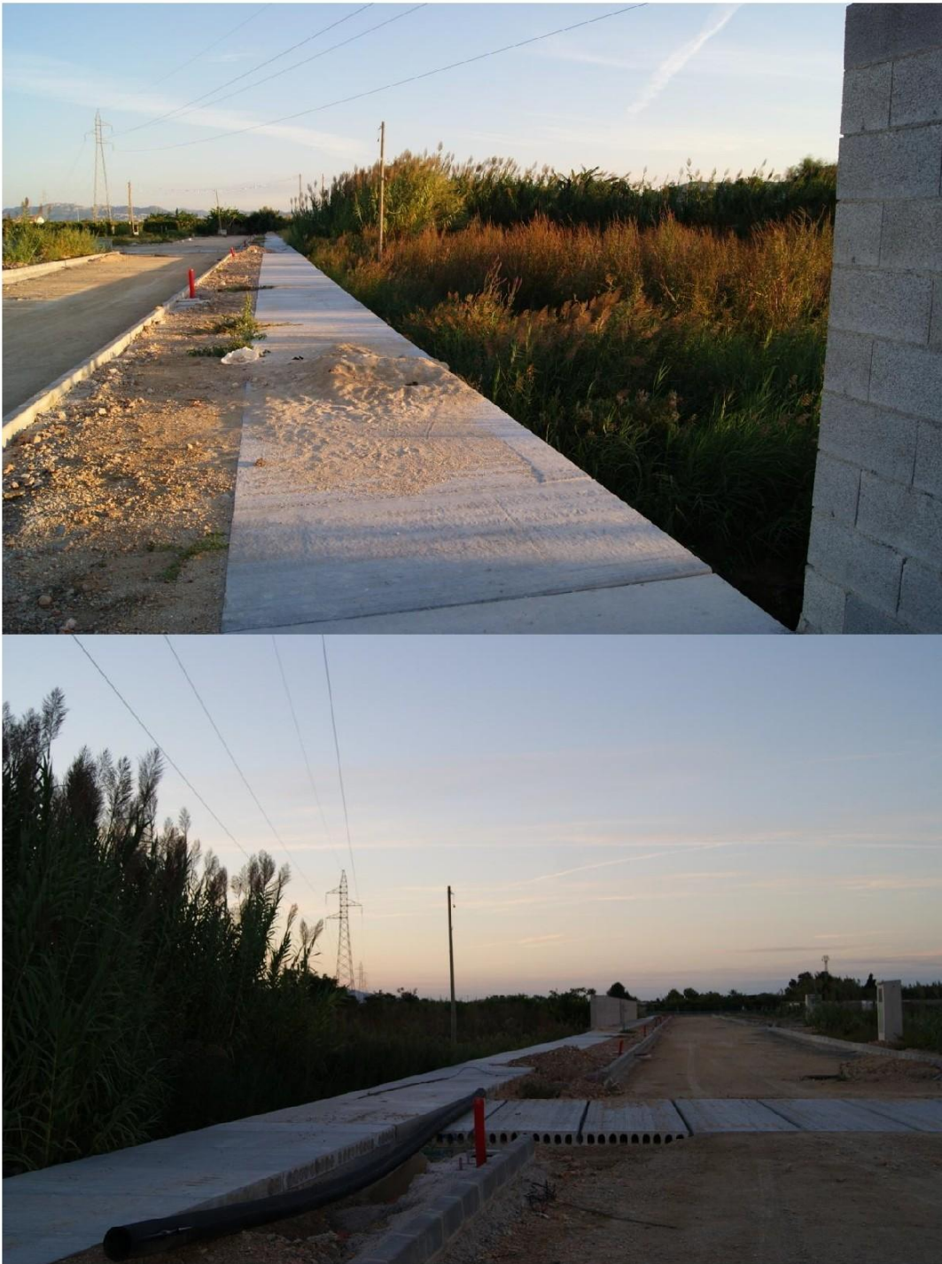
Figuras nº 29: Sector "F-H-1" playa en obras. Fuente: A utor
