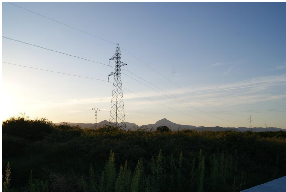
Figura nº 28: Torre de Alta Tensión en el área de estudio. Fuente: Autor
