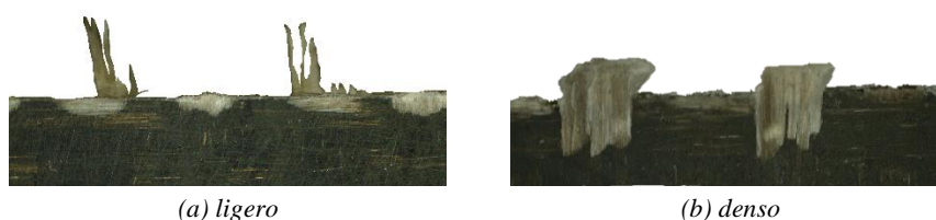
Figura 4.45. Delaminado tipo I/II: ligero y denso
