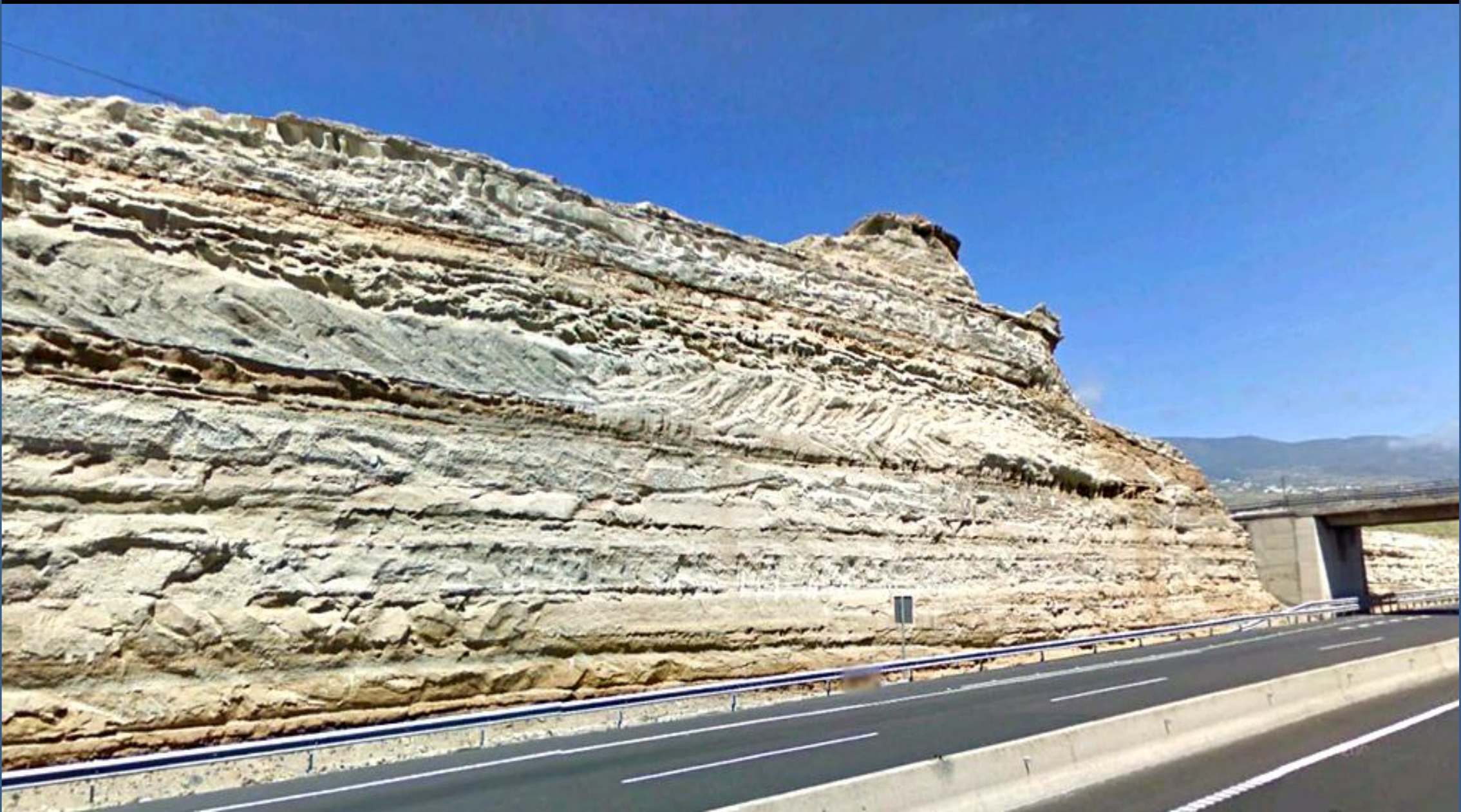
Talud de tobas pumíticas del Pleistoceno, Cuaternario. SE de Fasnia, SE Hoja. Las Honduras, Tenerife.
