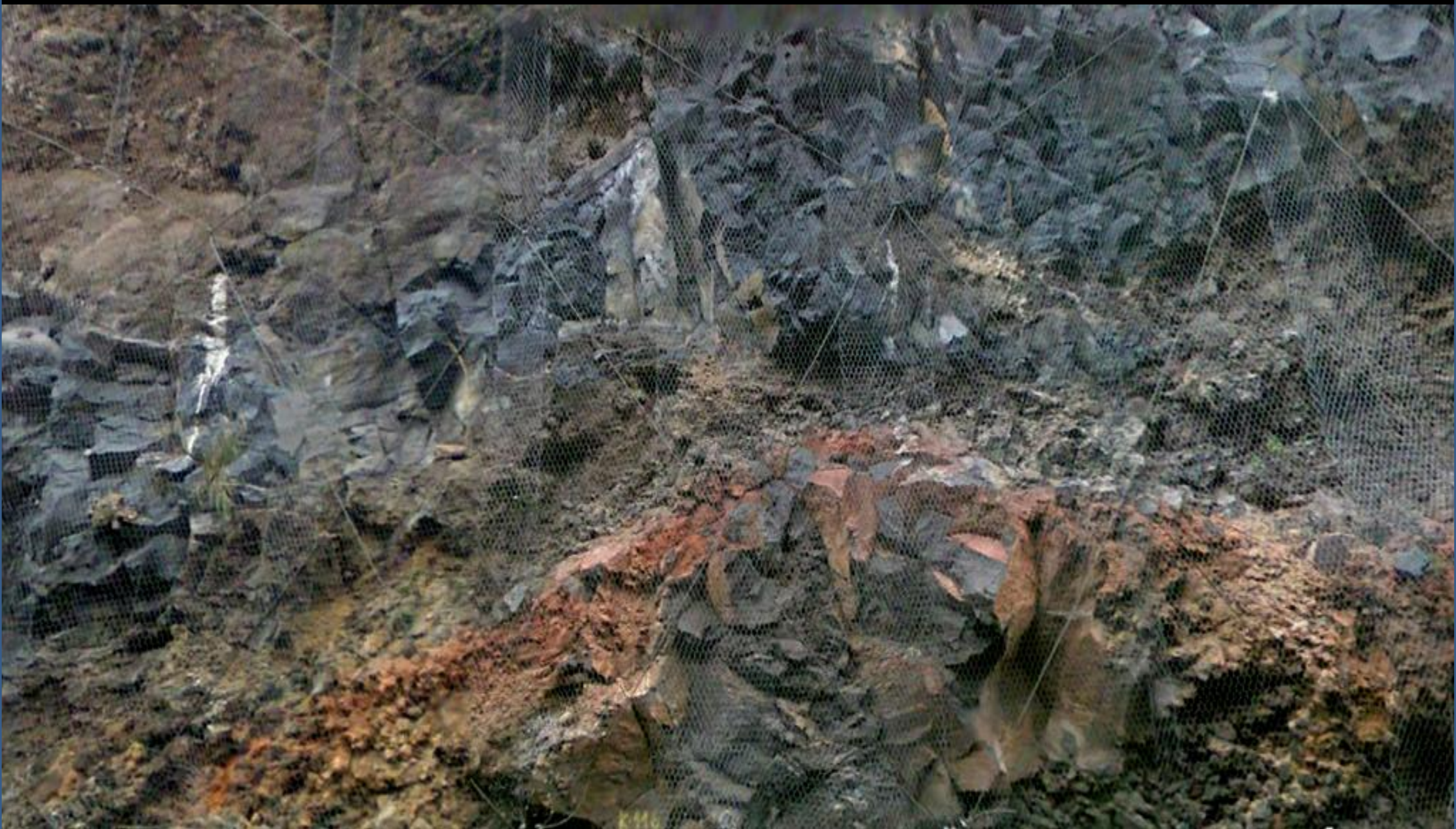
Detalle de anterior: Mallazo en talud de coladas de traquibasaltos, Serie II, Pleistoceno Inf. Caserío Los Menores. Centro NE Hoja de Adeje, Tenerife SW.
