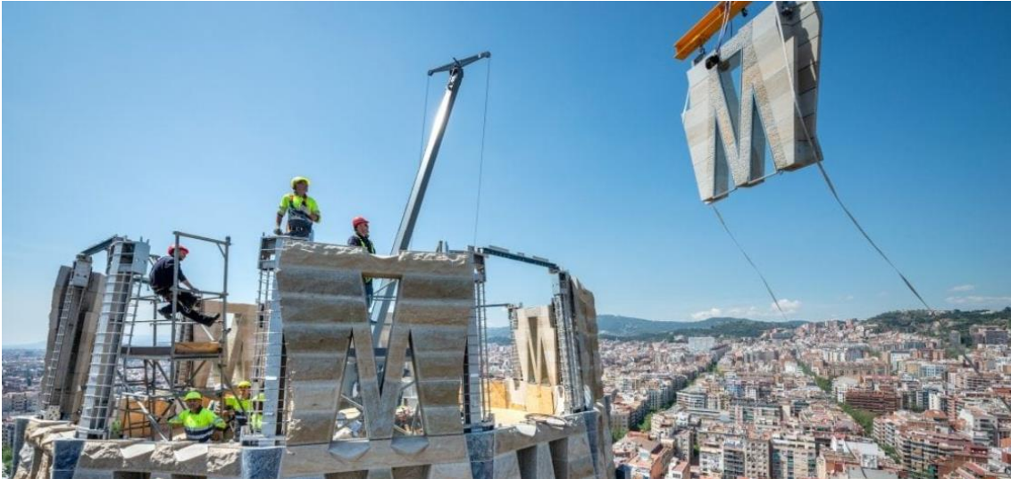
Figura 24: Paneles prefabricados de piedra postesada.
