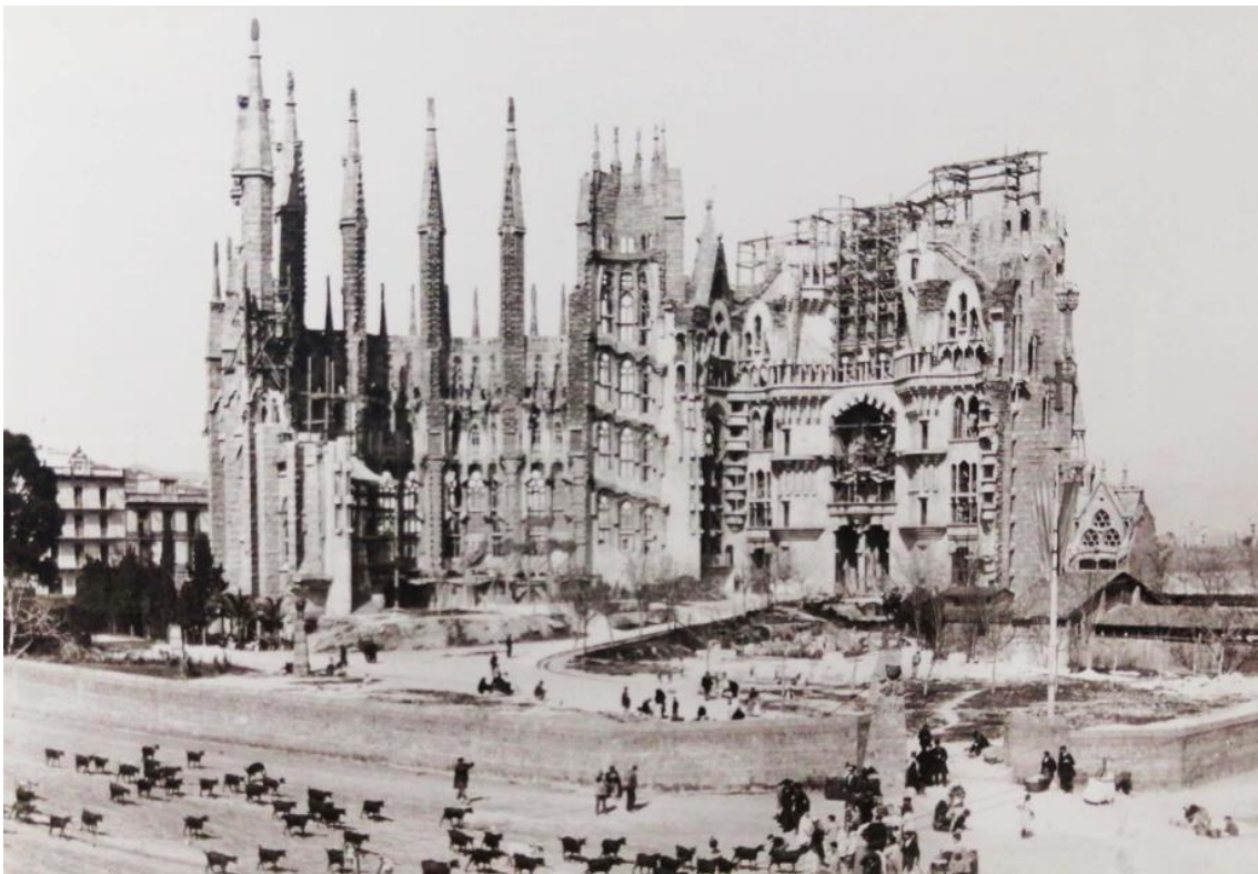
Figura 2: Ábside completado y fachada del Nacimiento en construcción.
