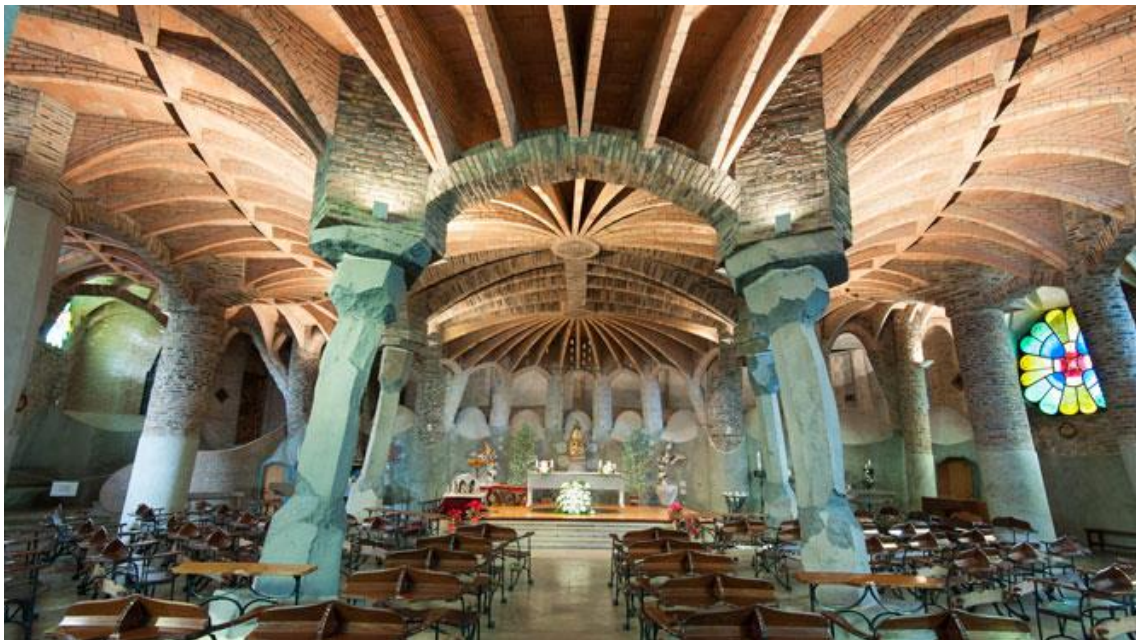
Figura 6: Vista interior de la Cripta de la Colònia Güell. Se aprecian los arcos catenarios del techo.
