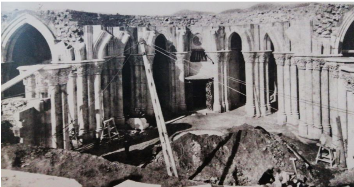
Figura 1: Cripta en construcción.
