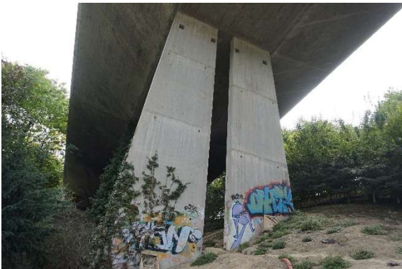
Detalle de las pilas trapezoidales.
