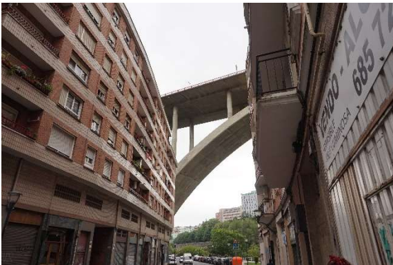
Comparativa de escala entre el puente y los edificios colindantes.
