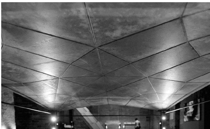
Ilustración 36. Vista de la bóveda desde el interior.
