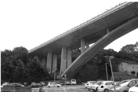
Ilustración 18. Vista del tablero, pilas y arco.
