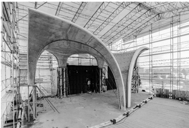
Ilustración 33. Construcción de la cubierta de HiLo.
