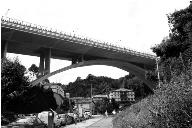
Ilustración 17. Viaducto de Morlans, San Sebastián.
