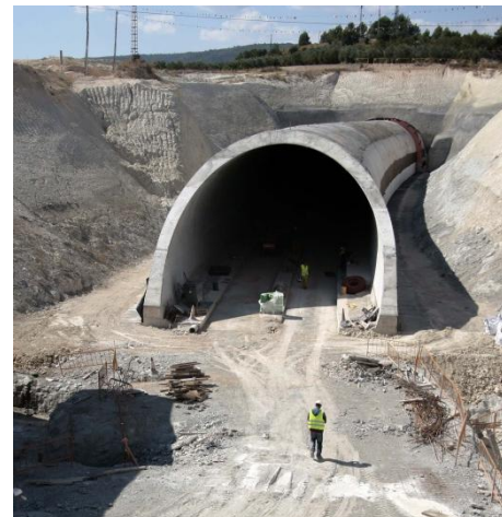
Figura 6.7 Falso túnel sin relleno de tierras. Día 27/09/2011.
