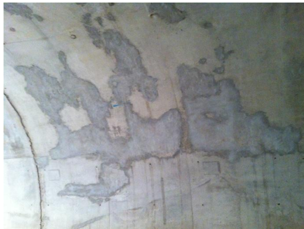
Figura 6.29. Reparaciones realizadas en la sección instrumentada.
