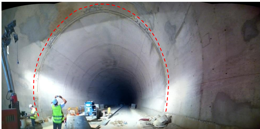
Figura 6.6 Sección de túnel instrumentada indicada con una traza de color rojo discontinua.
