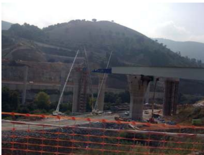
Figura 11. Vista del cajón metálico que forma la variante Sur Metropolitana de Bilbao, en el instante de su lanzamiento.
