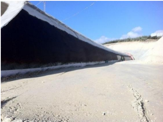
Figura 6.7 Falso túnel sin relleno de tierras. Día 27/09/2011.
