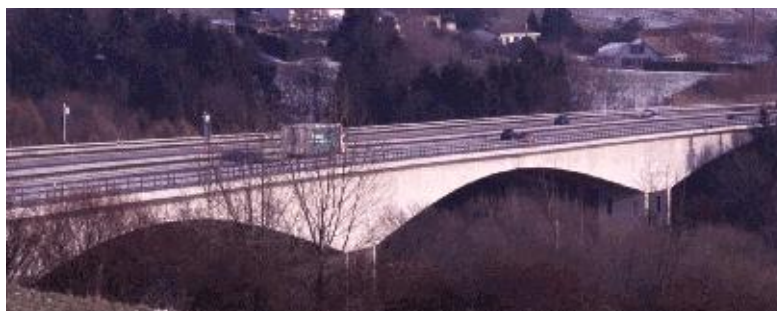
Figura 2.36 Vista del puente Lutrive en Suiza.
