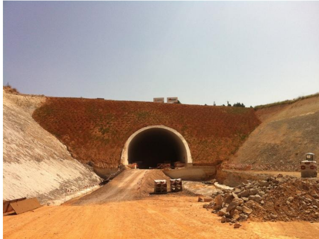
Figura 6.8. Relleno de tierras finalizado. Día 15/05/2012.
