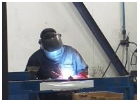
Imagen 36. Soldadura Manual. Fuente: Datos empresa. Elaboración propia
