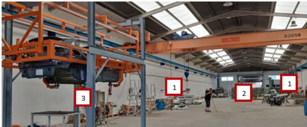
Imagen 11. Vista general nave 3. Fuente: Datos de empresa. Elaboración propia
