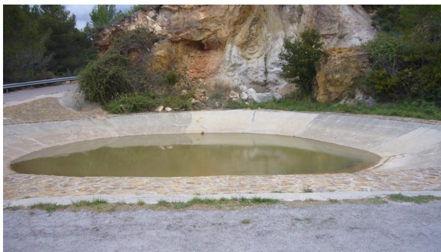
Imagen 22. Fotografía de una balsa de yeso en las a fueras de Pavías. 12 de Abril de 2012.
