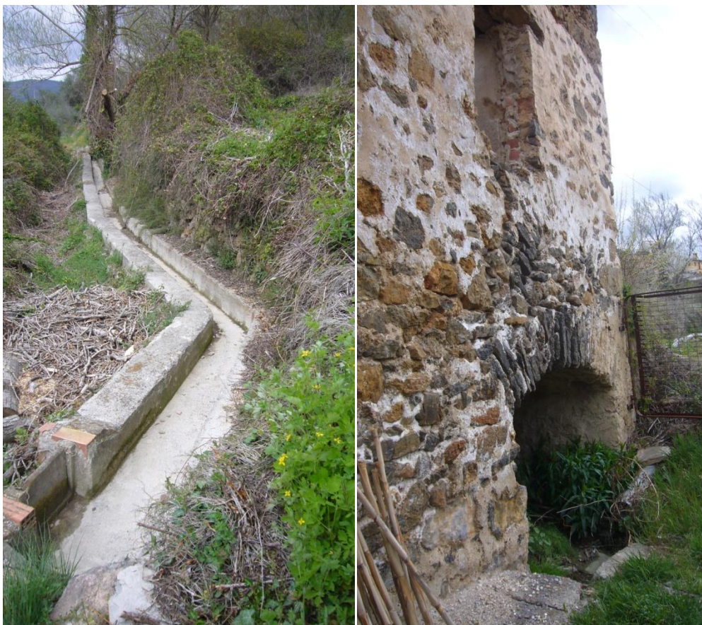
Imágenes 41 y 42. Fotografía del exterior de un molino, con su canal de agua. Pavías. 12 de Abril de 2012.
