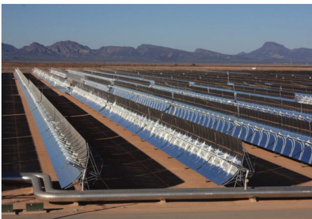
Figura 1: En la imagen se pueden ver los lazos compuestos por espejos parabólicos y sus puntos de conexión con los colectores de fluido caloportador (FC) frío y caliente. La imagen se corresponde con la Solana Station Energy en Phoenix, Arizona: https://n9.cl/a0grx
