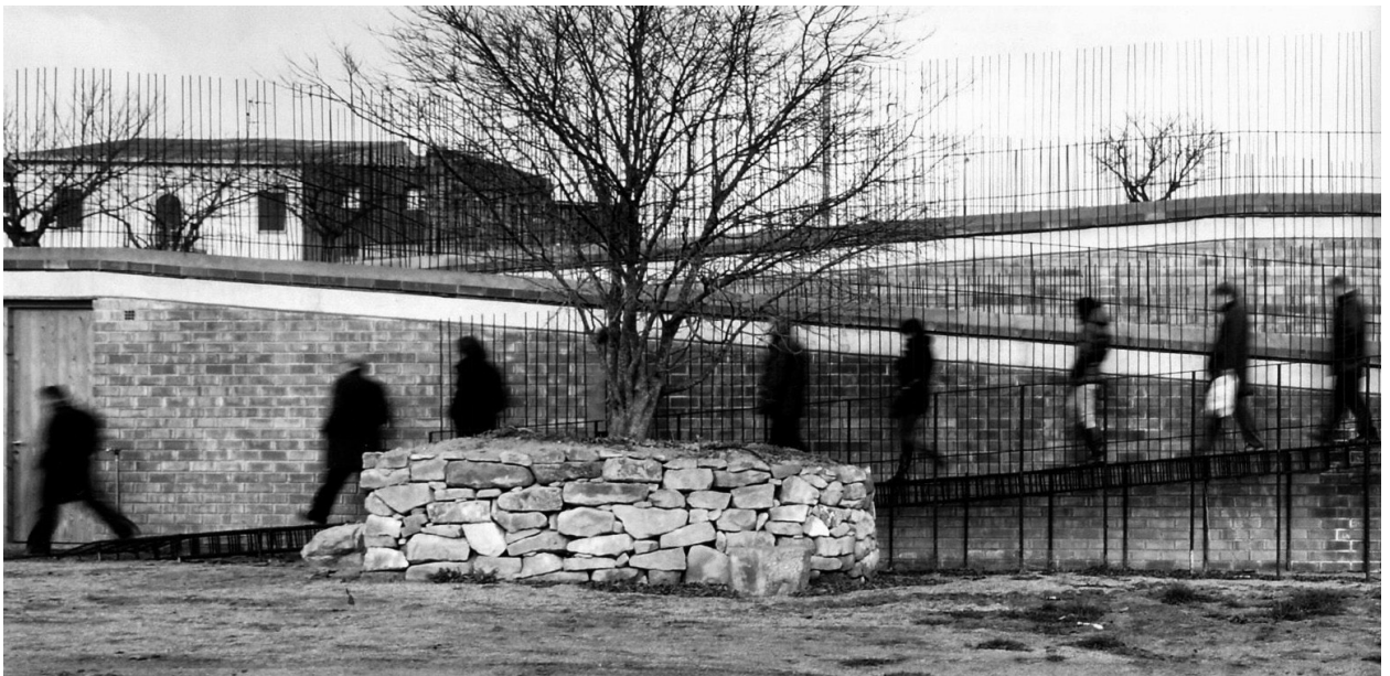
fig. 25_Vista centrada de la rampa principal.
