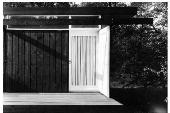
fig. 22_Vistas exteriores del porche frontal.
