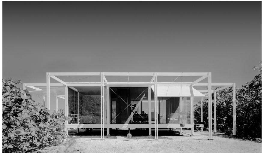
fig. 35_Vista de la fachada.
