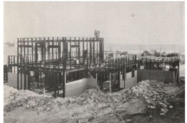
fig. 44_La vivienda en construcción en fase estructural.
