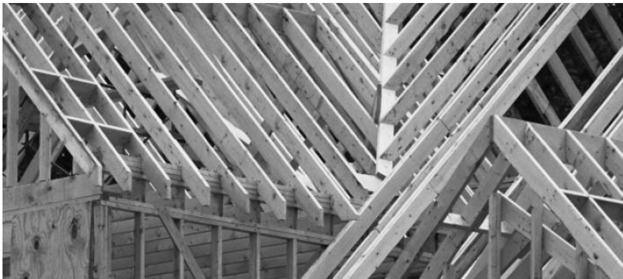
fig. 40_Detalle de Wood frame .
