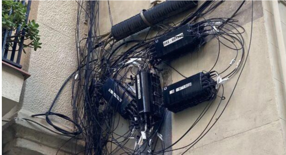
Ilustración 22: Ejemplo de tendido de red e instalación de CTO en fachada
