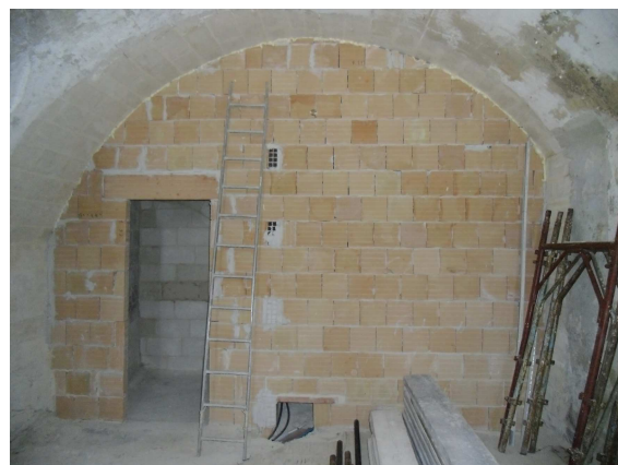
A. Parete restaurata con nuovo bagno
