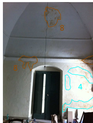
C . (4) Distacco di tinteggiatura e (8) Macchie
