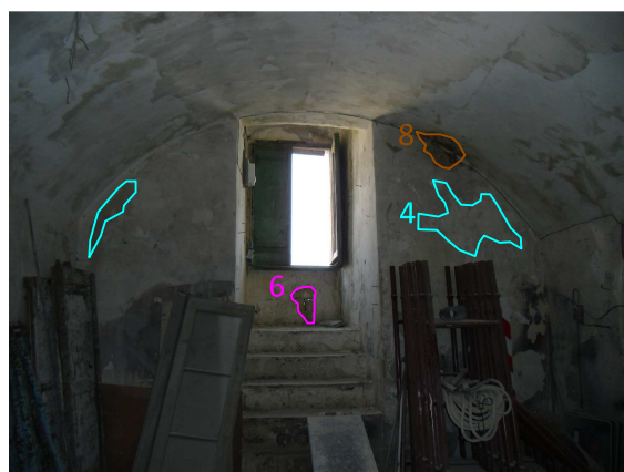
C. (4) Distacco di tinteggiatura, (6) Distacco di intonaco e (8) Macchie
