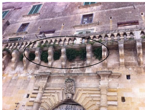
Fig.17 Balcone facciata nord (Palazzo Santoro-Bronzini)
