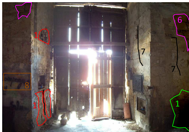
C. (1) Disgregazione, (5) Patina biologica, (6) Distacco di intonaco, (7) Fratturazione e (8) Macchie
