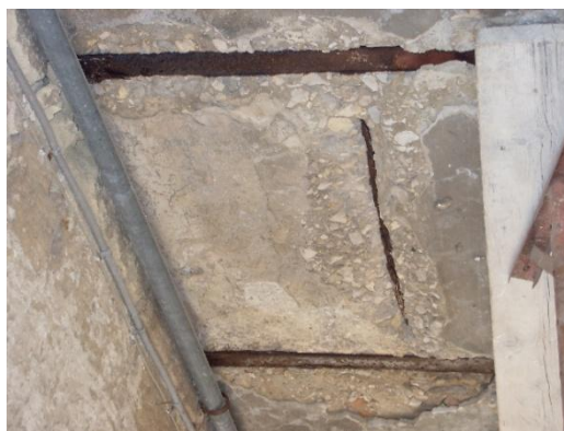
Fig.11 Balcone facciata sud (Palazzo Santoro-Bronzini)
