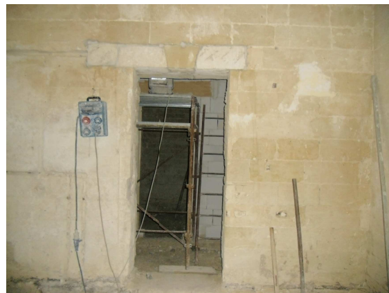
A. Parete in fase di restauro
