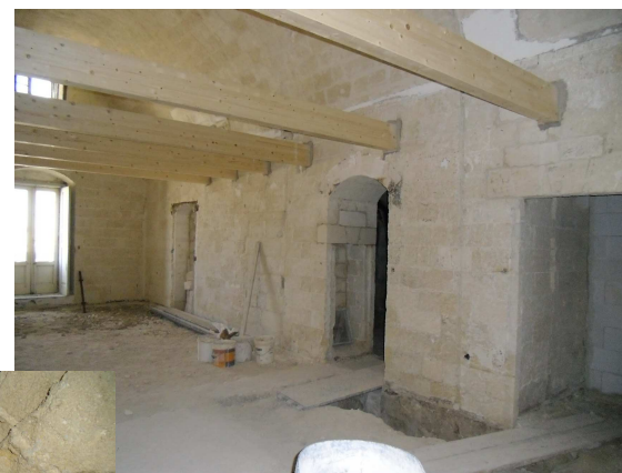
B. Parete restaurata
