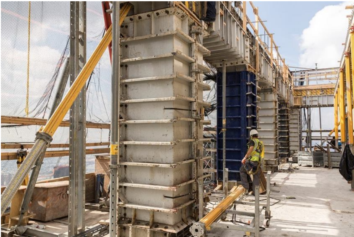
Imagen 46. Imagen encofrados metálicos en pilares y red de seguridad. Fuente: Concrete Construction (Rehana, 2015)
