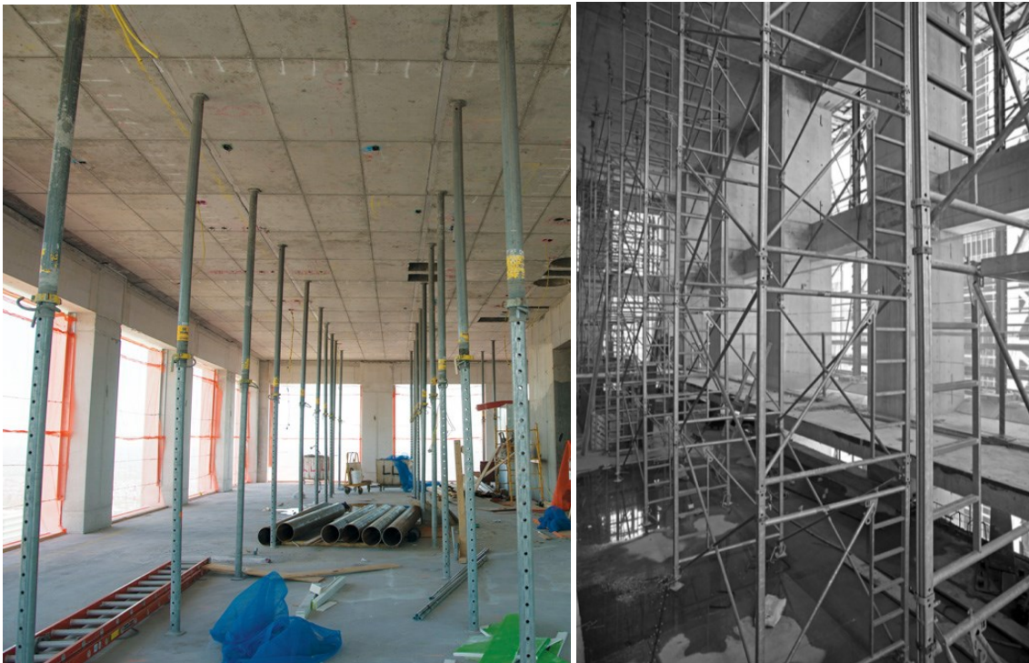
Imagen 40. Vista interior de la losa maciza y puntales. Fuente: 432 Park (Marcus et al., 2018)
