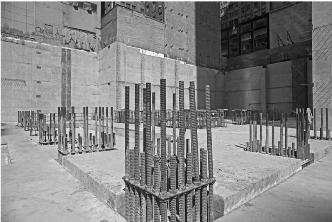
Imagen 39. Armaduras de espera en el sótano. Fuente: 432 Park (Marcus et al., 2018)
