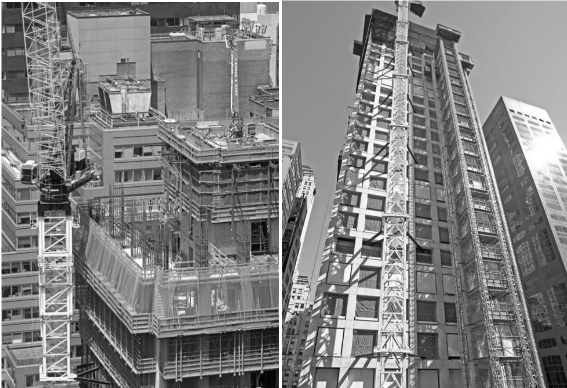
Imagen 42 (derecha). Construcción del núcleo previa al perímetro y grúa. Fuente: 432 Park Avenue by Rafael Viñoly (Lalueta, 2013) Imagen 43 (izquierda). Grúa conectada a la estructura y elevador. Fuente: 432 Park Avenue (Rafael Viñoly Architects, 2021)
