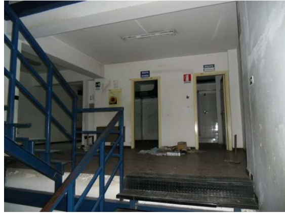
ACCESSO AL PRIMO PIANO
