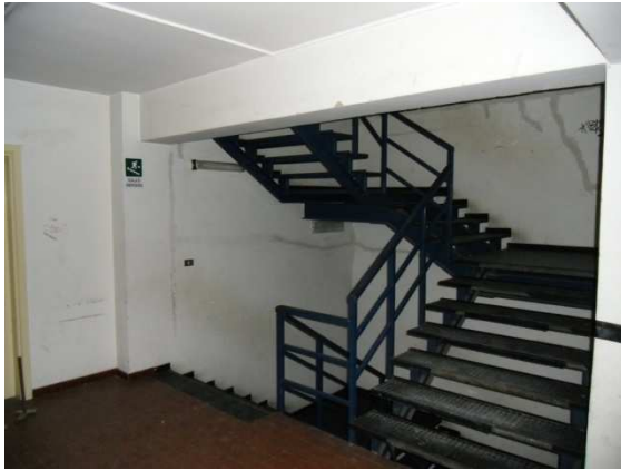
SCALA CENTRALE AL PRIMO PIANO
