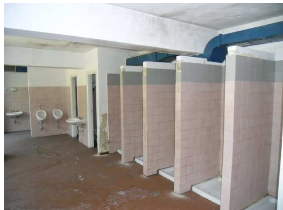
SPOGLIATOIO PRIMO PIANO
