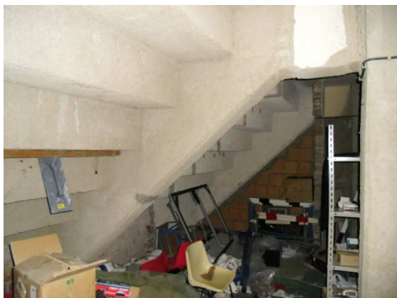
DEPOSITO SOTTO LA TRIBUNA
