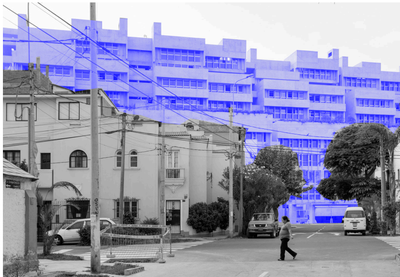
Fig. 9_ Vista de la fachada sur de la UTEC.
