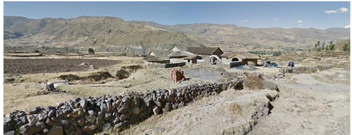
Construcción sobre suelo agrícola en las inmediaciones de Coporaque, la cual no cuenta con permisos. Archivo AECID.
