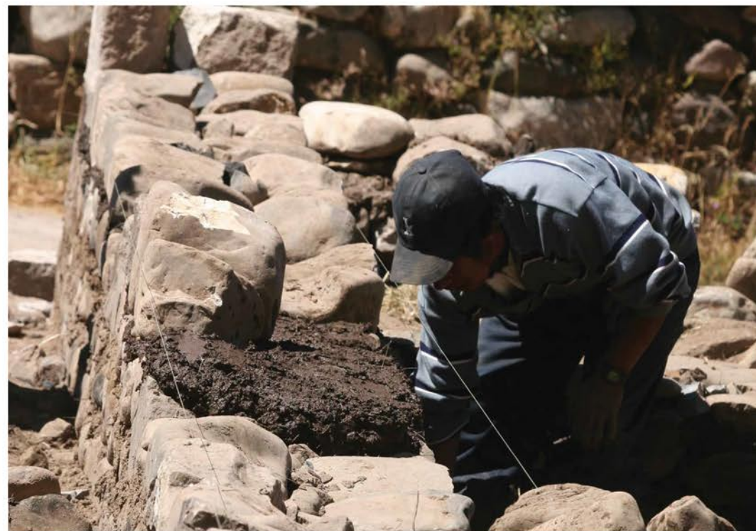
Poblador de Coporaque trabajando en la construcción de su vivienda con amteriales locales. Archivo AECID.
