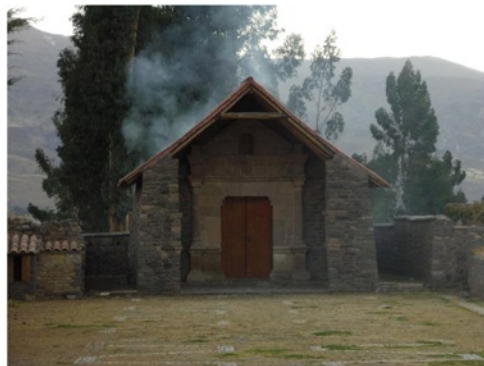
Capilla de San Sebastián, Coporaque. Diversos cronistas afirman que fue la primera capilla que se construyó en el Valle del Colca, aproximadamente en 1565. Foto: Cristina Moreno F.
