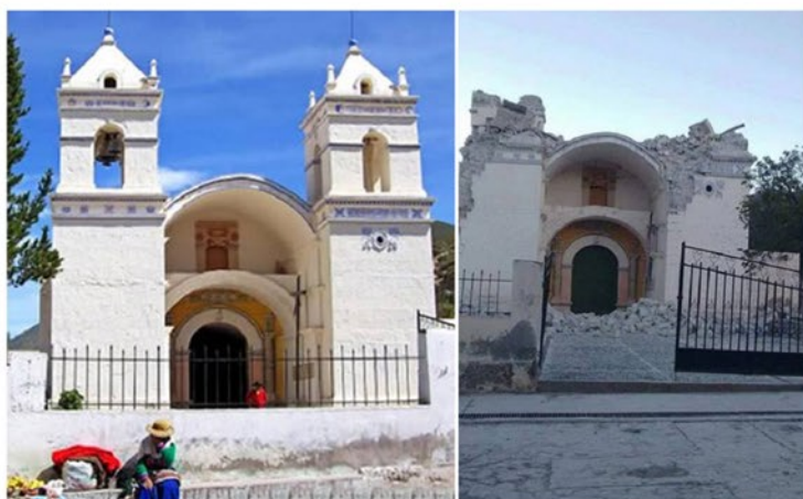
Iglesia de Ichupampa, antes y después del terremoto de 2016. Fuente AUTOCOLCA.
