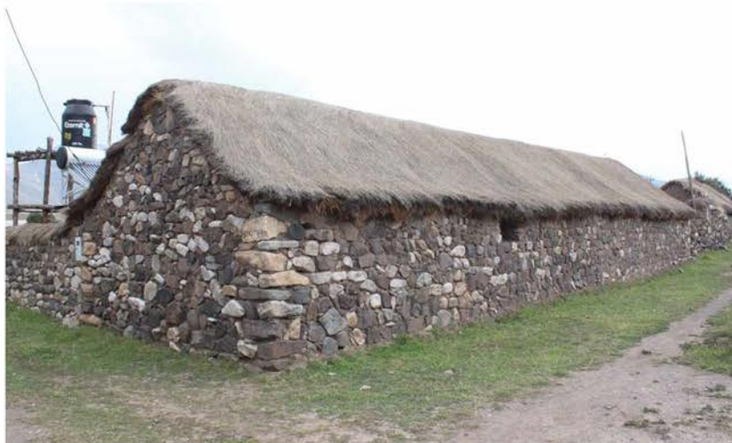
La mayoría de viviendas cuentan con conexión a la red de abastecimiento de agua y de energía eléctrica. Archivo propio
