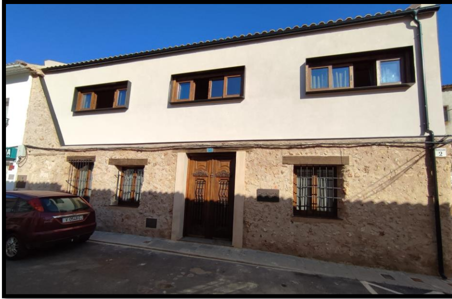
Ilustración 2: fotografía fachada de la Casa rural
