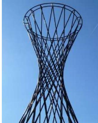
**Figura 1.** Estructura de acero cuya geometría es una superficie reglada conocida como *hiperboloides hiperbólico*.
