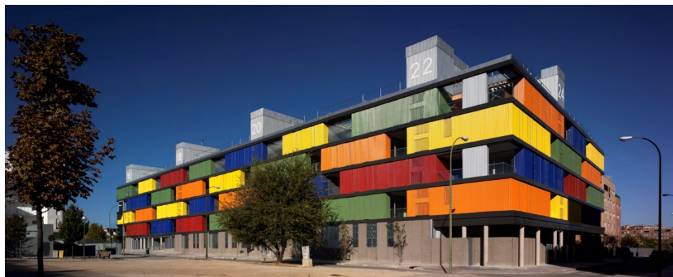
Imagen 31. Edificio de viviendas en Carabanchel
