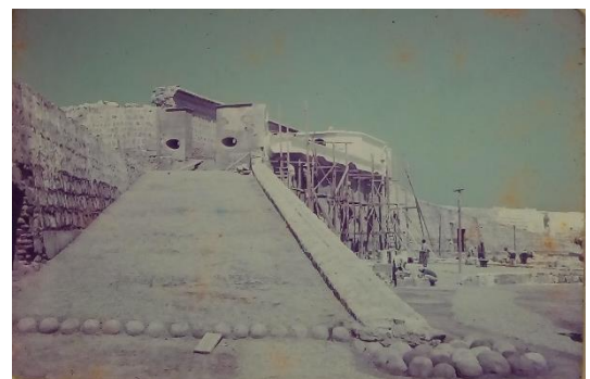
Figura 49: Restauración de las rampas de accesos.
