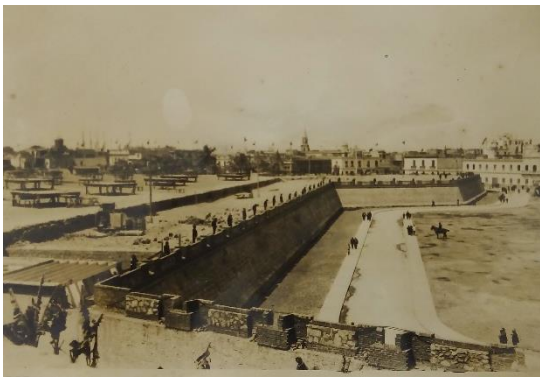
Figura 40: Restauración de las murallas y construcción del parapeto. Fuente: Archivo del arquitecto Víctor Pimentel, 2018.
