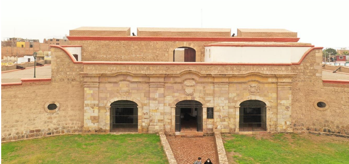
Figura 100: Caballero del baluarte de San Felipe, se puede apreciar lo reconstruido (con la piedra expuesta) y lo reconstruido (acabado en yeso). Fuente: Archivo fotográfico personal, 2020.
