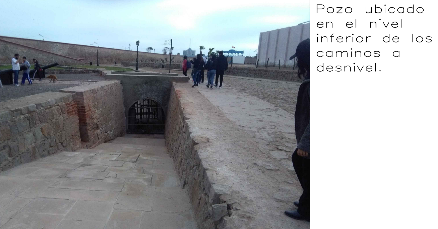
5.- POZO Y PASO A DESNIVEL
