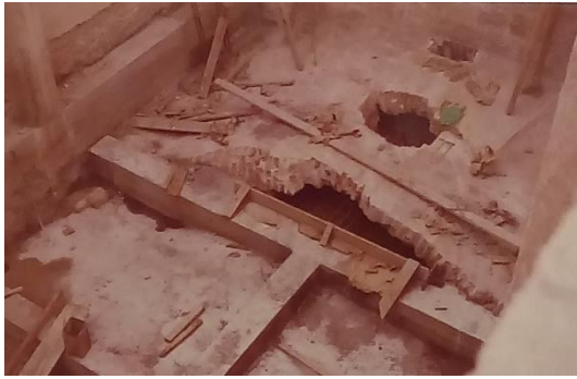
Figura 44: Restauración de las murallas y construcción del parapeto.
