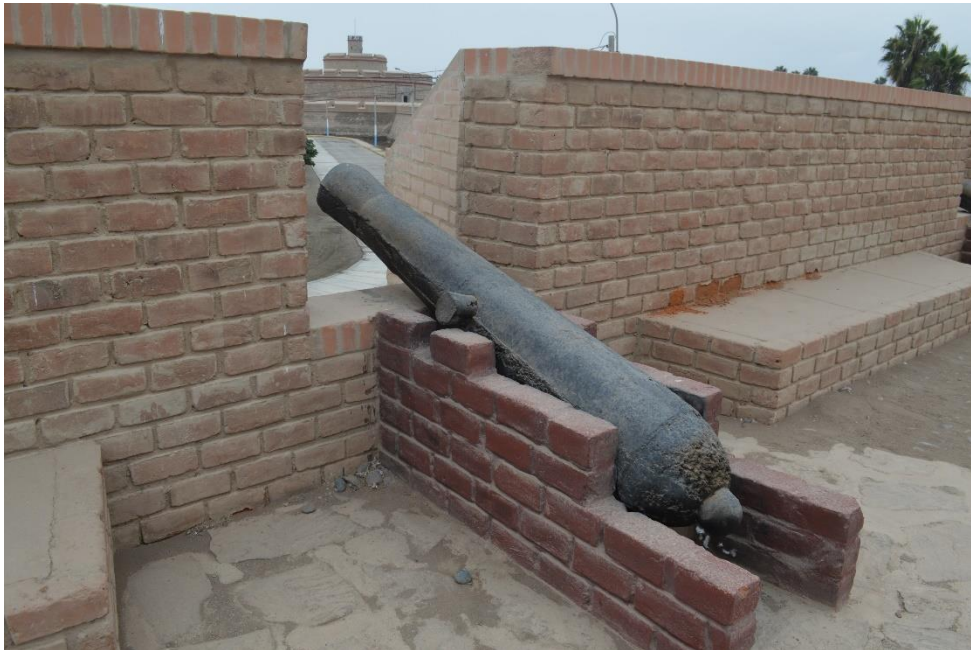
Figura 111: Parapeto reconstruido de ladrillo Fuente: Archivo fotográfico personal, 2020.
