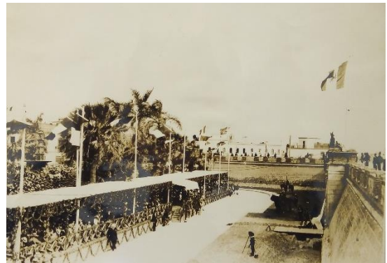
Figura 41: Restauración de las murallas y construcción del parapeto. Fuente: Archivo del arquitecto Víctor Pimentel, 2018.
