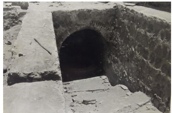
Figura 43: Paso a desnivel y poso subterráneo descubierto. Fuente: Archivo del arquitecto Víctor Pimentel, 2018.
