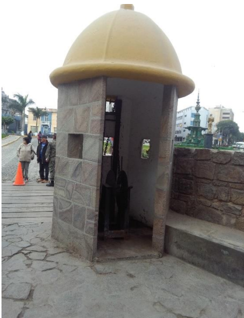
Figura 115: Garita del puente levadizo Fuente: Archivo fotográfico personal, 2020.
