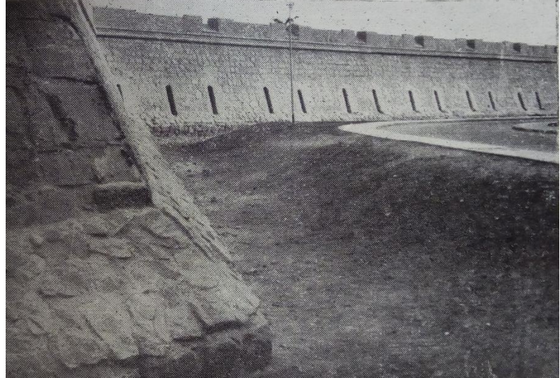
Figura 94: Vista exterior del Museo del Real Felipe (1957), se puede observar las ventanas abiertas en la muralla para la iluminación de las salas. Fuente: Archivo del arquitecto Víctor Pimentel, 2018.
