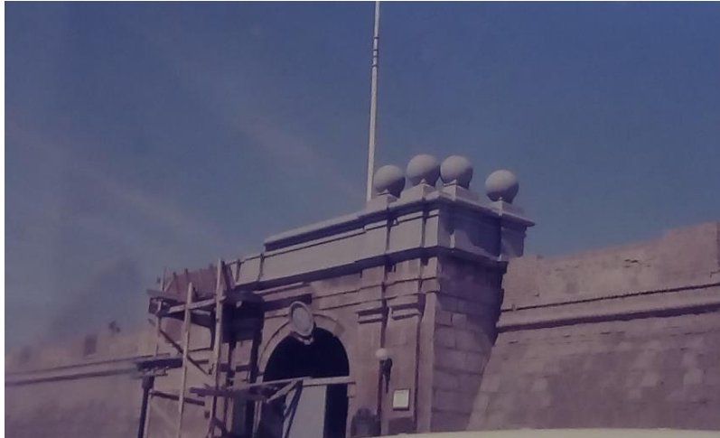
Figura 105: Trabajos de restauración en la Puerta Real (1973) Fuente: Archivo del arquitecto Víctor Pimentel, 2018.
