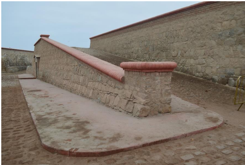
Figura 108: Rampa de ascenso reconstruida con la misma técnica constructiva que la original. Fuente: Archivo fotográfico personal, 2020.
