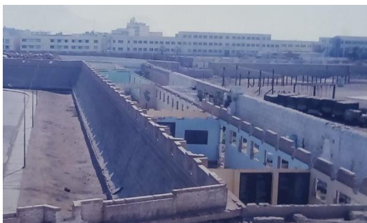
Figura 48: Restauración del camino de ronda.
