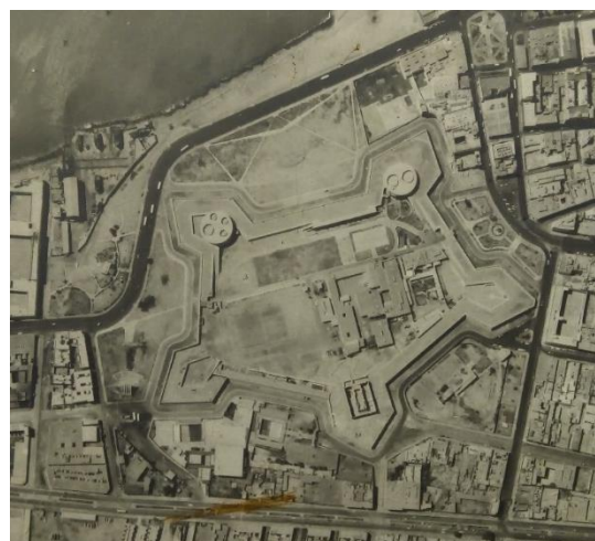
Figura 31: Fotografía aérea de la Fortaleza del Real Felipe (1984). Fuente: Archivo del arquitecto Víctor Pimentel, 2018.
