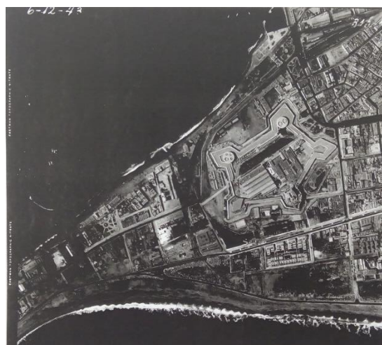
Figura 30: Fotografía aérea de la Fortaleza del Real Felipe (1943). Fuente: Archivo del arquitecto Víctor Pimentel, 2018.
