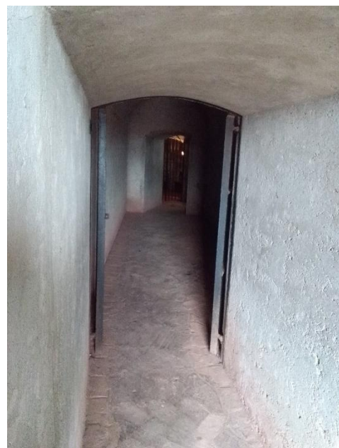
Figura 116: Interior de concreto del caballero del baluarte del Rey Fuente: Archivo fotográfico personal, 2020.
