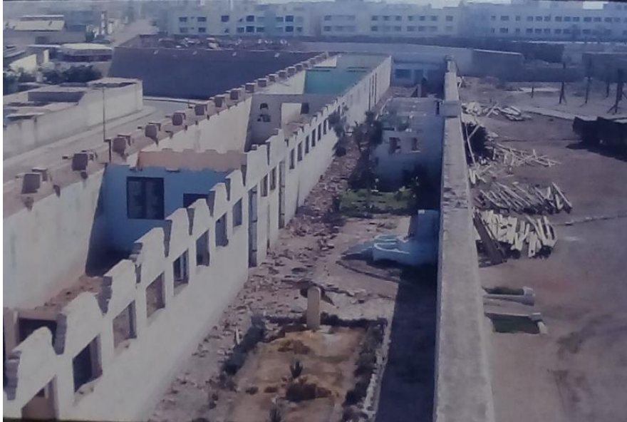
Figura 103: Demolición de las oficinas ubicadas dentro de la muralla para la reconstrucción del camino de ronda (1974) Fuente: Archivo del arquitecto Víctor Pimentel, 2018.
