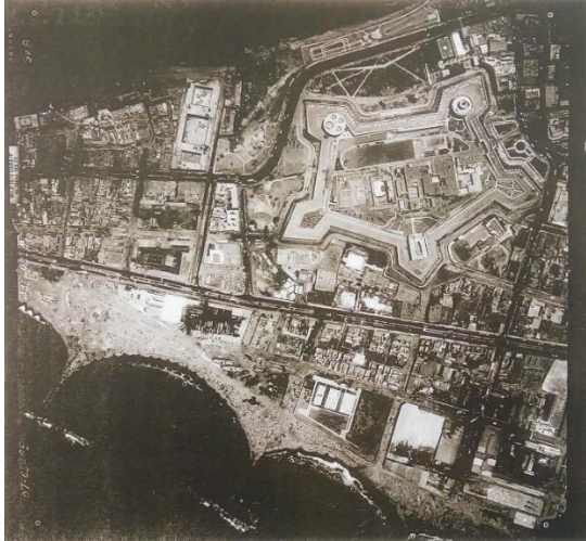
Figura 32: Fotografía aérea de la Fortaleza del Real Felipe (1995). Fuente: Archivo del arquitecto Víctor Pimentel, 2018.
