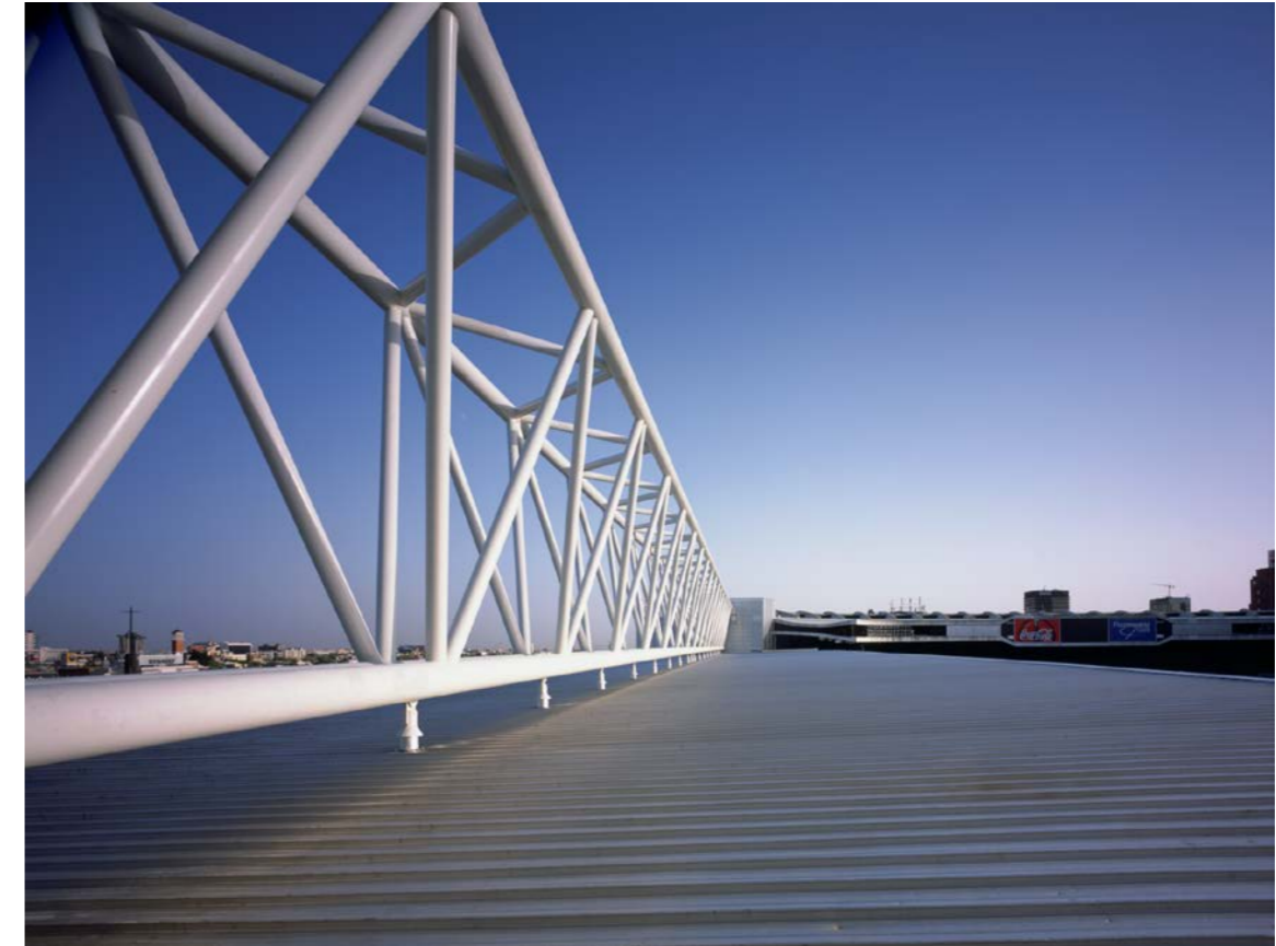
Figura 81. Vista de la cubierta este del Santiago Bernabéu tras la reforma de 2002.
