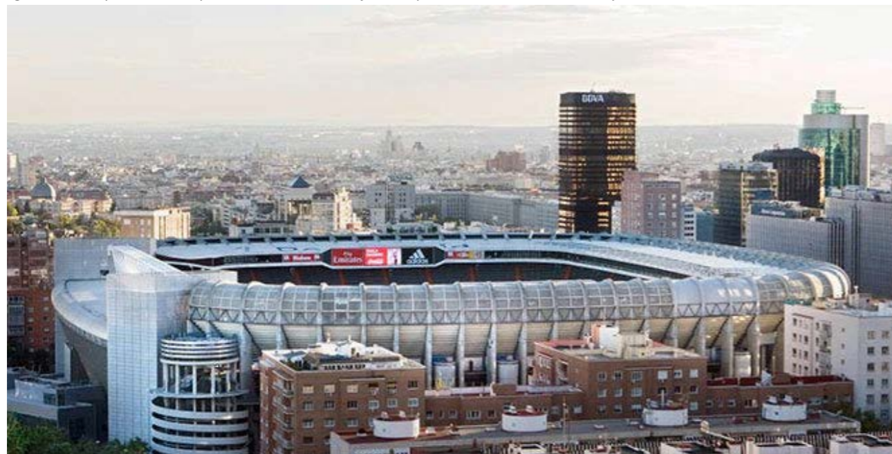
Figura 26. Vista aérea del Santiago Bernabéu en su estado previo a la reforma de 2019.
