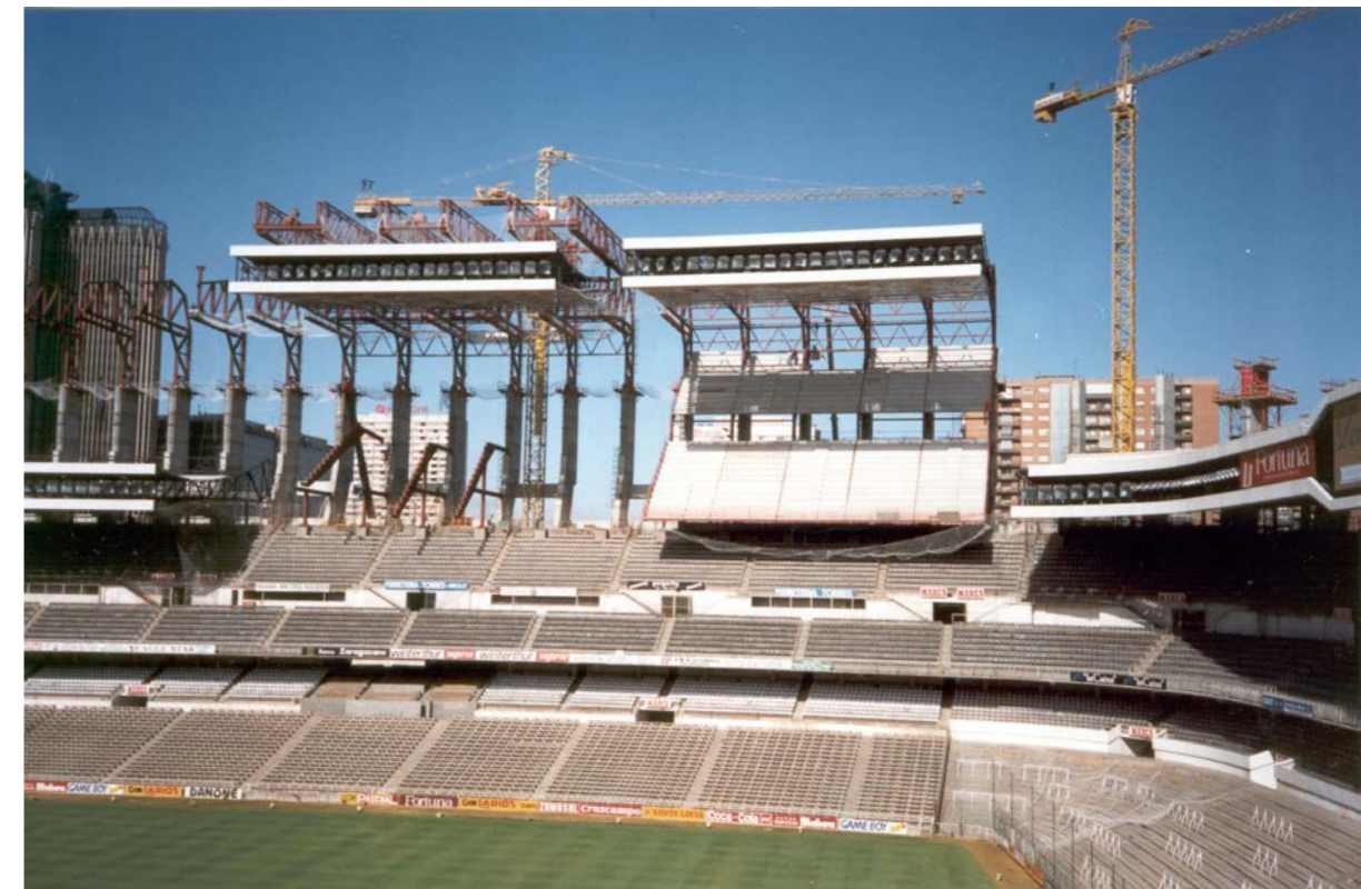
Figura 91. Vista del lateral oeste durante la reforma de 1992.
