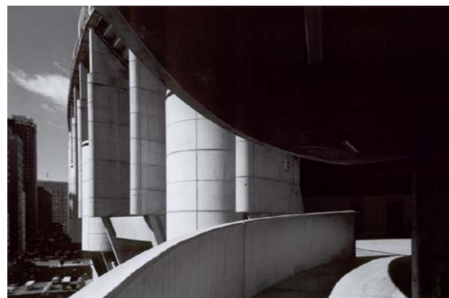
Figura 53. Acceso desde una de las torres a los niveles superiores.
