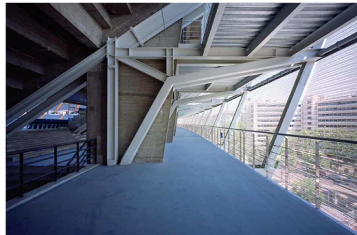
Figura 54. Circulación exterior de los niveles superiores del lateral este tras la reforma de 2002.
