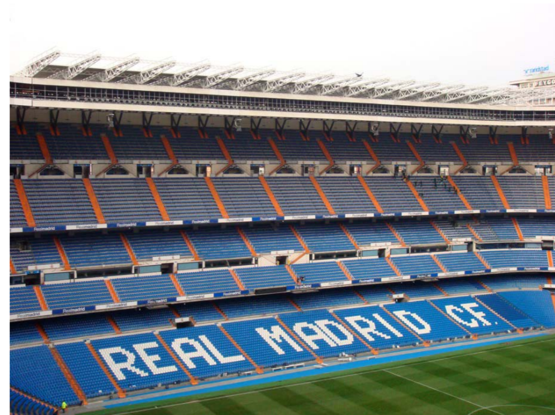
Figura 61. Vista interior del graderío del lateral oeste tras la reforma de 2002.
