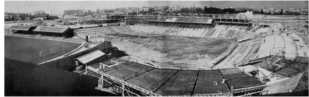
Figura 83. Vista del encuentro entre los dos estadios durante la fase inicial de construcción en 1945.
