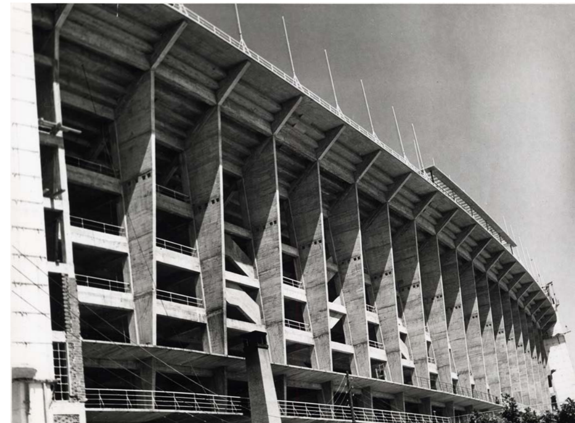
Figura 87. Vista exterior de la fachada y sus aletas tras la reforma de ampliación del lateral este de 1954.
