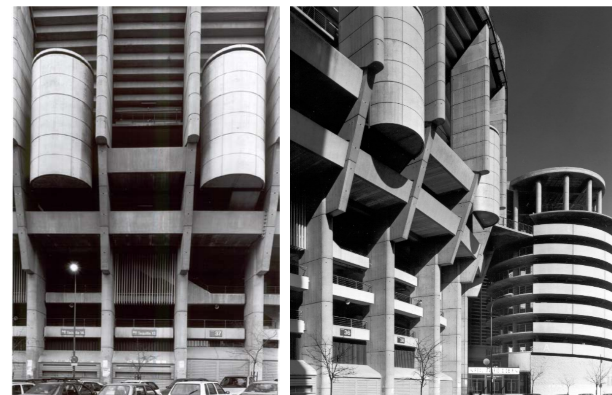
Figura 55. Vistas exteriores de las escaleras cilíndricas de fachada tras la reforma de 1992.
