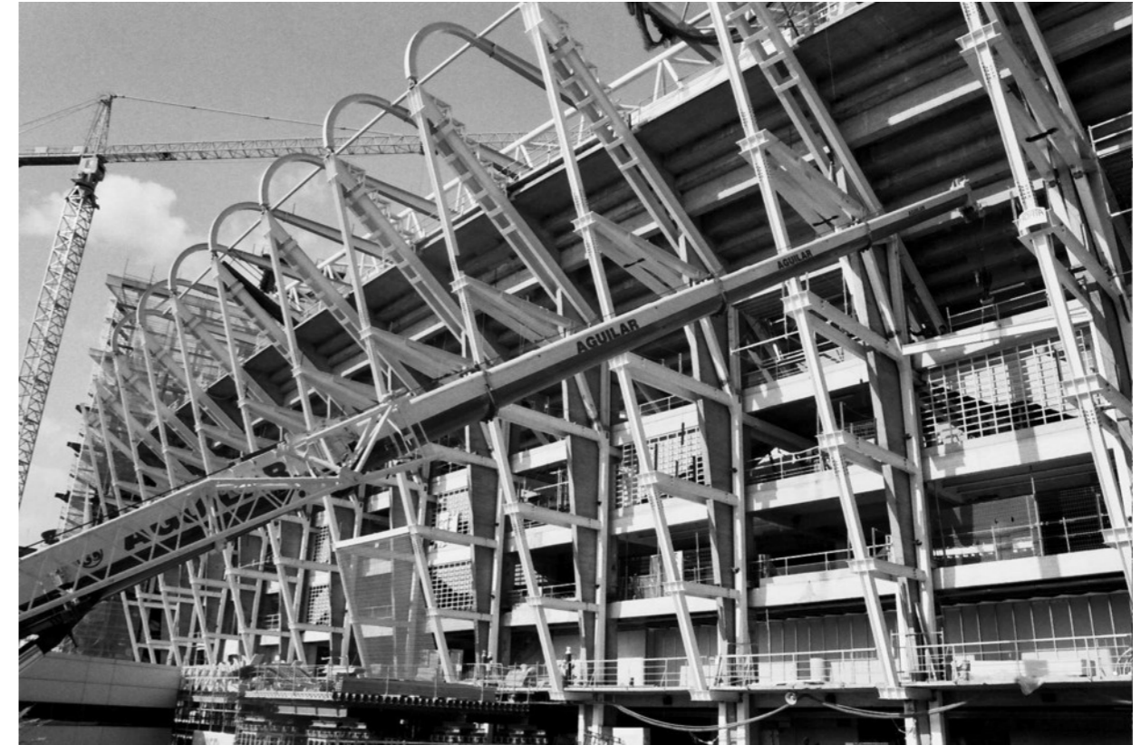
Figura 72. Vista exterior del lateral este del Santiago Bernabéu durante la reforma de 2002.
