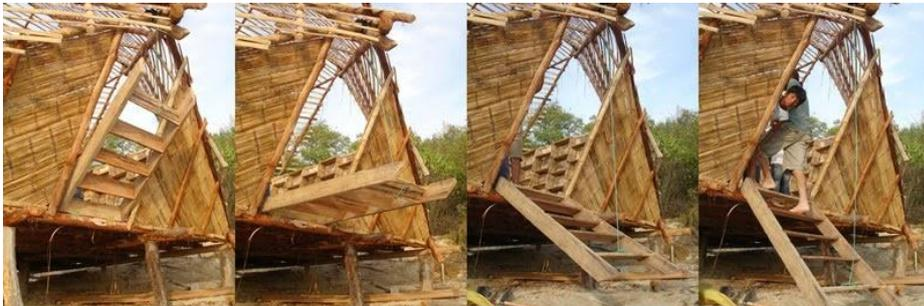
FIG.54 Detalle del funcionamiento de la escalera de "El Barco", Nueva Esperanza (2009).
