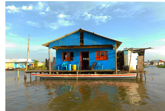
Fig 41. Fotografía de una casa típica de Nueva Venecia (2021). Fuente: Tomada por autor.
