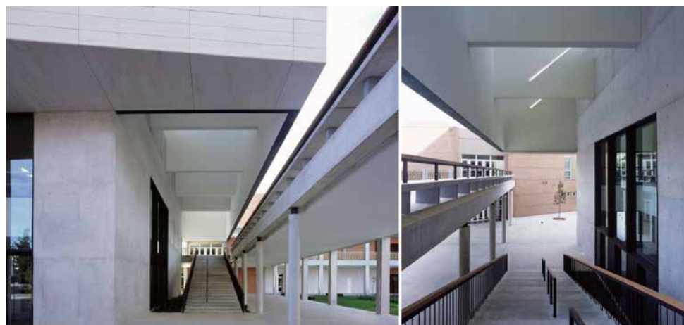
Referencia Banco con barrera de protección. Aula Magna en Gandía (Peñín Arquitectos)
