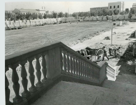
Figura 27. Obras del patio del Colegio. Imagen cedida por el Colegio.
