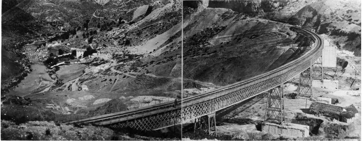
Figura 6. Viaducto del Chorro, provincia de Málaga. 300 m de luz en ocho tramos continuos sobre pilas metálicas y de fábrica. Proyecto de Antonio Arriete. Imagen de (Spreafico 1867). Patrimonio Nacional, Real Biblioteca. Signatura FOT/259
