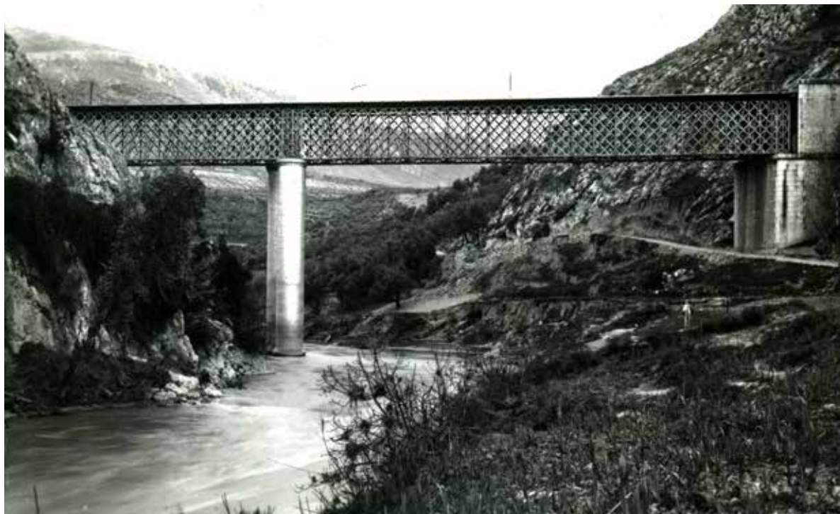
Figura 7. Puente sobre el río Genil en Loja (Puente Quebrada). Puente oblicuo de 90 m de luz en dos tramos continuos. Proyecto del ingeniero Dupuy. Postal comercial de principios del siglo XX. Colección particular del autor
