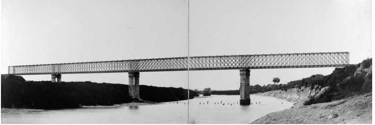
Figura 2. Viaducto del Guadalquivir, en las proximidades de Córdoba. 204 m de luz, cuatro tramos continuos sobre pilas metálicas tubulares(Spreafico 1867). Patrimonio Nacional, Real Biblioteca. Signatura FOT/259
