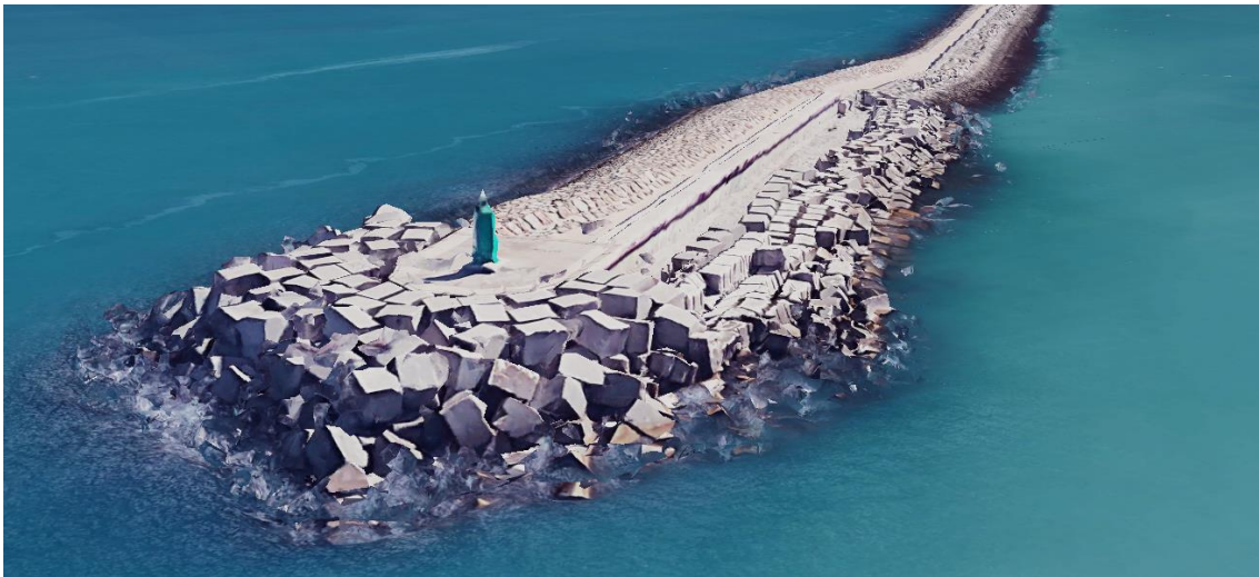
Figura 6.96. Imagen del tramo 4 del dique norte del puerto de Denia. Fuente: Google Earth
