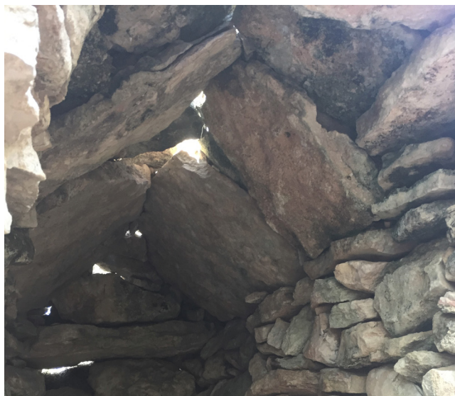
Img. 19. Cubierta vista desde interior, capa de losa
