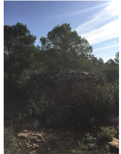
Img. 52. Vista trasera
