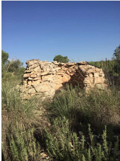
Img. 47. Imagen desde acceso
