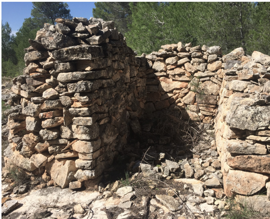
Img 38. Vista exterior hacia el acceso
