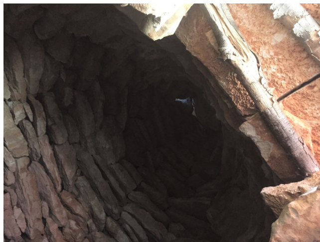
Img. 15. Cubierta vista desde el interior
