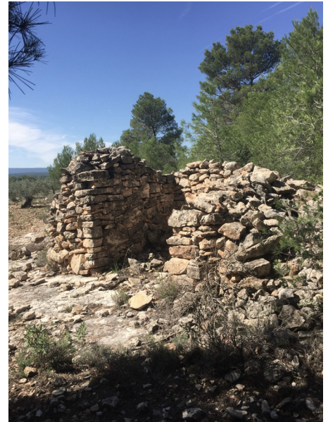
Img. 68. Vista lateral
