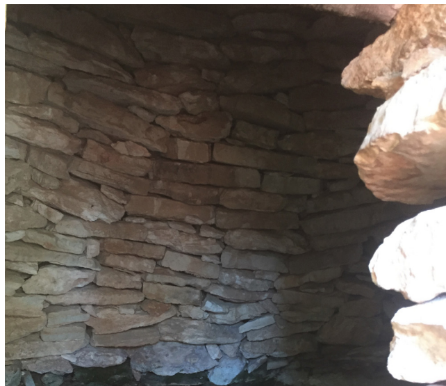
Img. 14. Muro interior, técnica de mampuestos
