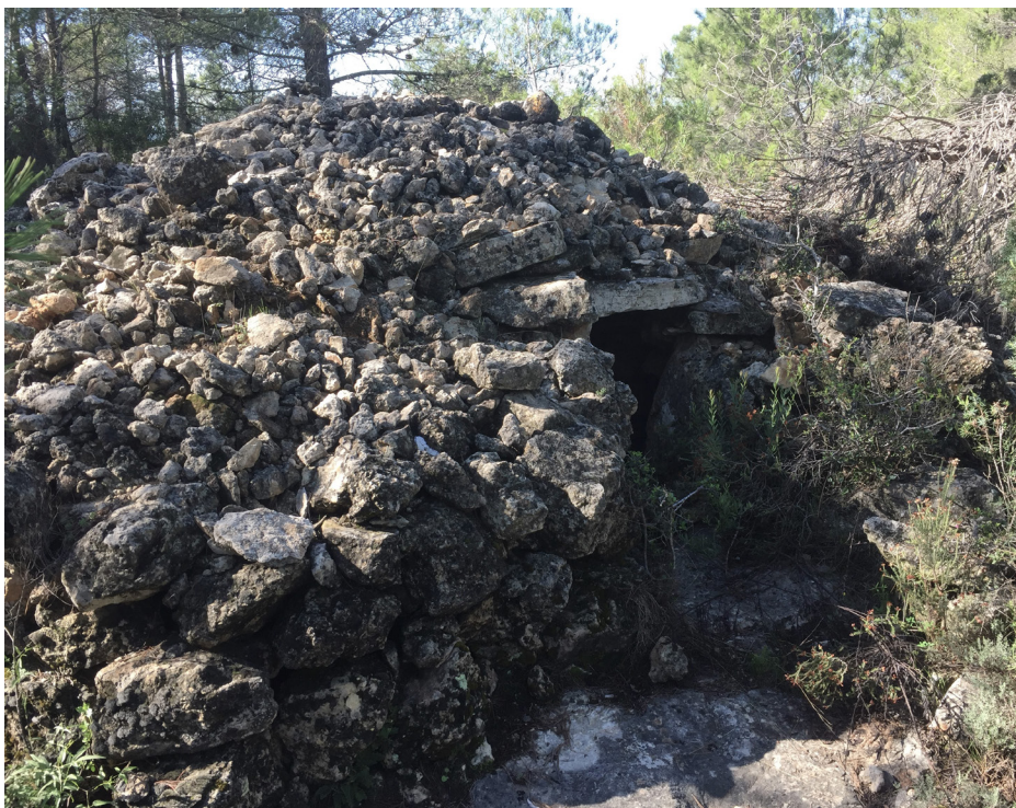
Img 30. Vista exterior hacia el acceso
