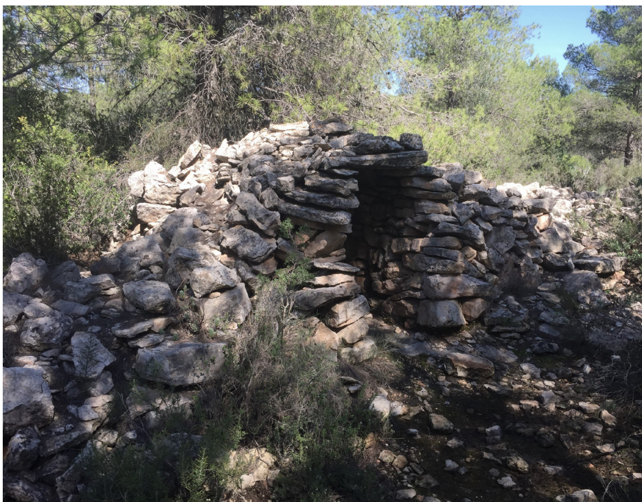
Img 36. Vista exterior hacia el acceso
