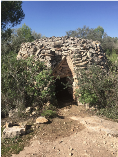
Img. 57. Imagen desde acceso
