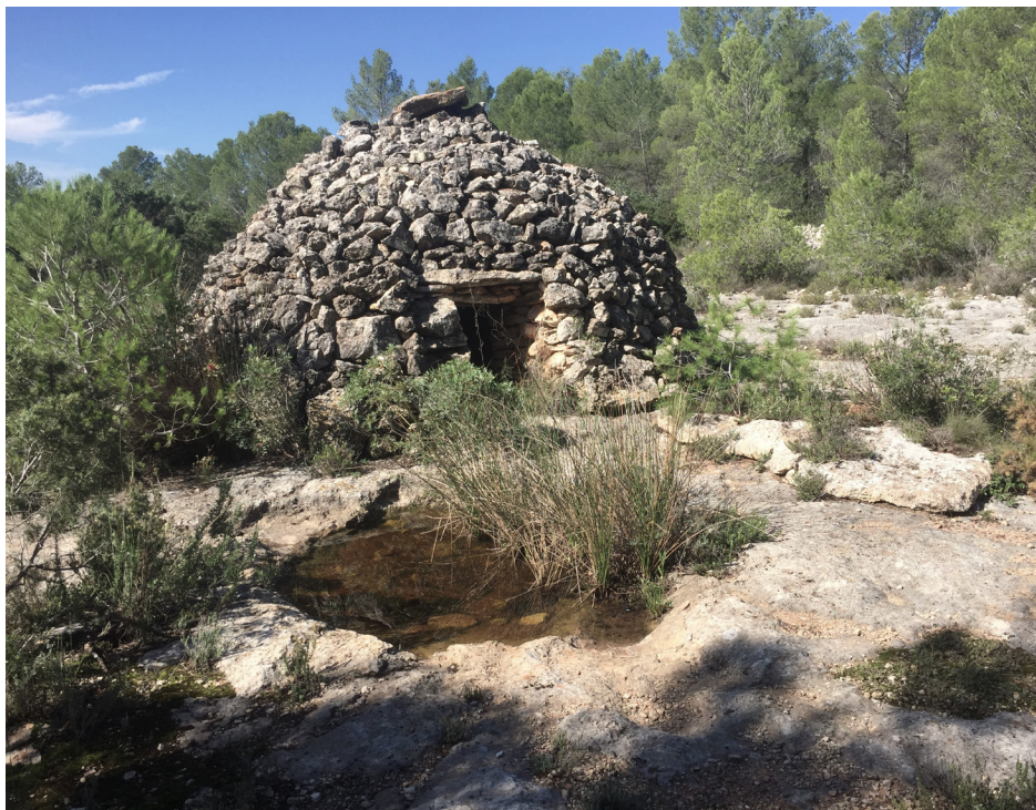
Img 34. Vista exterior hacia el acceso
