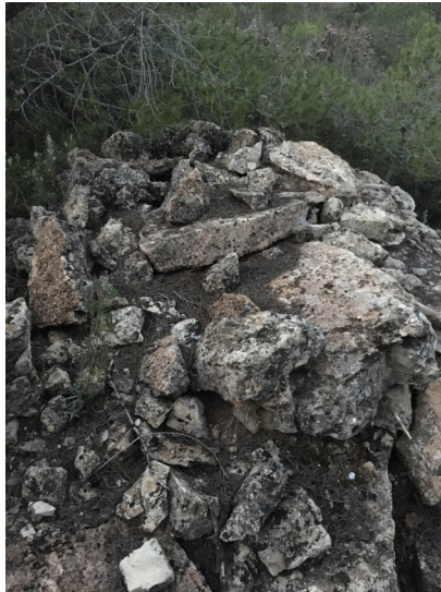
Img. 77. Vista de la cubierta
