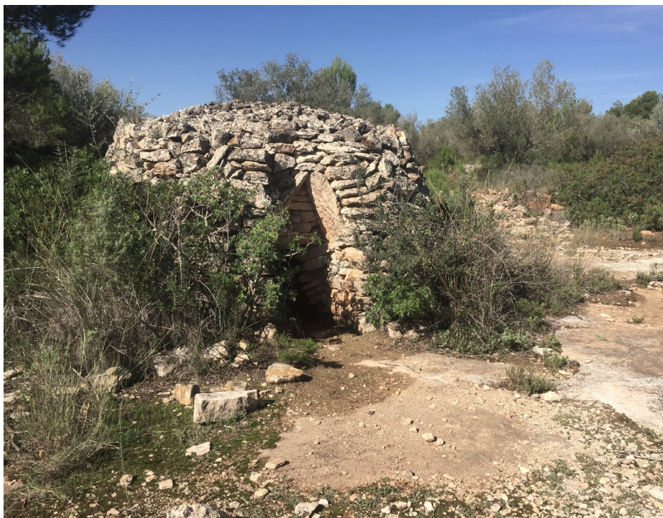
Img 32. Vista exterior hacia el acceso
