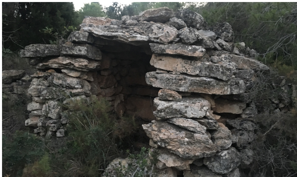
Img 44. Vista exterior hacia el acceso
