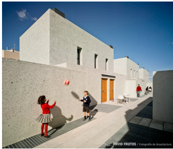
Fig. 2.4 Vista calle-cubierta elevada, tercera planta (David Frutos, 2012)
