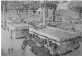
Fig. 1.7 Vista de las viviendas de hormigón armado de Tony Garnier (Desconocido, n.d)
