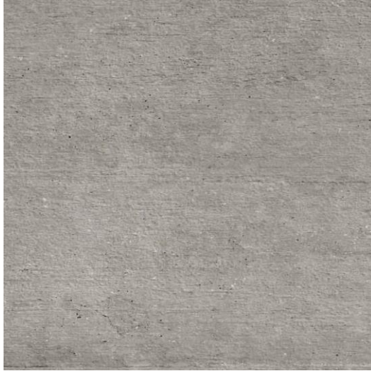
Hormigón visto con acabado rugoso.
