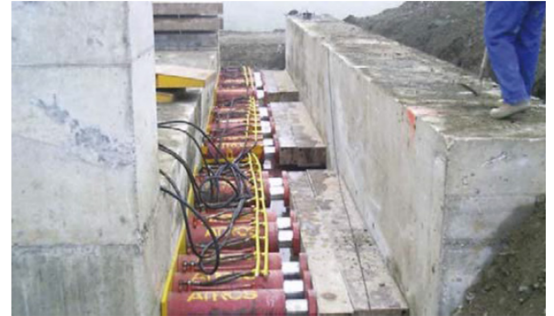
Imagen 8.0.1 Situación de los gatos hidráulicos al inicio del empuje (Tesis de Felicidad Minguez)
