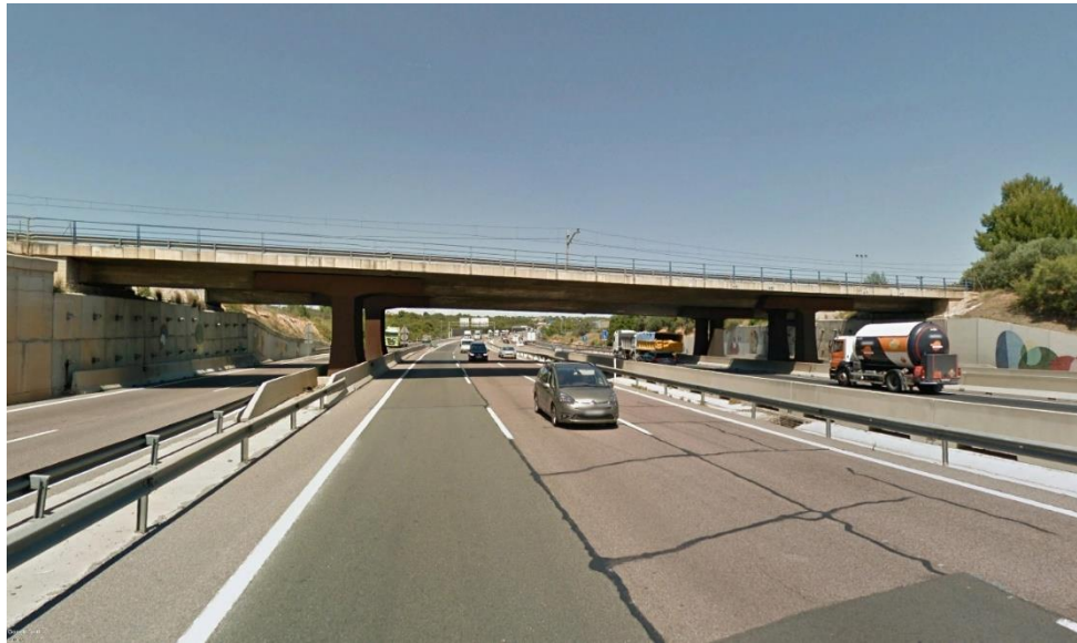
Ilustración 7. Vista pilas de los pasos superiores actuales (Fuente: Google Earth).
