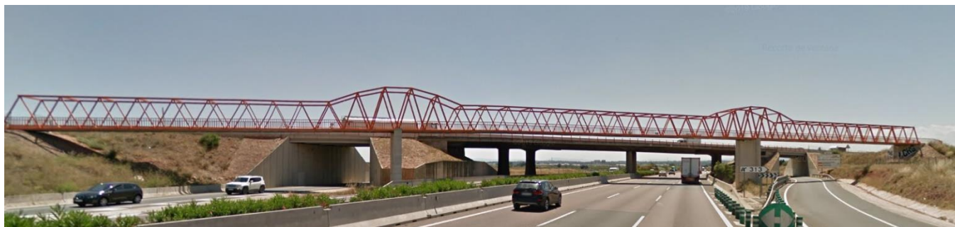
Ilustración 12. Pasarela existente al lado de la CV-32 sobre la A7 (Fuente: Google Earth).
