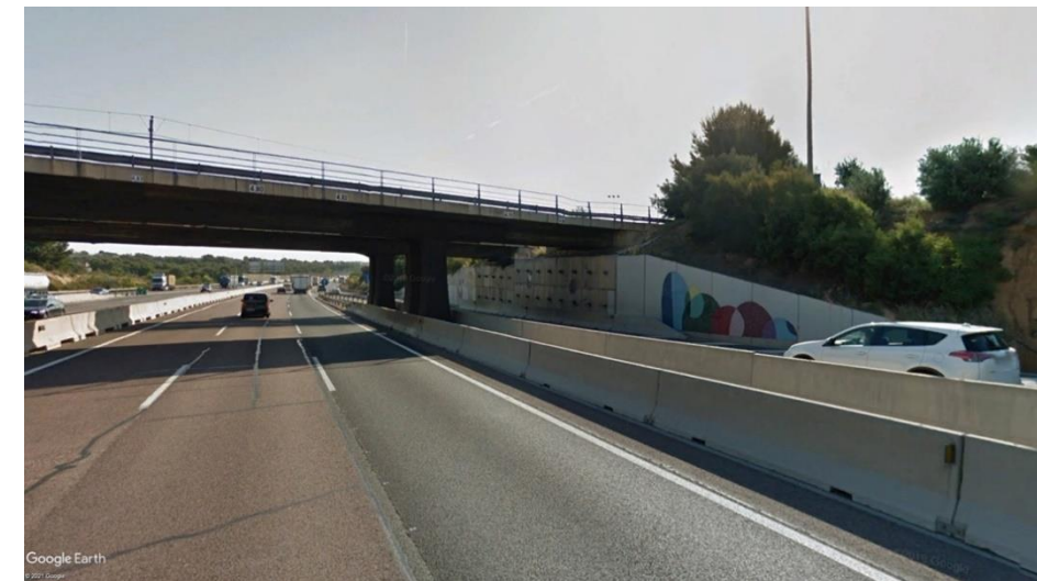
Ilustración 2. Muro de hormigón actual (Fuente: Google Earth)
