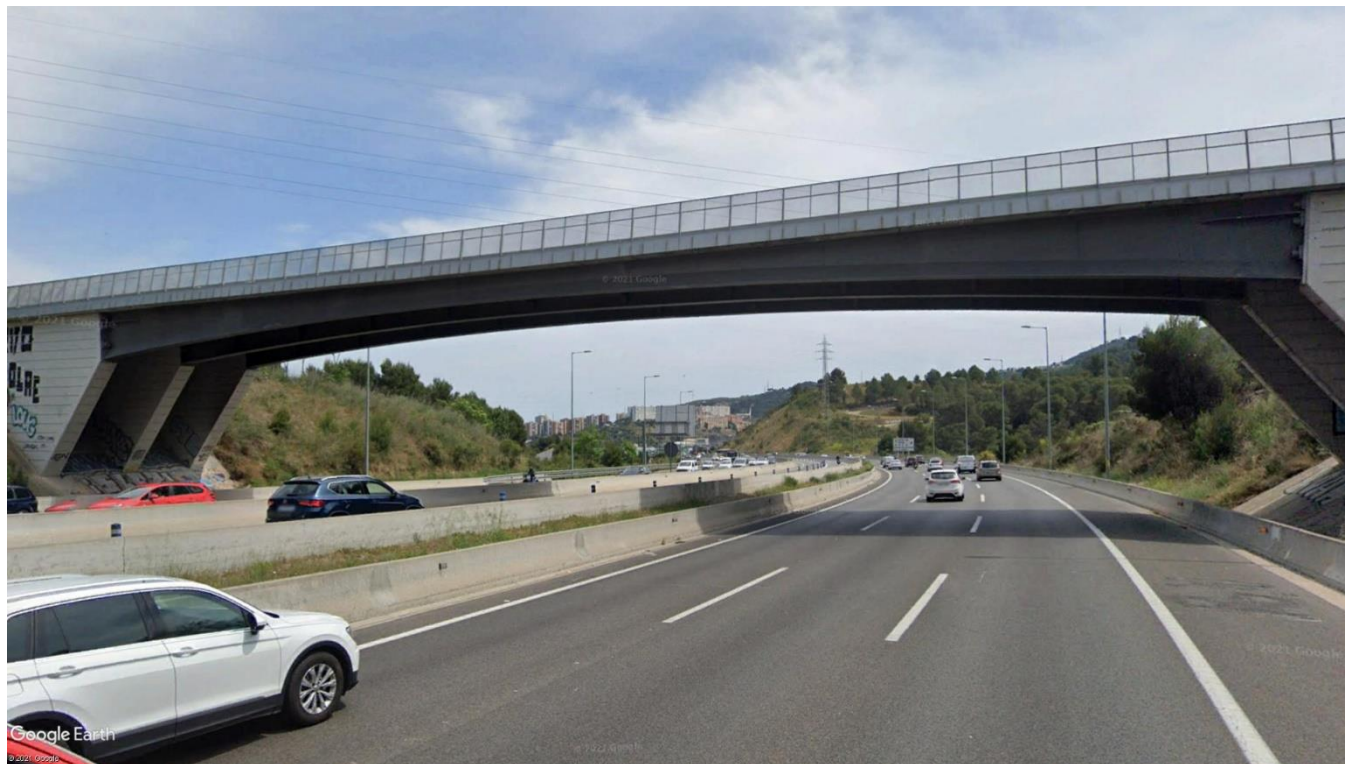
Ilustración 5. Puente de vigas de acero (FUENTE: Google Earth).
