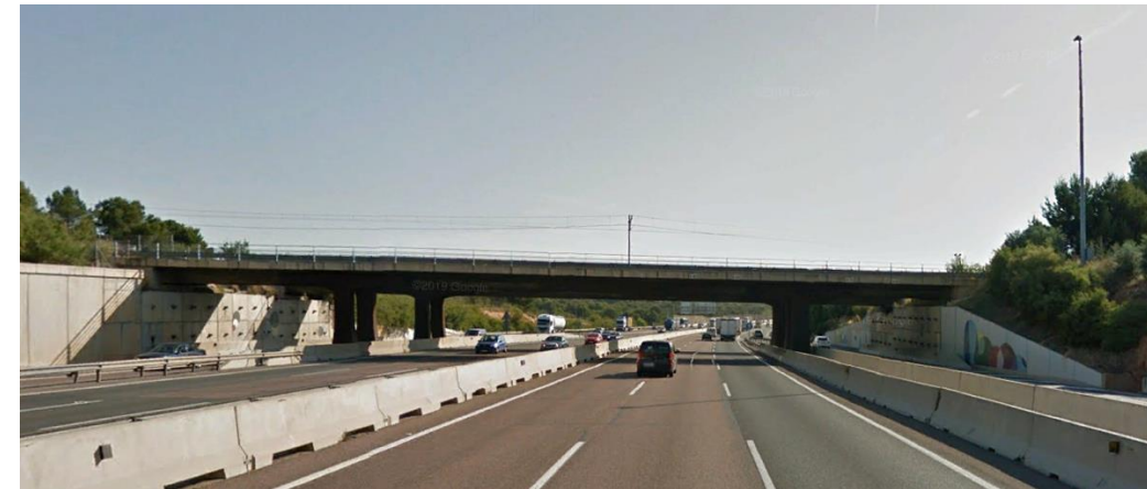
Ilustración 2. Situación actual de los pasos superiores (Fuente: Google Earth).
