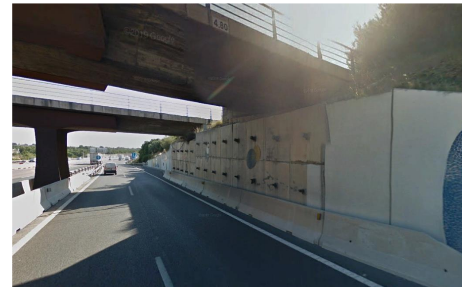
Ilustración 3. Paneles de hormigón en márgenes (Fuente: Google Earth).
